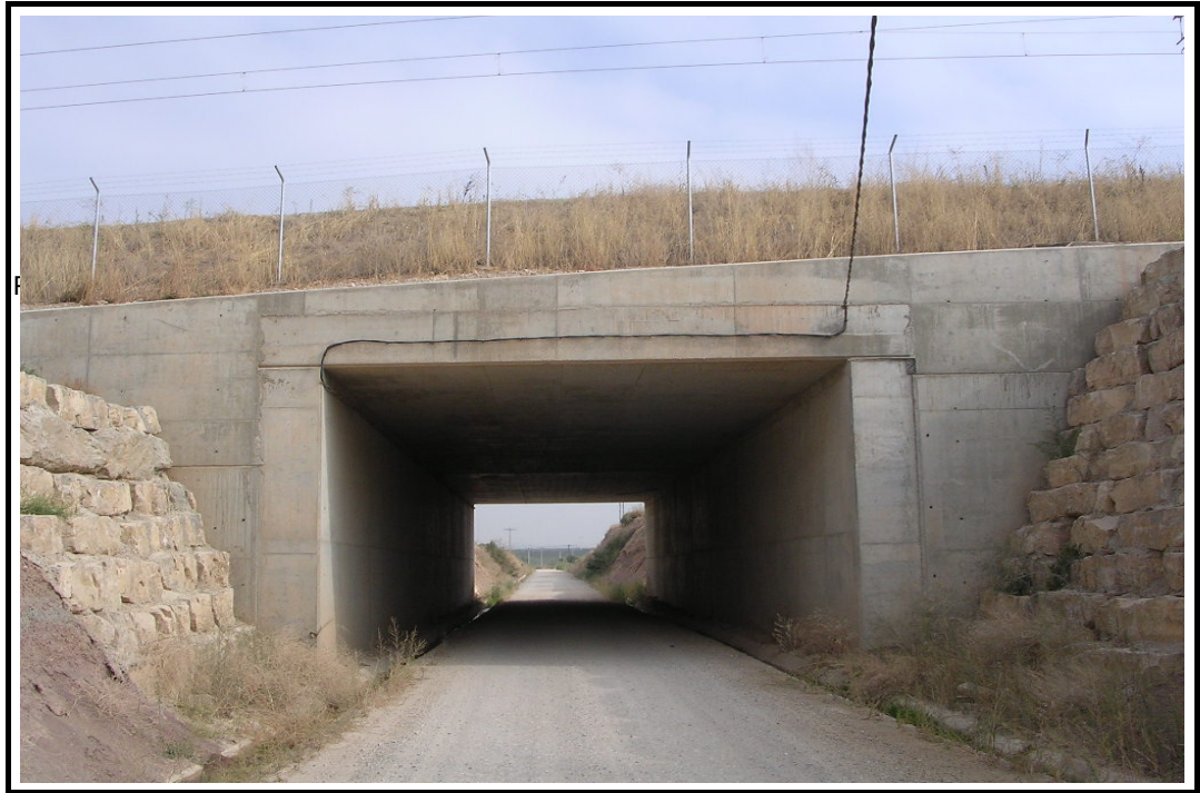
Foto 1: Vista general de la estructura
