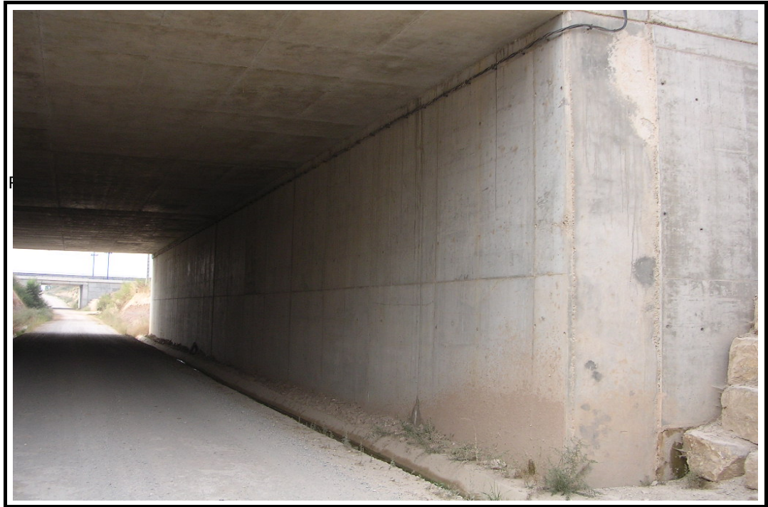
Foto 5: Vista de estribo
