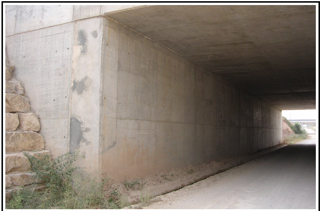
Foto 6: Vista de estribo
