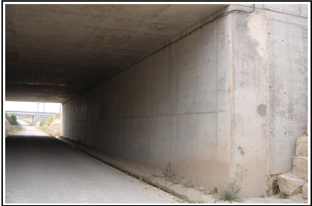
Foto 7: Estribo de entrada
