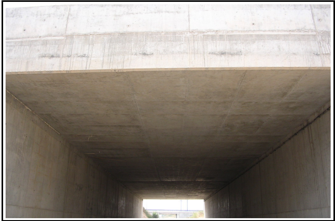
Foto 9: Vista inferior de la estructura
