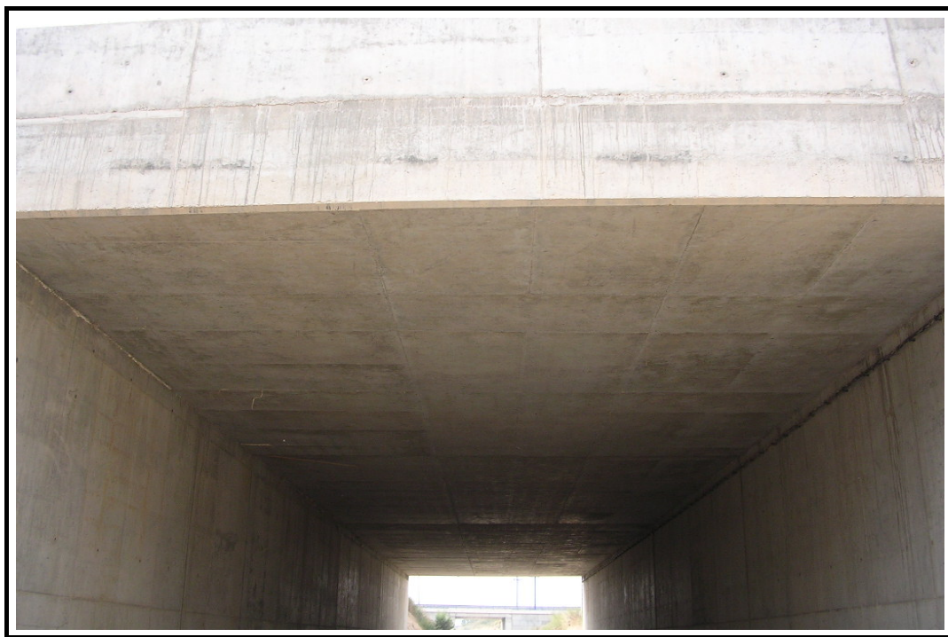
Foto 4: Vista inferior del tablero
