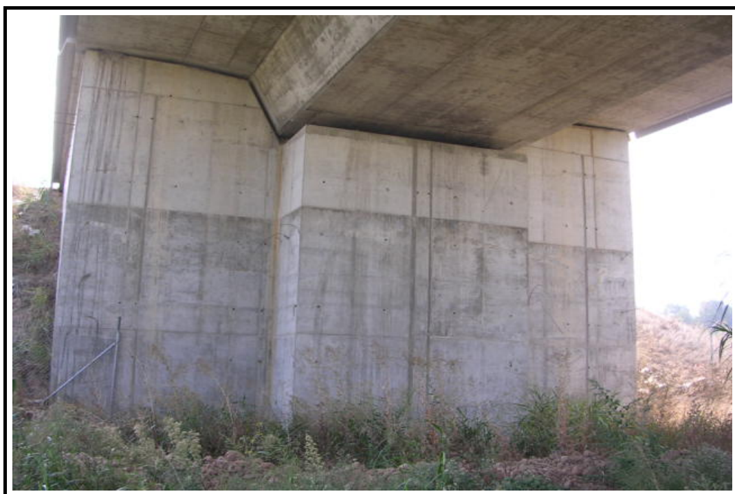
Foto 6: Estribo de salida
