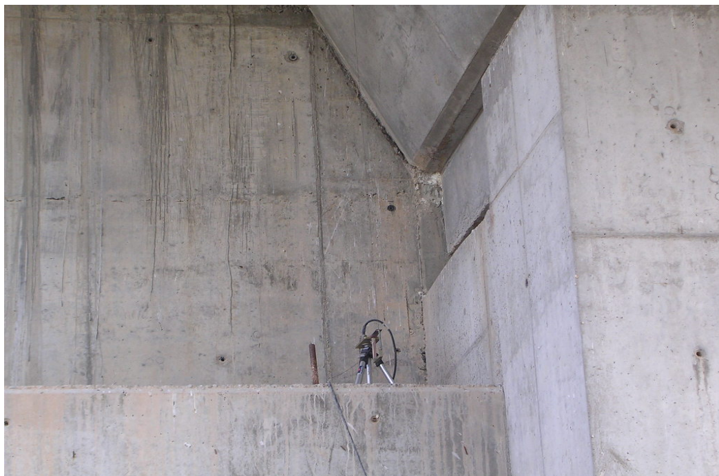
Foto 10: Ménsula para la medida de descenso de apoyo en estribo
