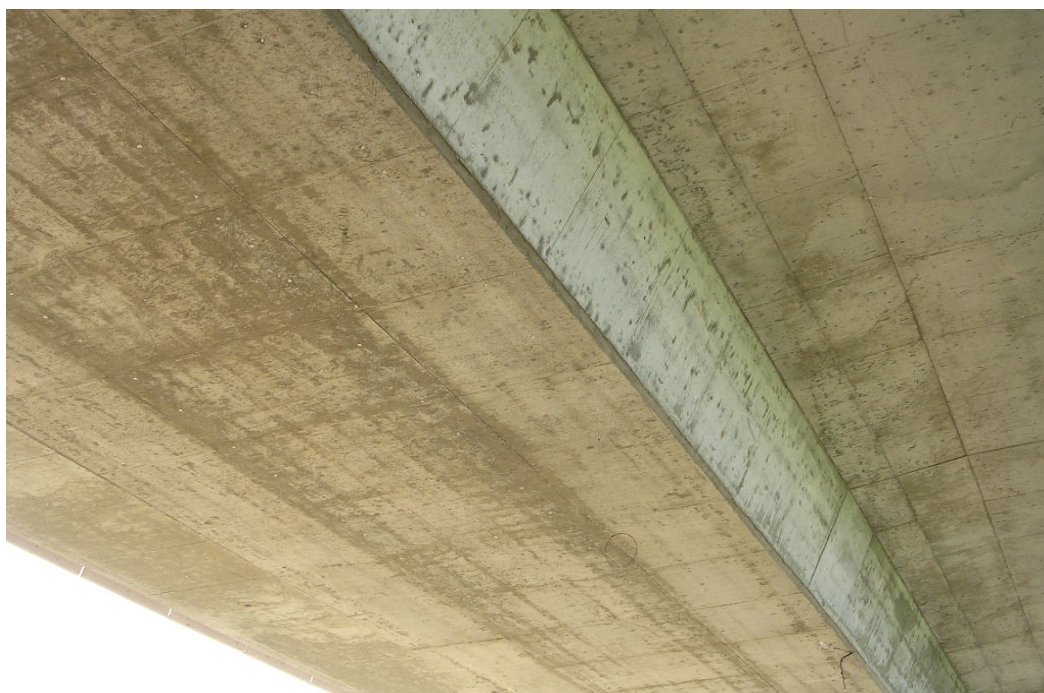
Foto 8: Vista inferior de la estructura
