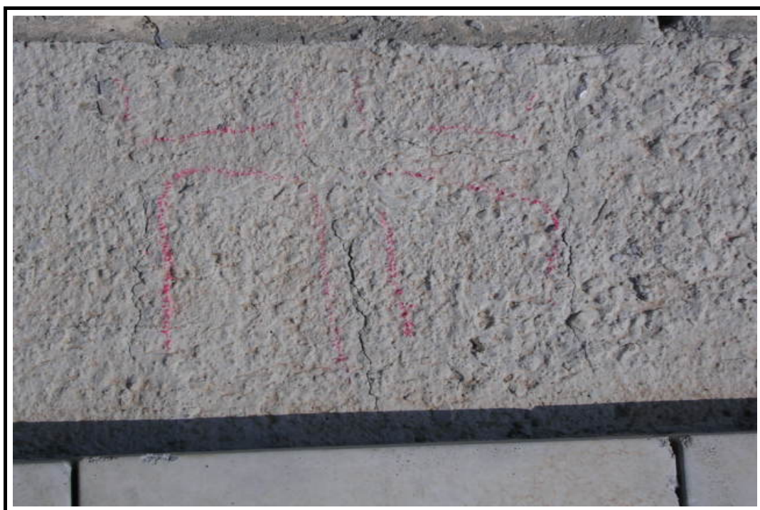
Foto 14: Fisuración generalizada en aceras
