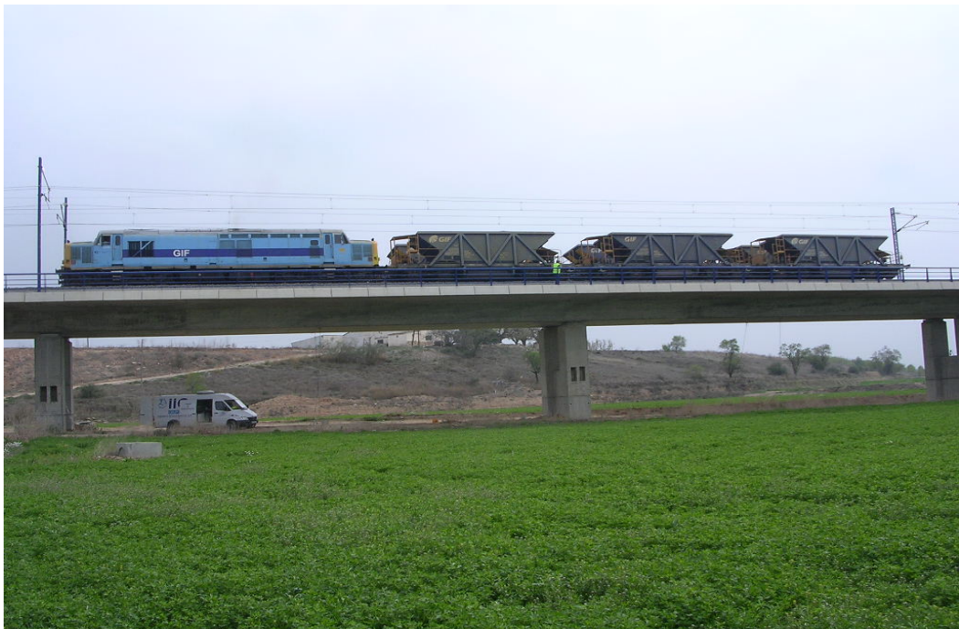
Foto 15: Posicionamiento de sobrecargas. Vista lateral
