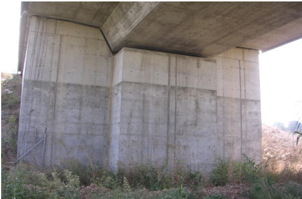
Foto 4: Estribo de salida
