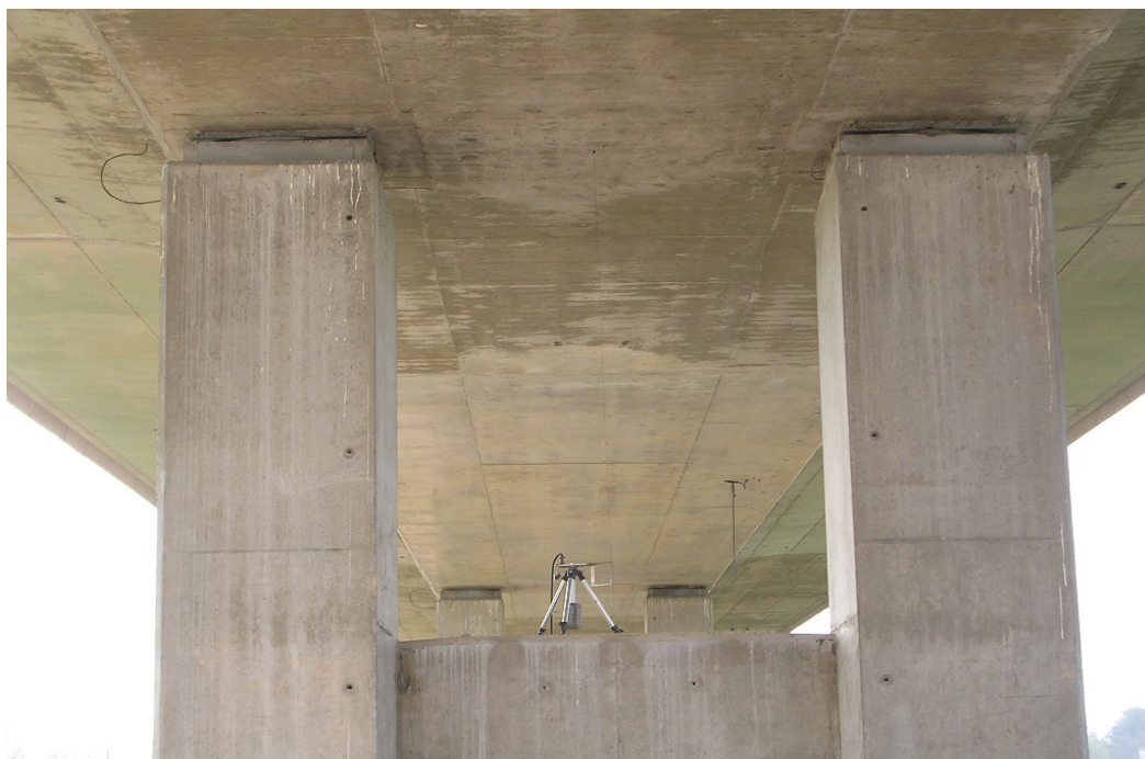
Foto 11: Ménsula para la medida de descenso de apoyo en pila
