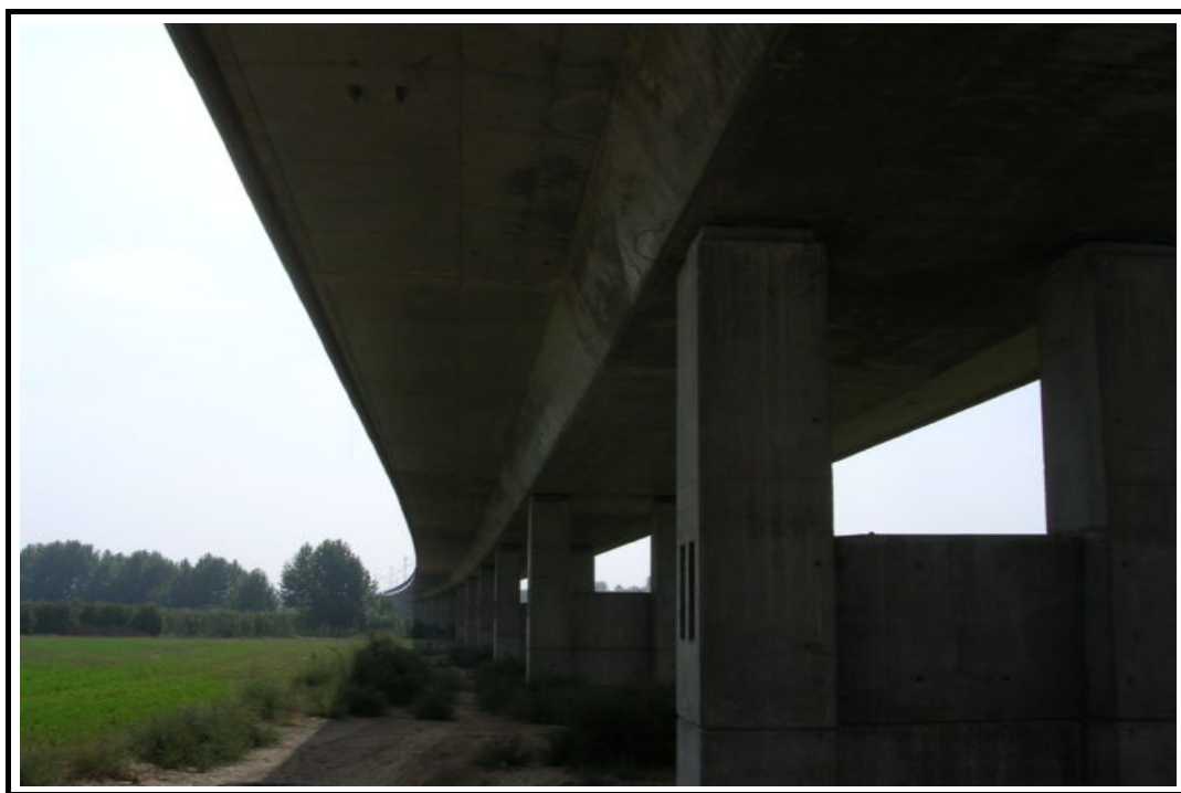
Foto 7: Vista inferior de la estructura
