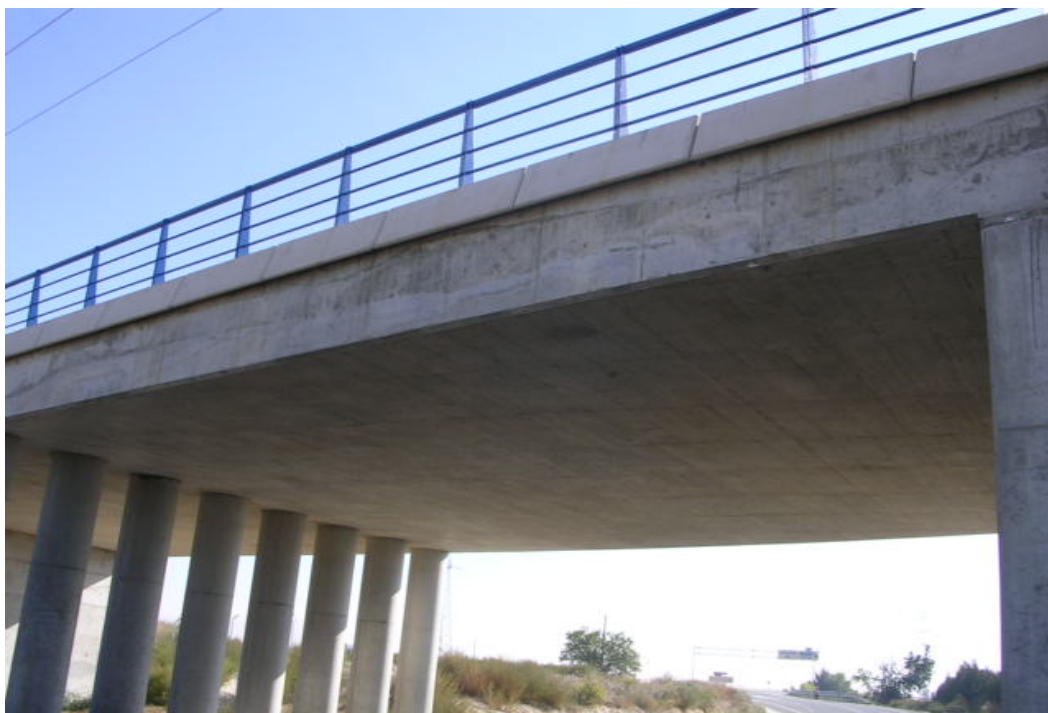
Foto 9: Vista inferior de la estructura
