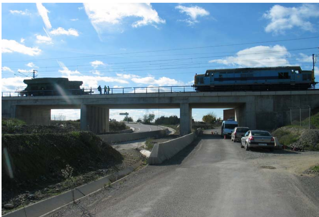
Foto 14: Posicionamiento de sobrecargas. Vista lateral
