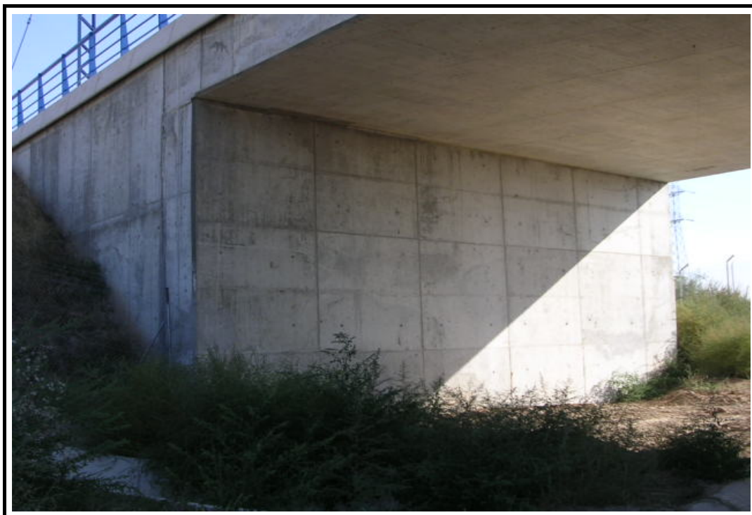
Foto 7: Estribo de salida
