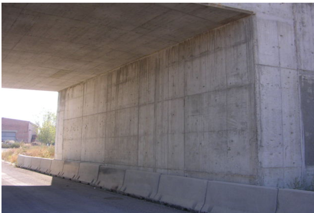
Foto 4: Estribo de salida
