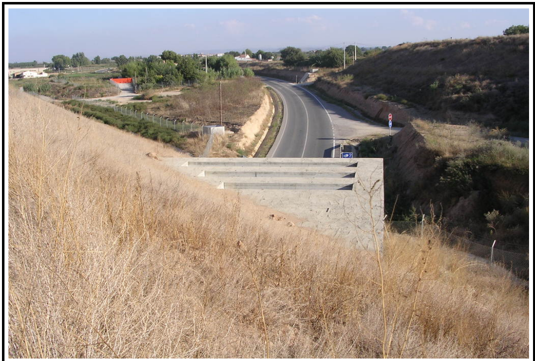
Foto 8: Vista superior desde entrada
