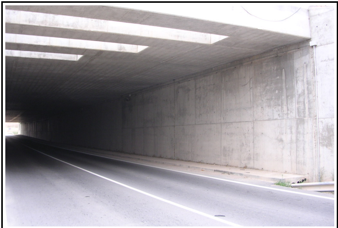
Foto 4: Estribo de entrada
