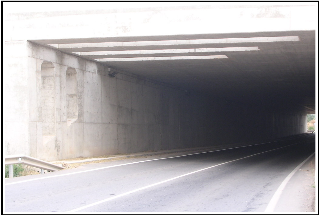
Foto 5: Estribo de entrada
