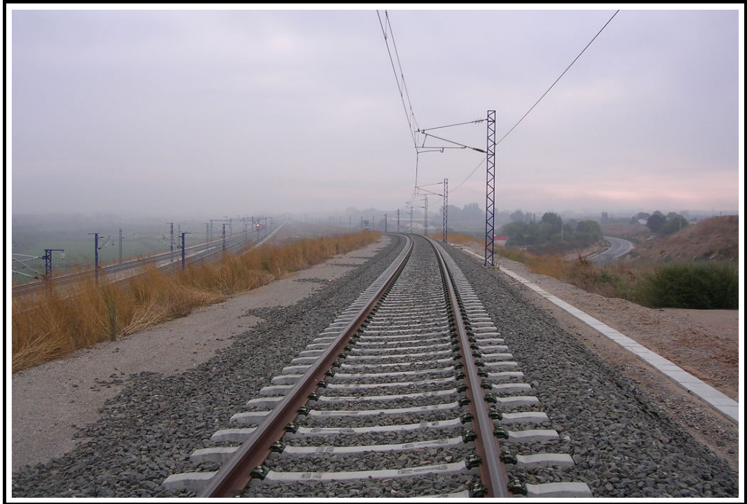
Foto 9: Vista superior desde entrada
