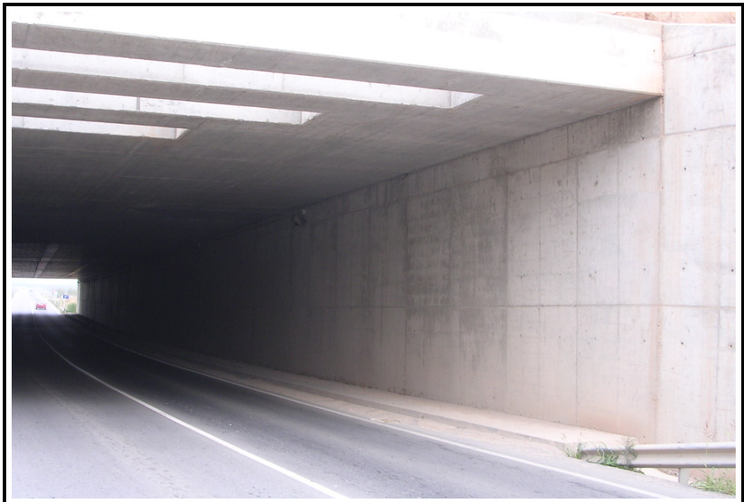
Foto 6: Estribo de salida
