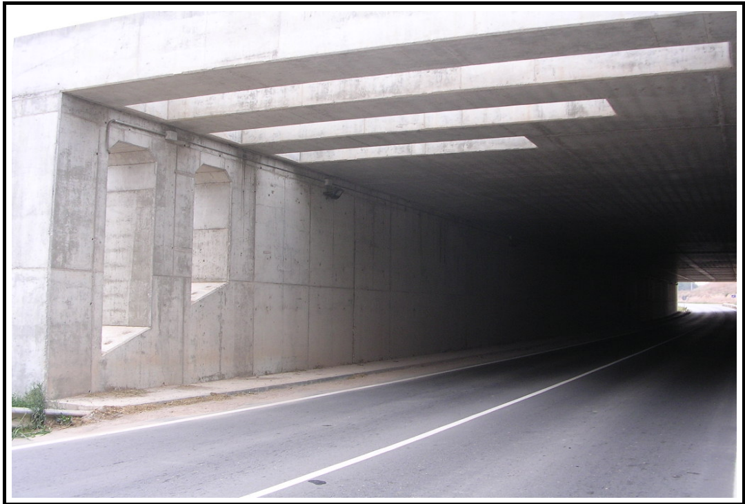
Foto 7: Estribo de salida
