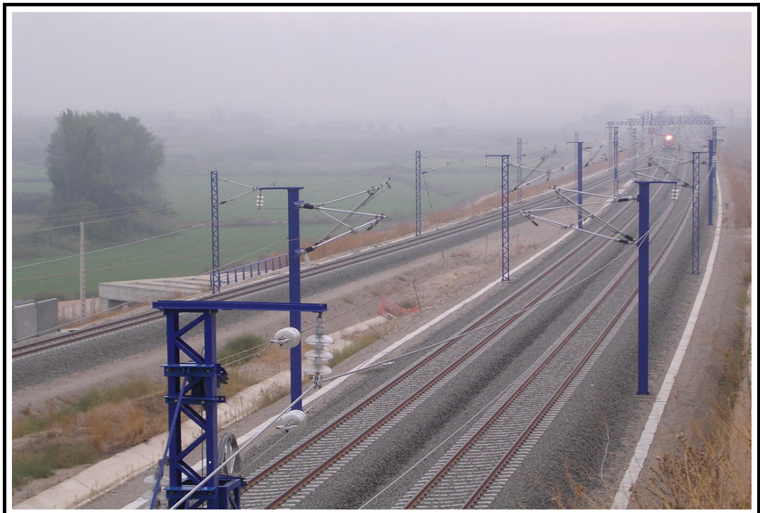
Foto 10: Vista superior desde entrada
