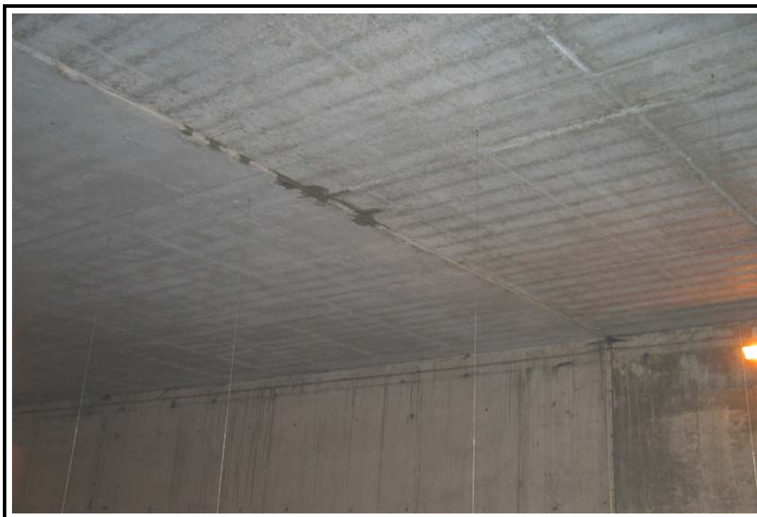
Foto 2: Vista inferior del tablero
