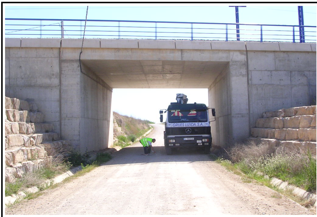
Foto 1: Vista general de la estructura
