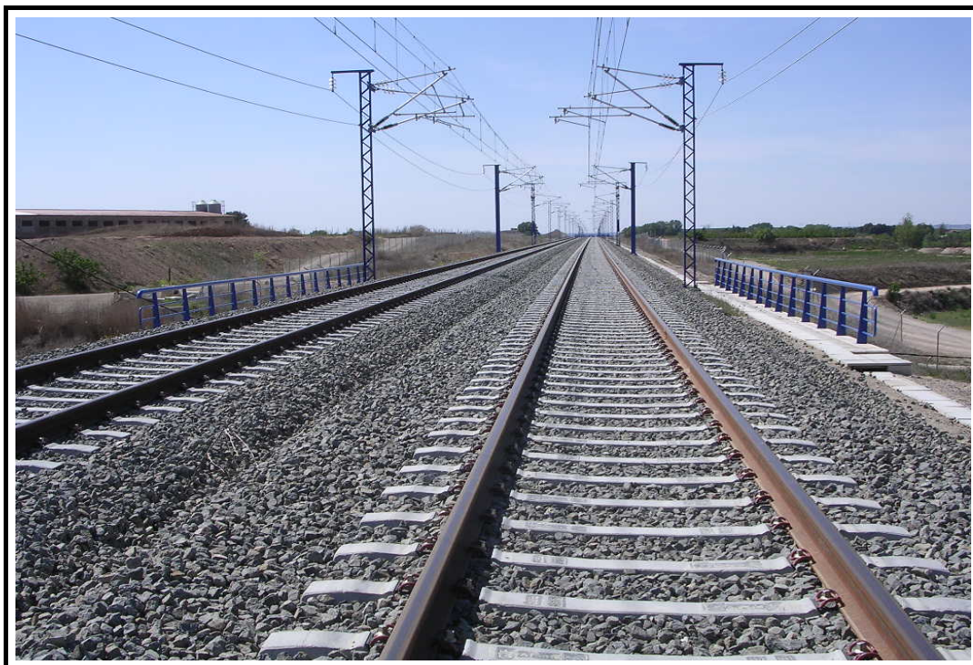
Foto 2: Vista superior del tablero
