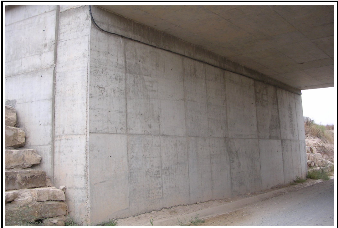
Foto 5: Estribo de salida
