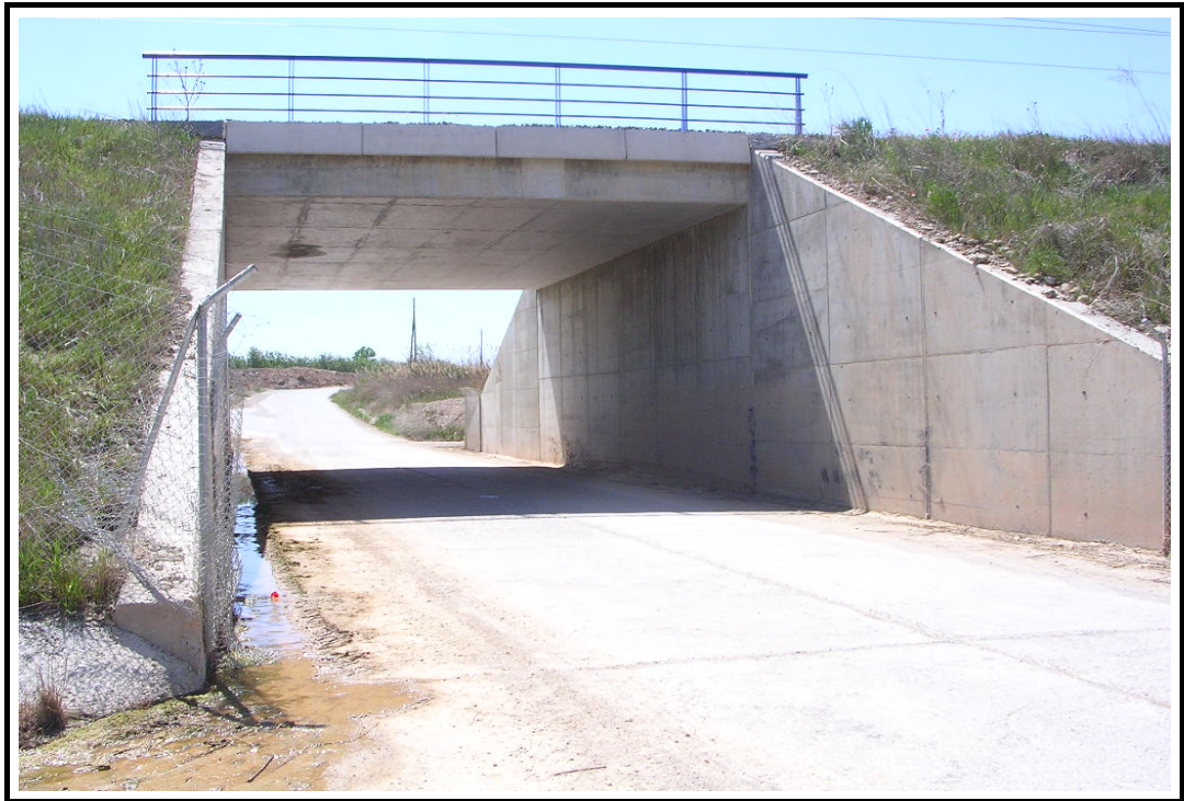
Foto 1: Vista general de la estructura
