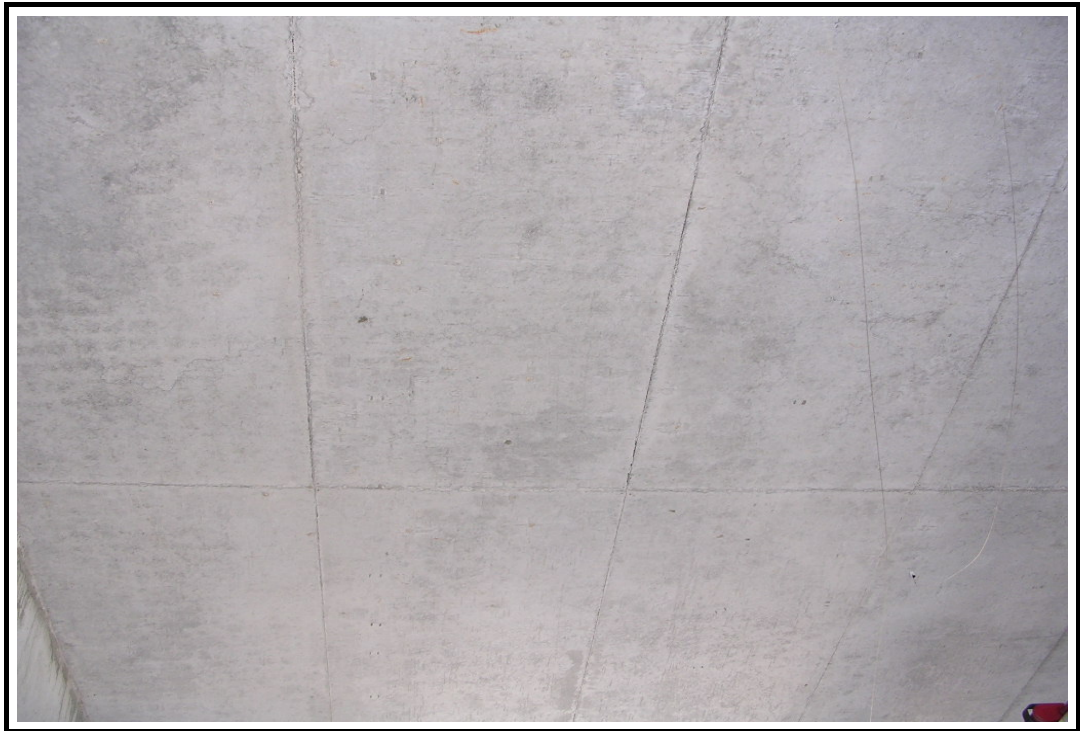
Foto 3: Vista inferior de la estructura
