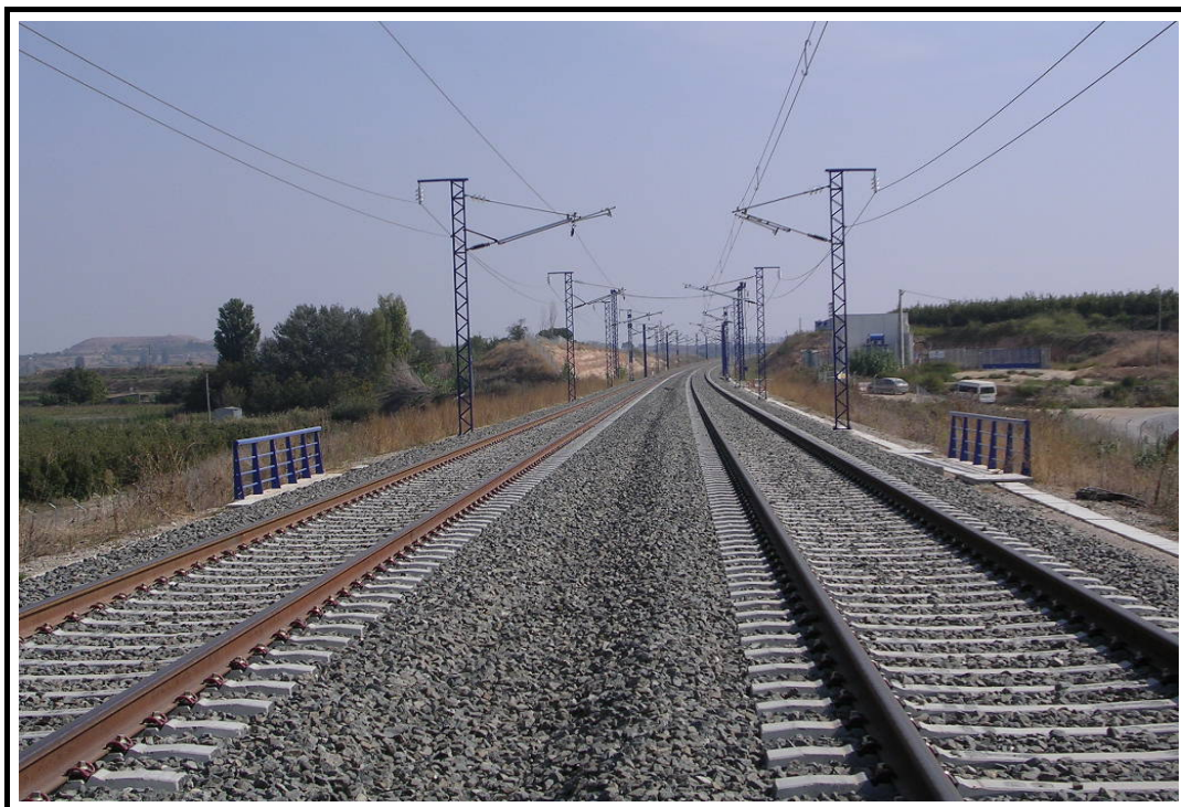
Foto 6: Vista superior desde entrada
