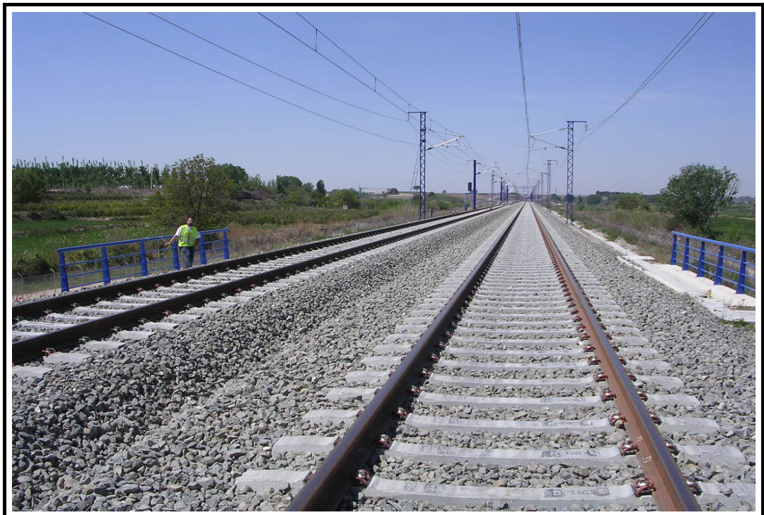
Foto 2: Vista superior de la estructura
