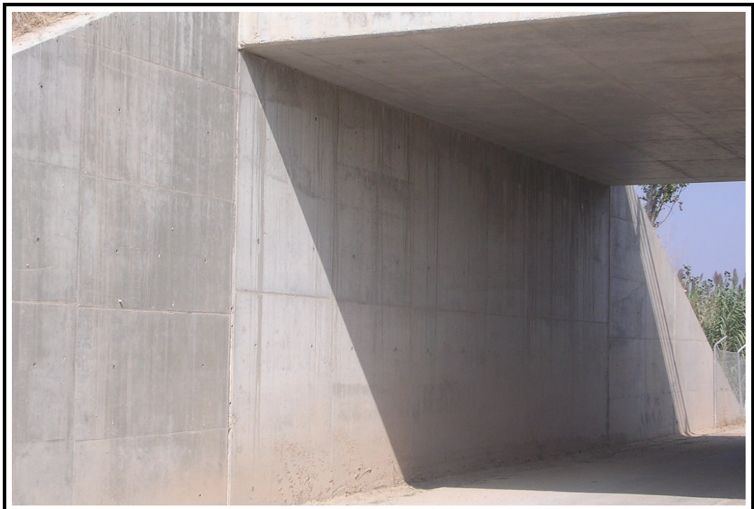
Foto 4: Estribo de entrada
