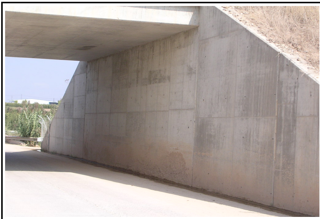
Foto 5: Estribo de salida
