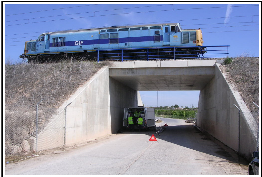
Foto 5: Vista lateral de prueba estática
