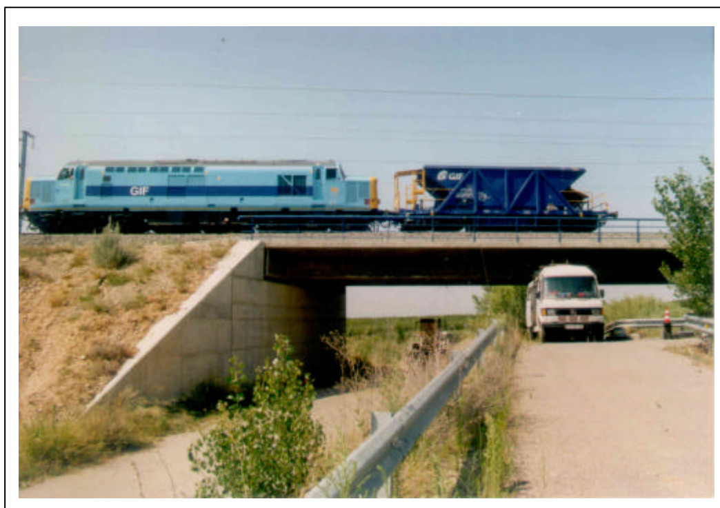
FOTOGRAFÍA 10: Tren de cargas sobre la estructura
