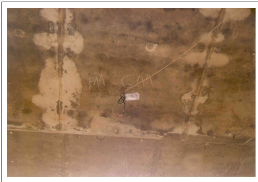
FOTOGRAFÍA 9: Galga extensométrica en centro de vano.
