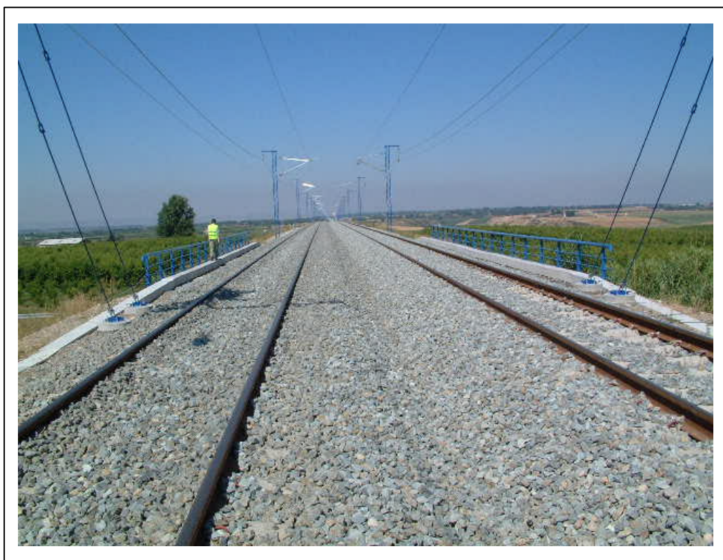
FOTOGRAFÍA 2: Vista superior del tablero
