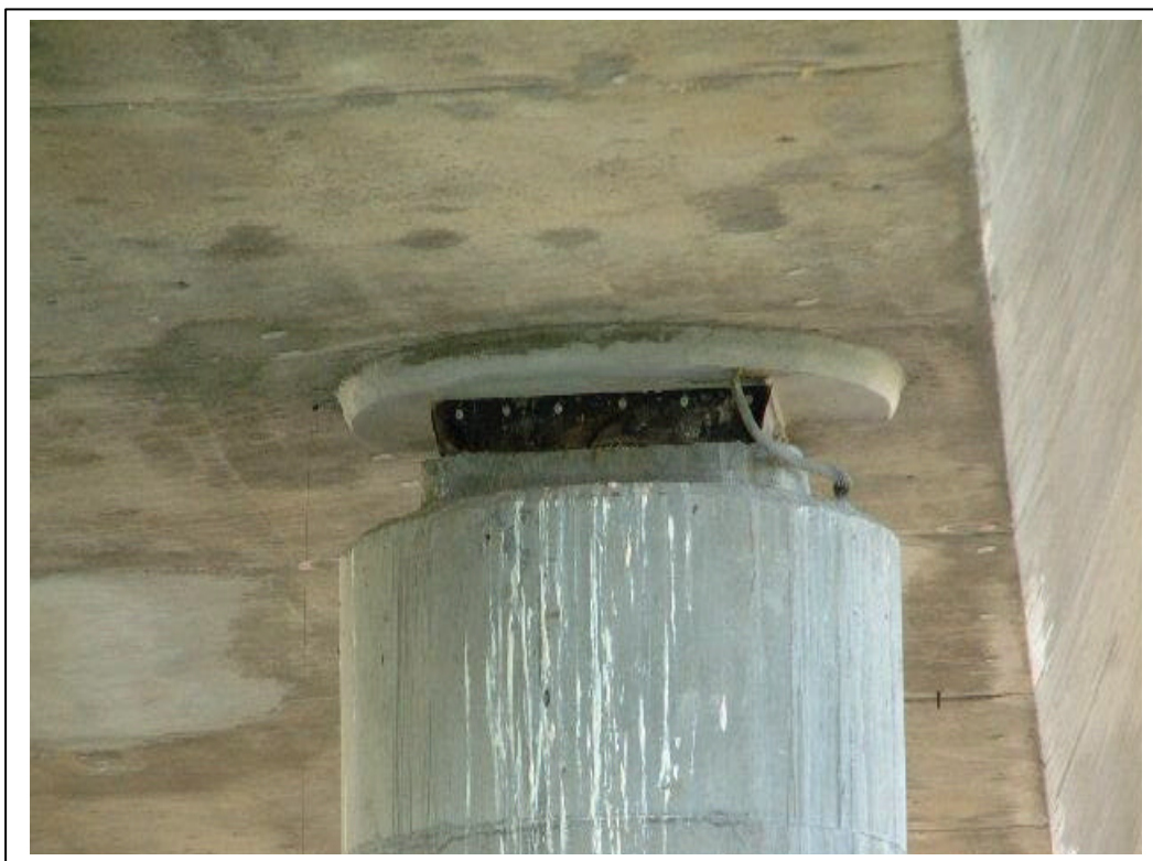
FOTOGRAFÍA Nº 9: DETALLE APOYO EN EL FUSTE IZQUIERDO
