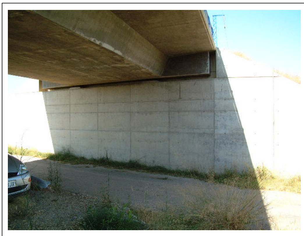
FOTOGRAFÍA 4: Vista de estribo y aleta
