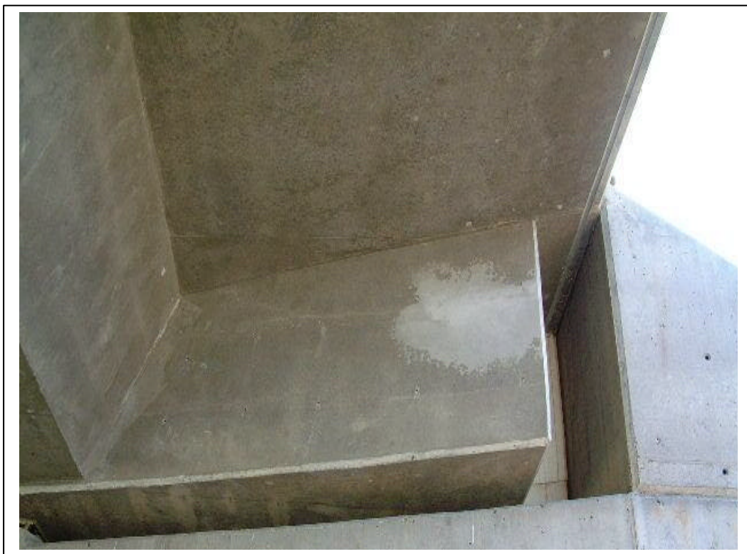
FOTOGRAFÍA N° 8: VIGA RIOSTRA DE APOYO SOBRE EL ESTRIBO DE SALIDA LD.
