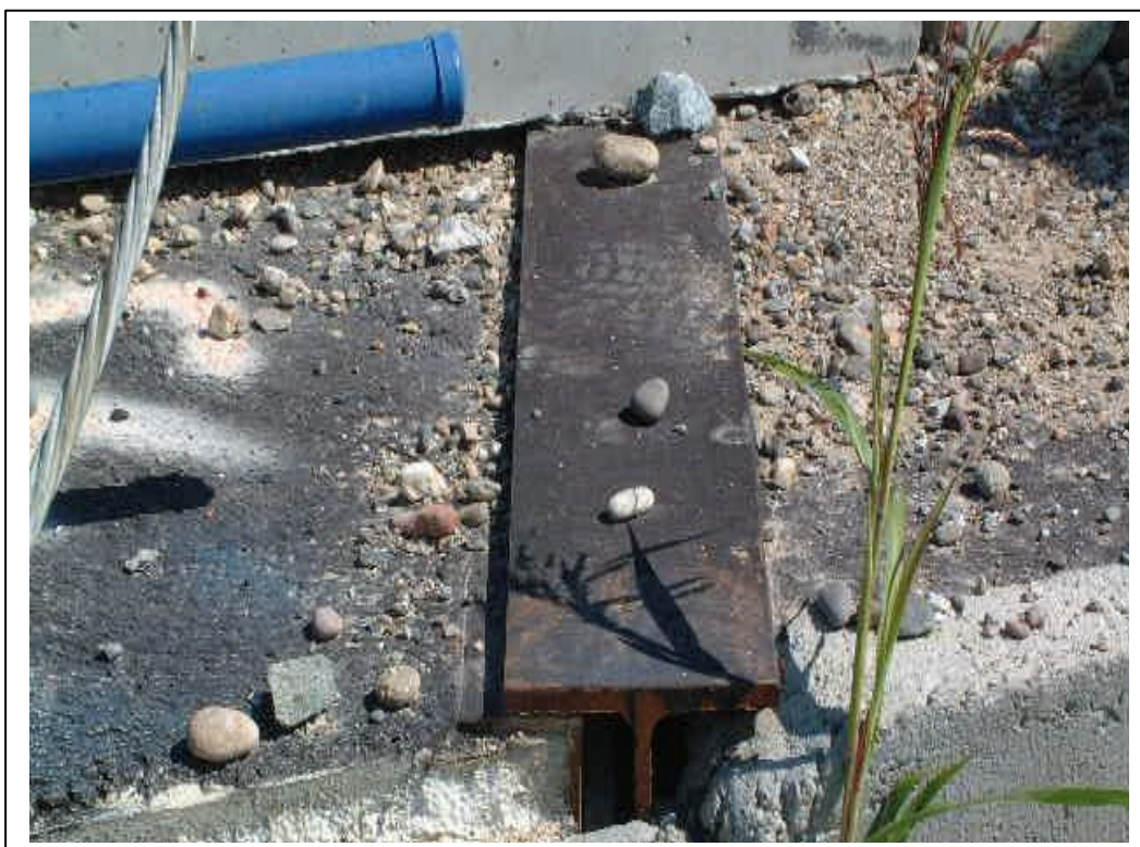
FOTOGRAFÍA Nº 10: DETALLE CUBRE JUNTAS
