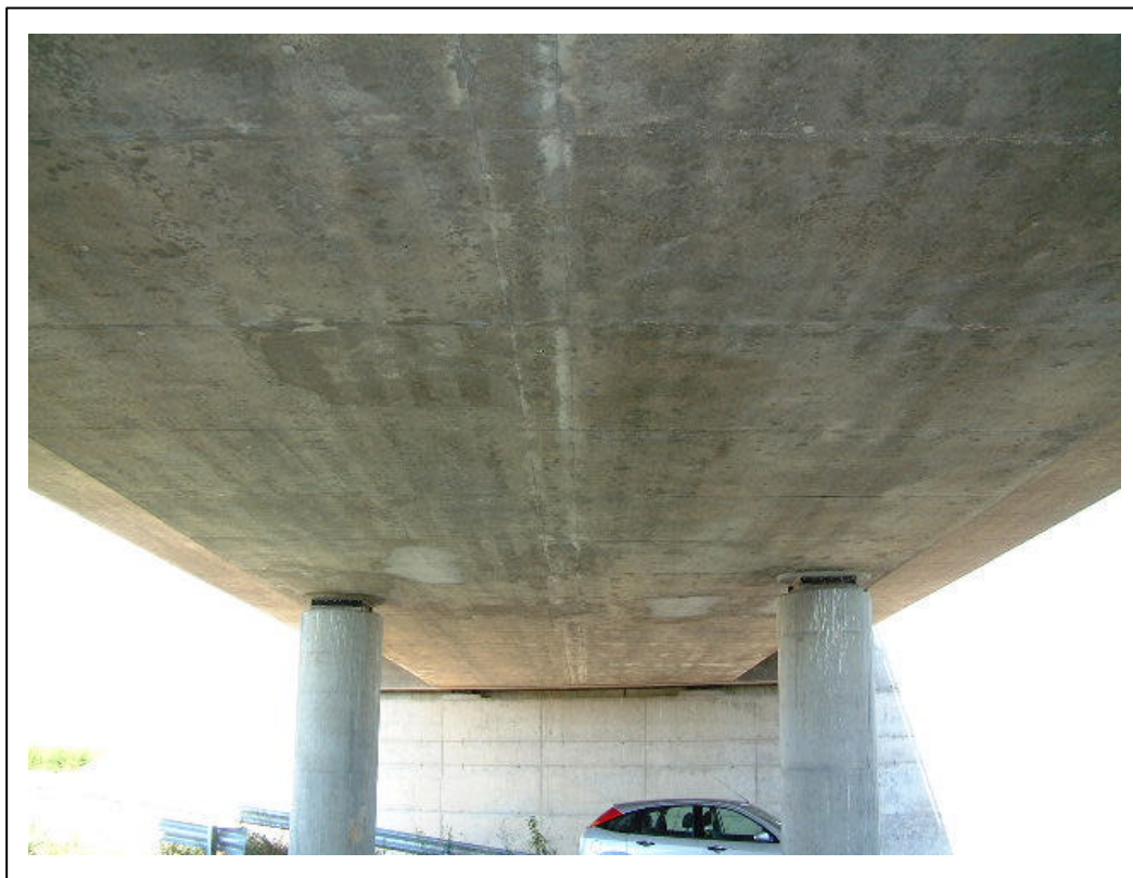
FOTOGRAFÍA 3: Vista inferior del tablero
