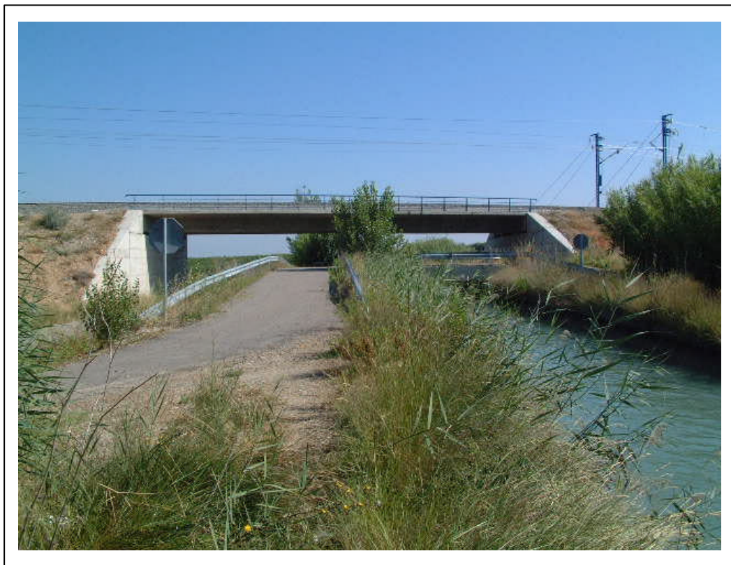
FOTOGRAFÍA 1: Vista general del puente
