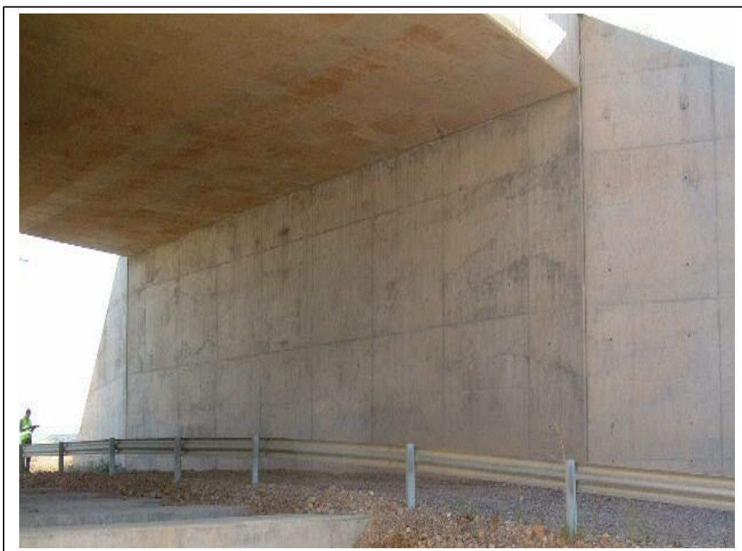
FOTOGRAFÍA Nº 6: ESTRIBO DE SALIDA
