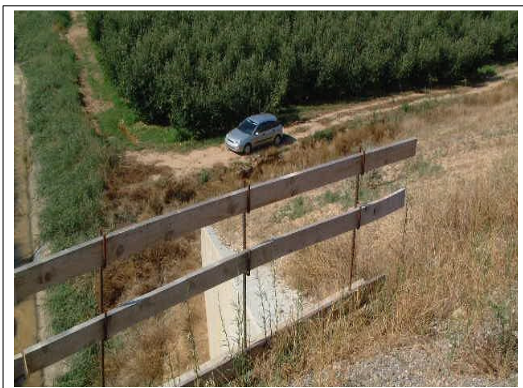
FOTOGRAFÍA Nº 10: DETALLE BARANDILLA EN EL LADO DERECHO
