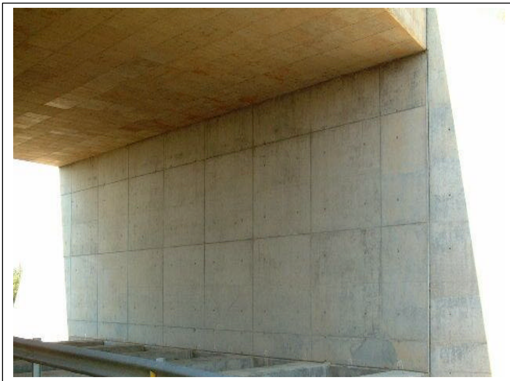
FOTOGRAFÍA Nº 5: ESTRIBO DE ENTRADA
