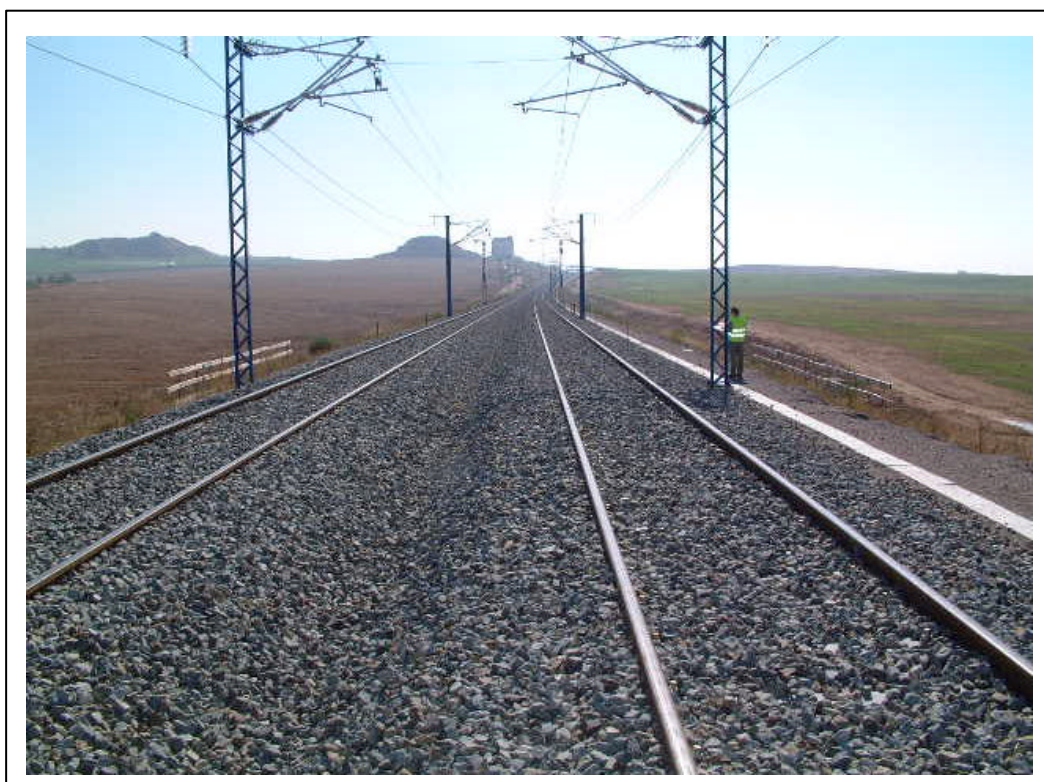
FOTOGRAFÍA 2: Vista superior del tablero
