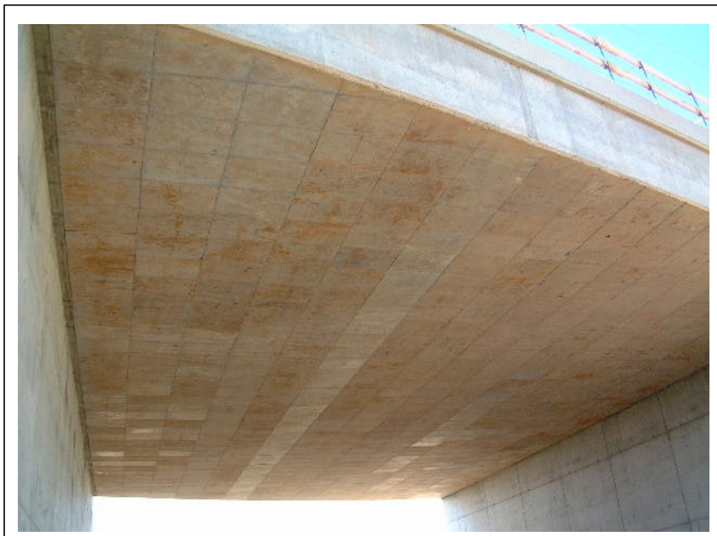
FOTOGRAFÍA 3: Vista inferior del tablero
