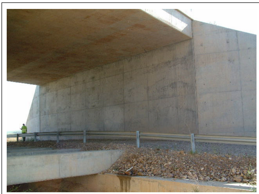
FOTOGRAFÍA 4: Vista de estribo y aleta
