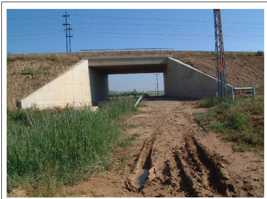
FOTOGRAFÍA 1: Vista general del puente
