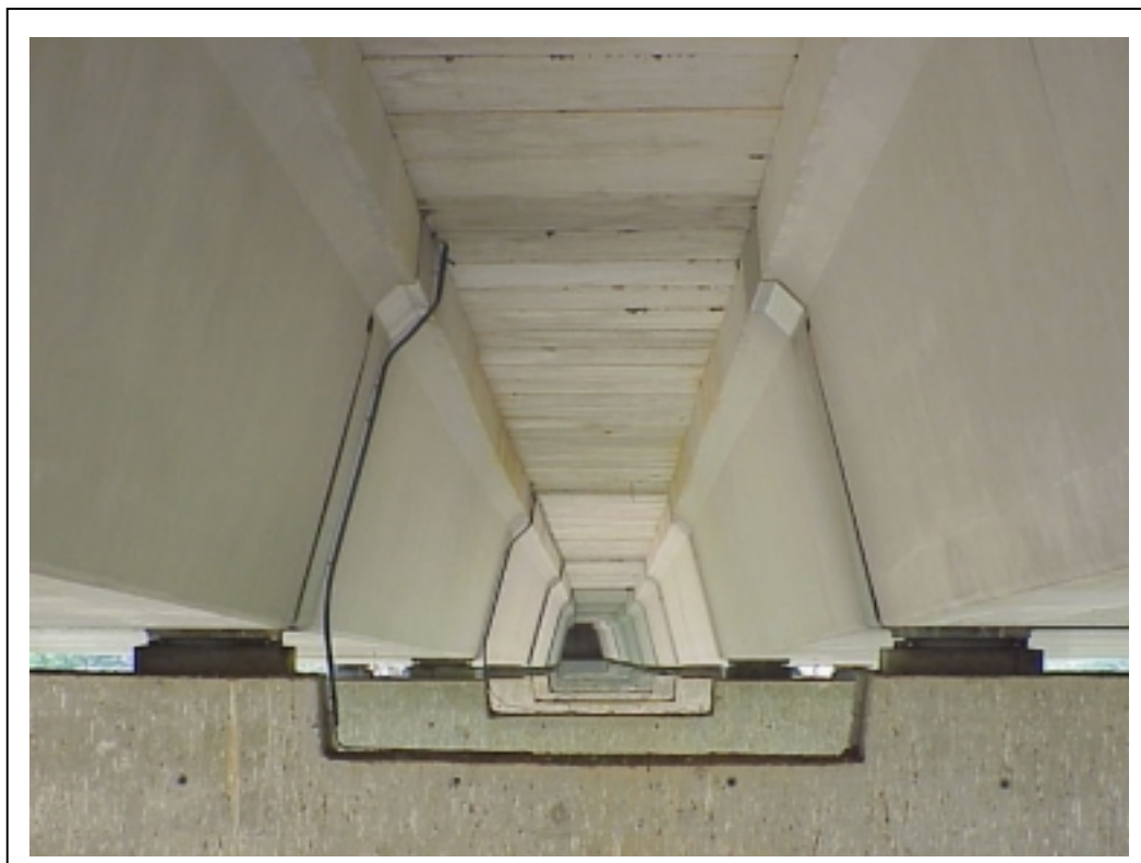
FOTOGRAFÍA 3: Vista inferior del tablero
