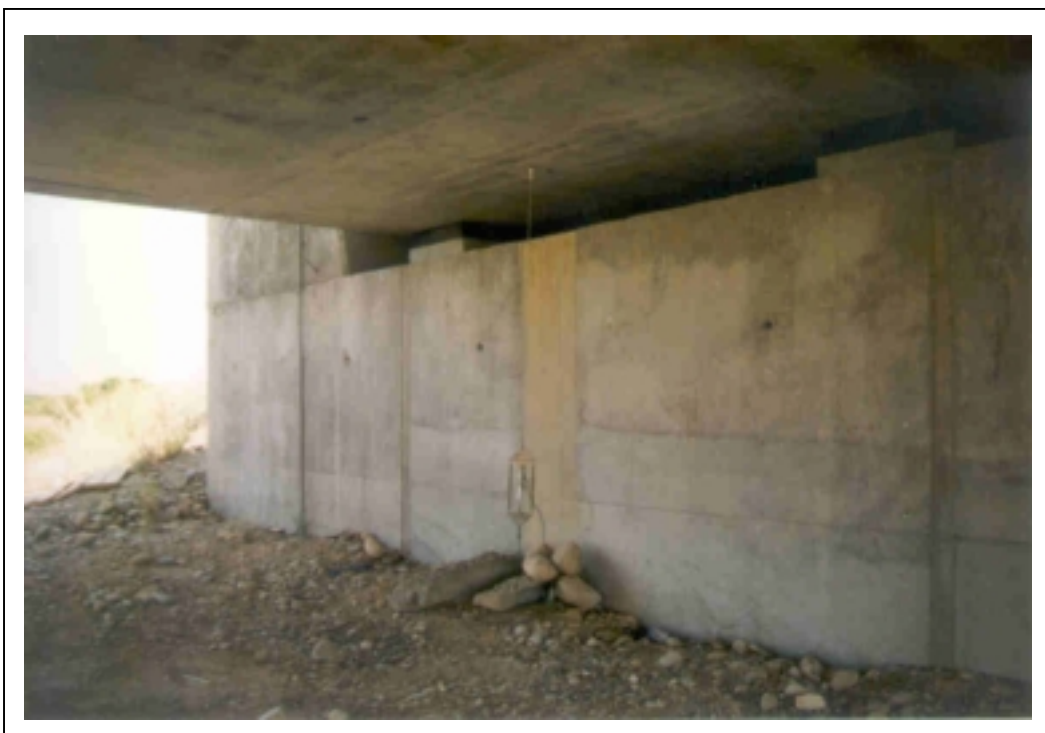
FOTOGRAFÍA 5: Detalle apoyo de neopreno
