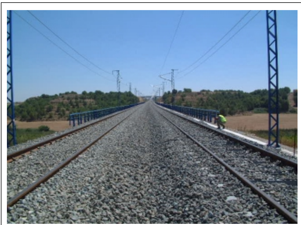
FOTOGRAFÍA 2: Vista superior del tablero
