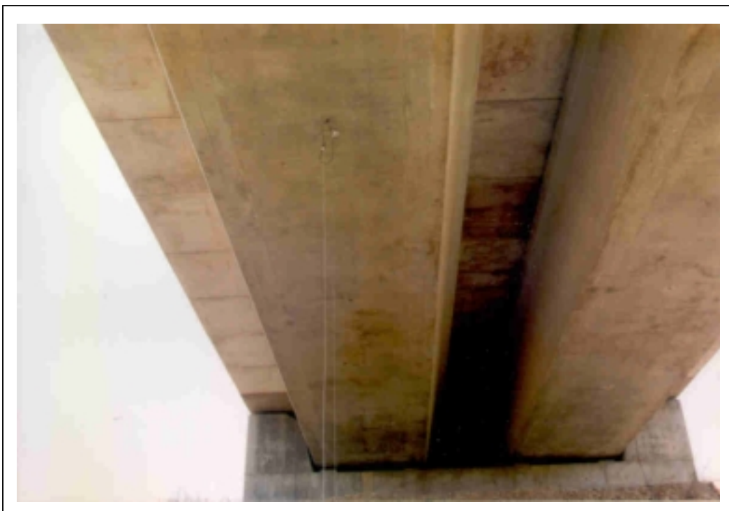
FOTOGRAFÍA 9: instrumentación en centro de vano
