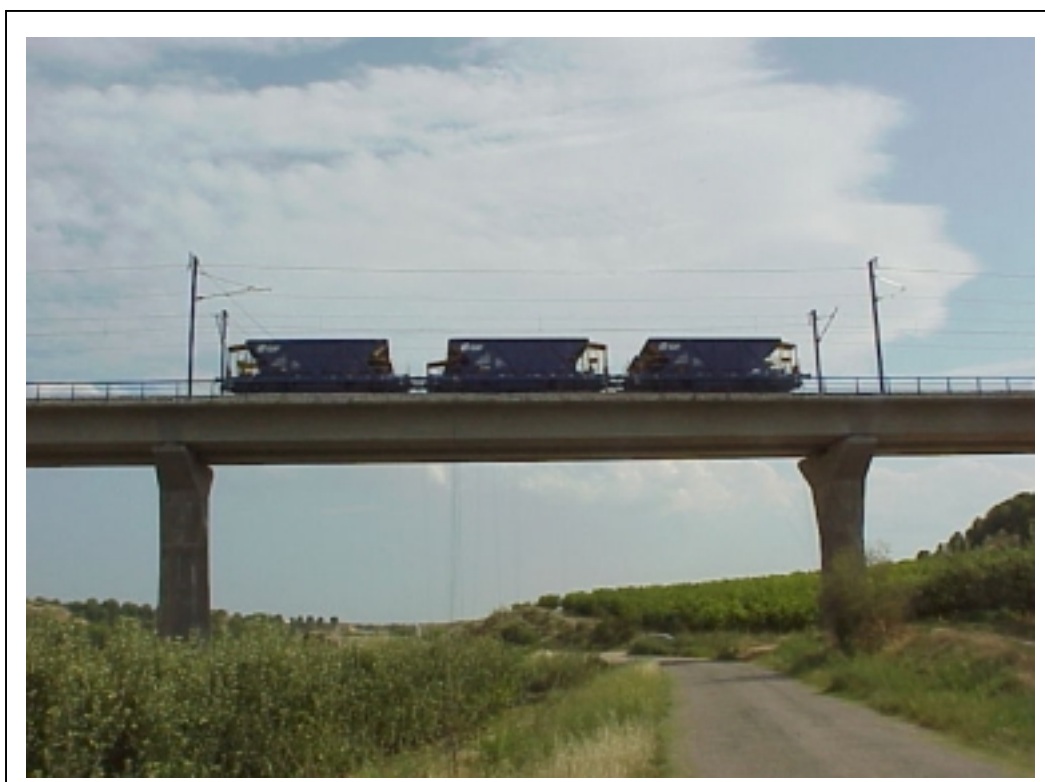
FOTOGRAFÍA 12: Estática vanos 1-3 (Vano 3)
