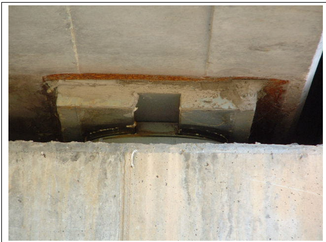
FOTOGRAFÍA N° 8: DETALLE APOYO IZQUIERDO ESTRIBO DE ENTRADA
