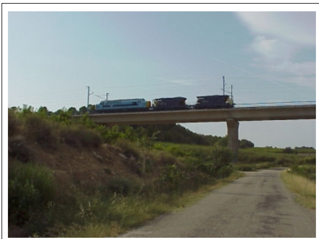
FOTOGRAFÍA 18: Posición estática EST03 en vanos 1-2-3-4
