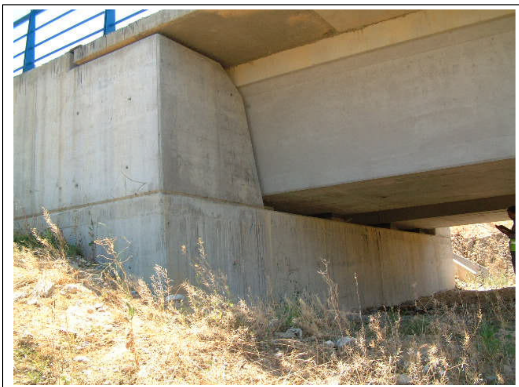
FOTOGRAFÍA Nº 6: ESTRIBO DE SALIDA
