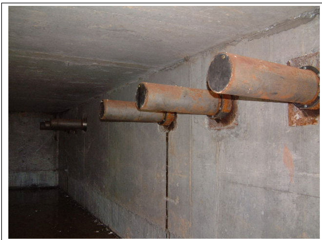
FOTOGRAFÍA Nº 12: INTERIOR ESTRIBO SALIDA
