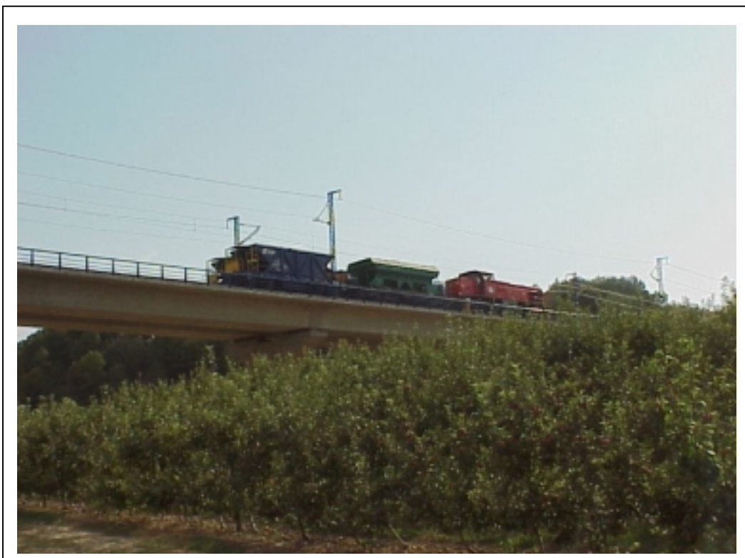
FOTOGRAFÍA 13: Estática vanos 1-3 (Vano 1)
