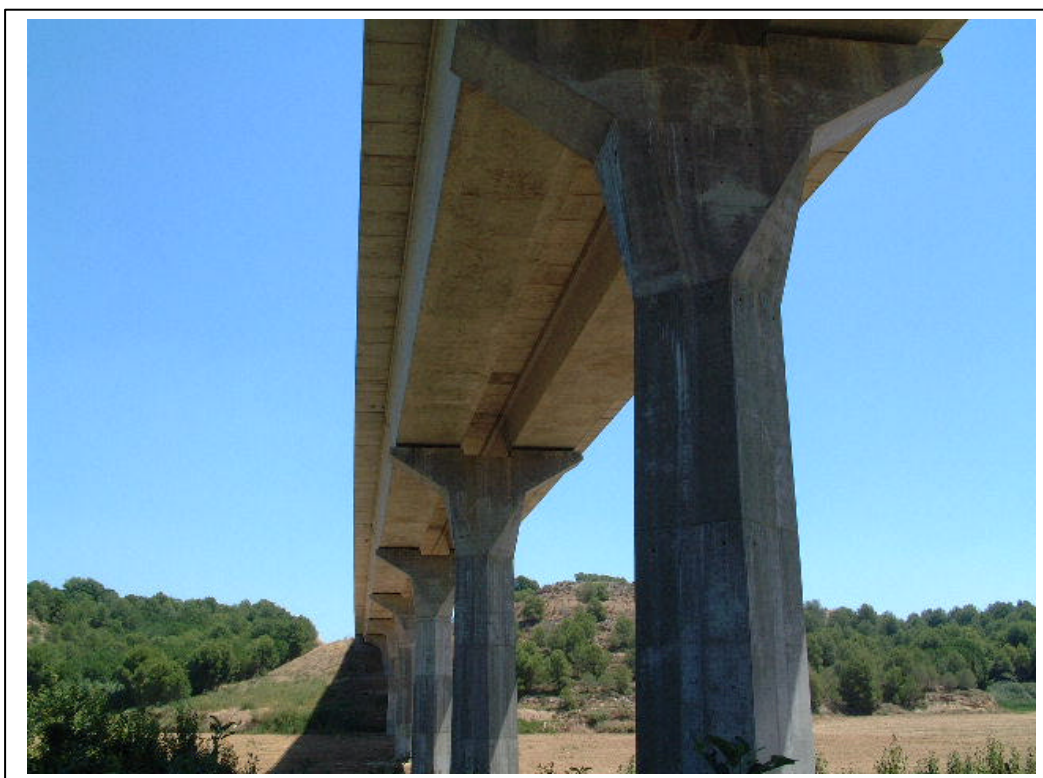
FOTOGRAFÍA Nº 16: VISTA INFERIOR DESDE ESTRIBO ENTRADA
