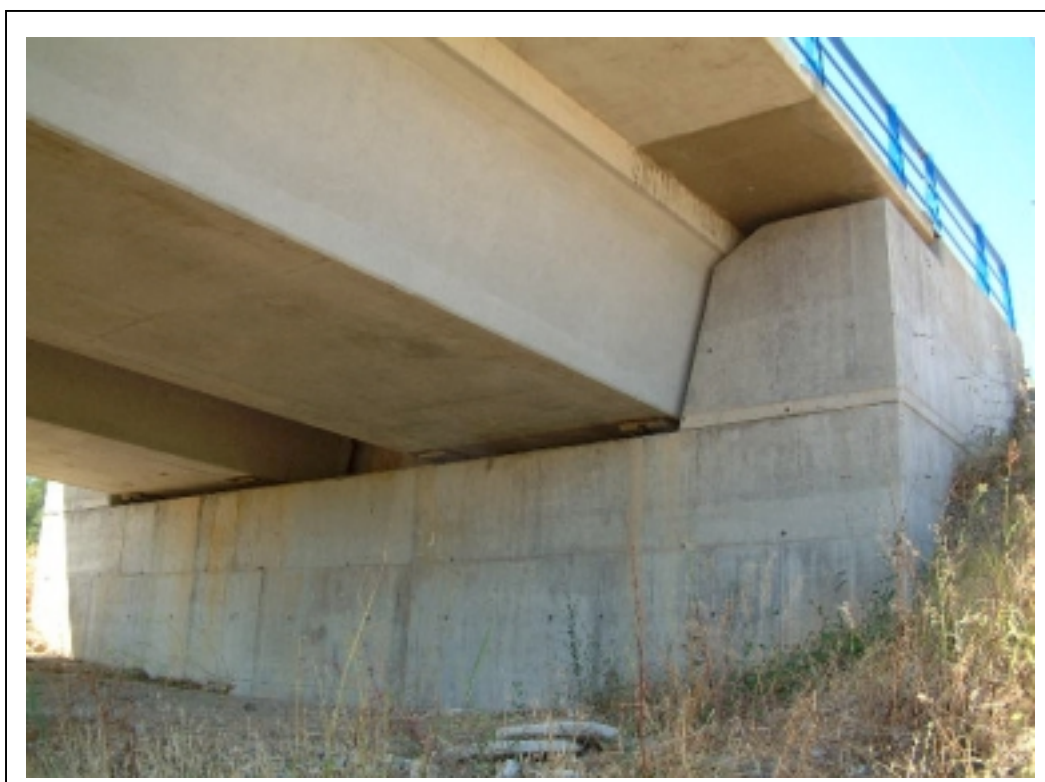
FOTOGRAFÍA 4: Vista de estribo
