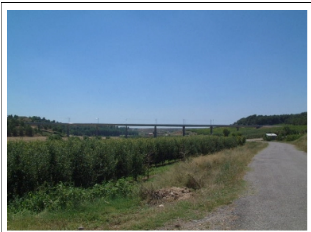
FOTOGRAFÍA 1: Vista general del puente
