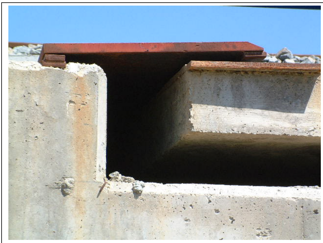
FOTOGRAFÍA Nº 9: DETALLE CUBREJUNTAS EN ESTRIBO ENTRADA LD
