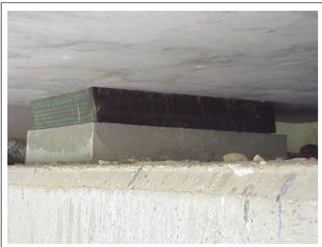
FOTOGRAFÍA 5: Detalle apoyo de neopreno
