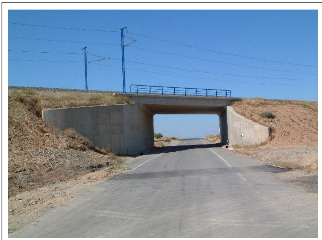
FOTOGRAFÍA 1: Vista general del puente
