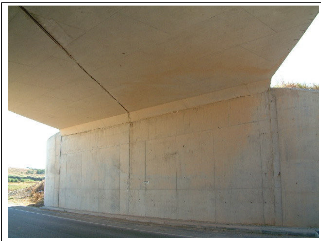
FOTOGRAFÍA Nº 5: ESTRIBO DE ENTRADA
