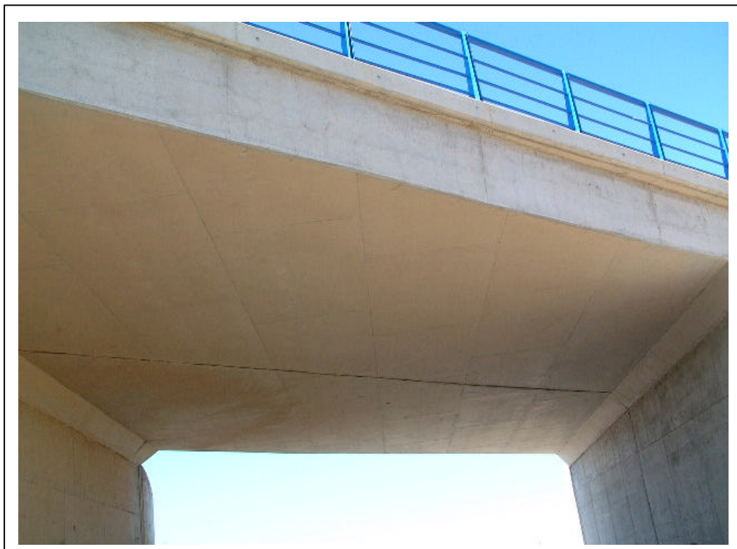
FOTOGRAFÍA 3: Vista inferior del tablero
