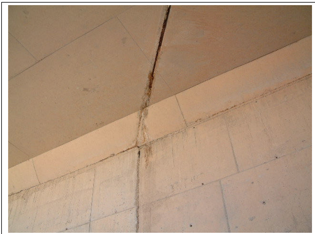
FOTOGRAFÍA N° 8: DETALLE JUNTA ESTRIBO ENTRADA
