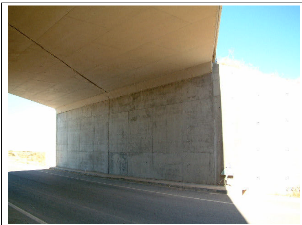
FOTOGRAFÍA Nº 6: ESTRIBO DE SALIDA
