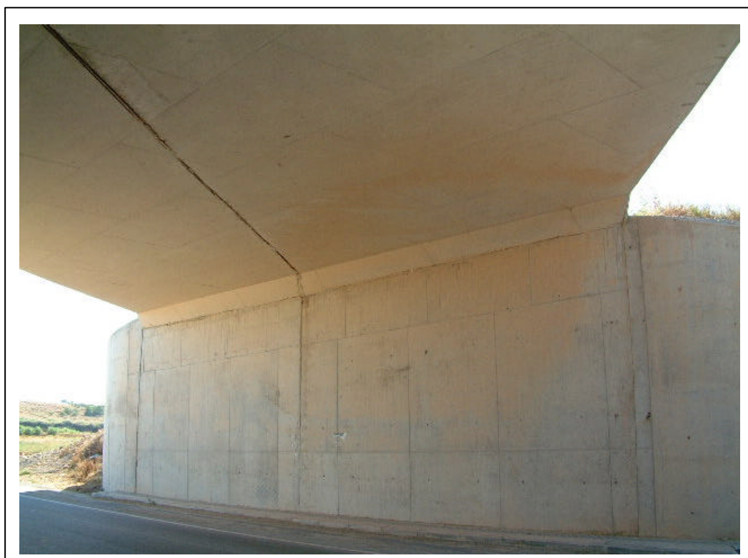
FOTOGRAFÍA 4: Vista de estribo
