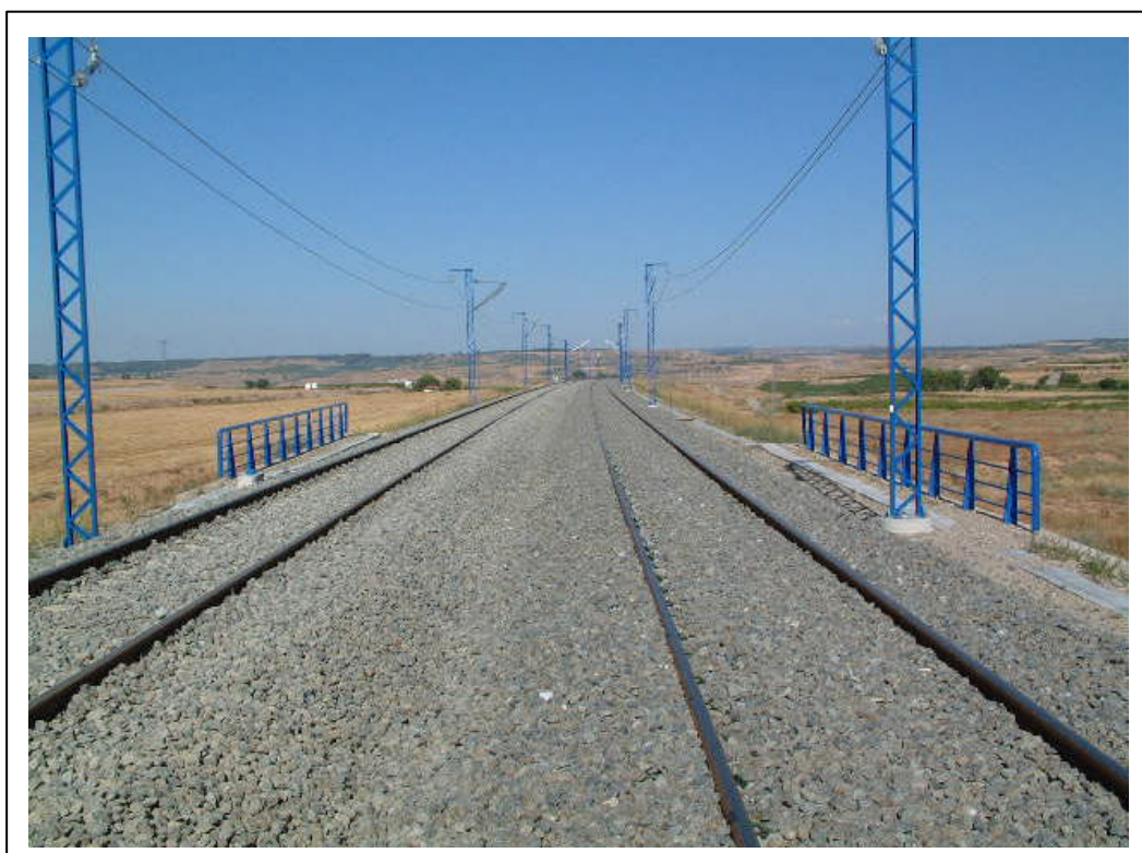
FOTOGRAFÍA 2: Vista superior del tablero
