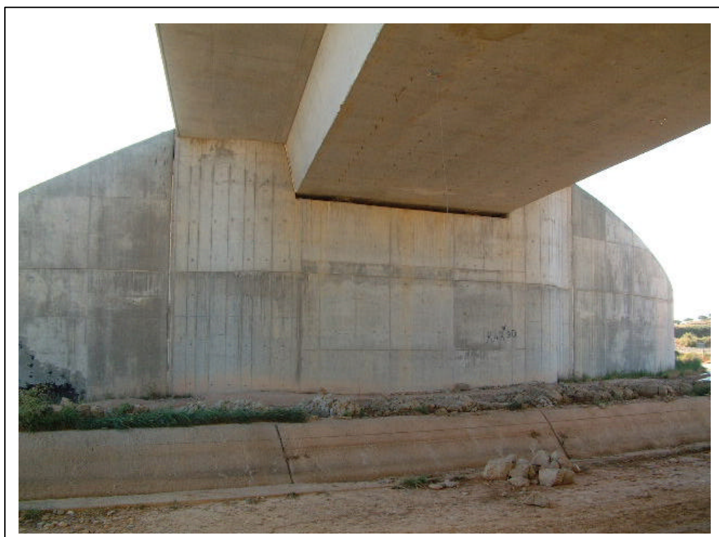
FOTOGRAFÍA 4: Vista de estribo y aleta
