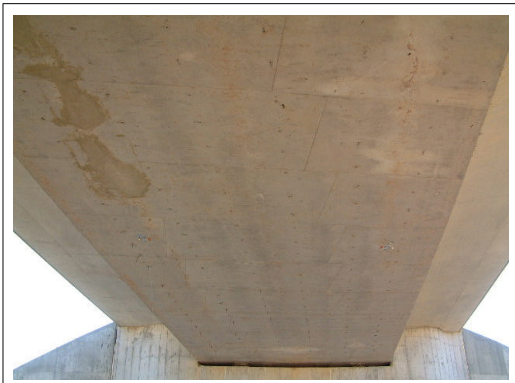
FOTOGRAFÍA 3: Vista inferior del tablero
