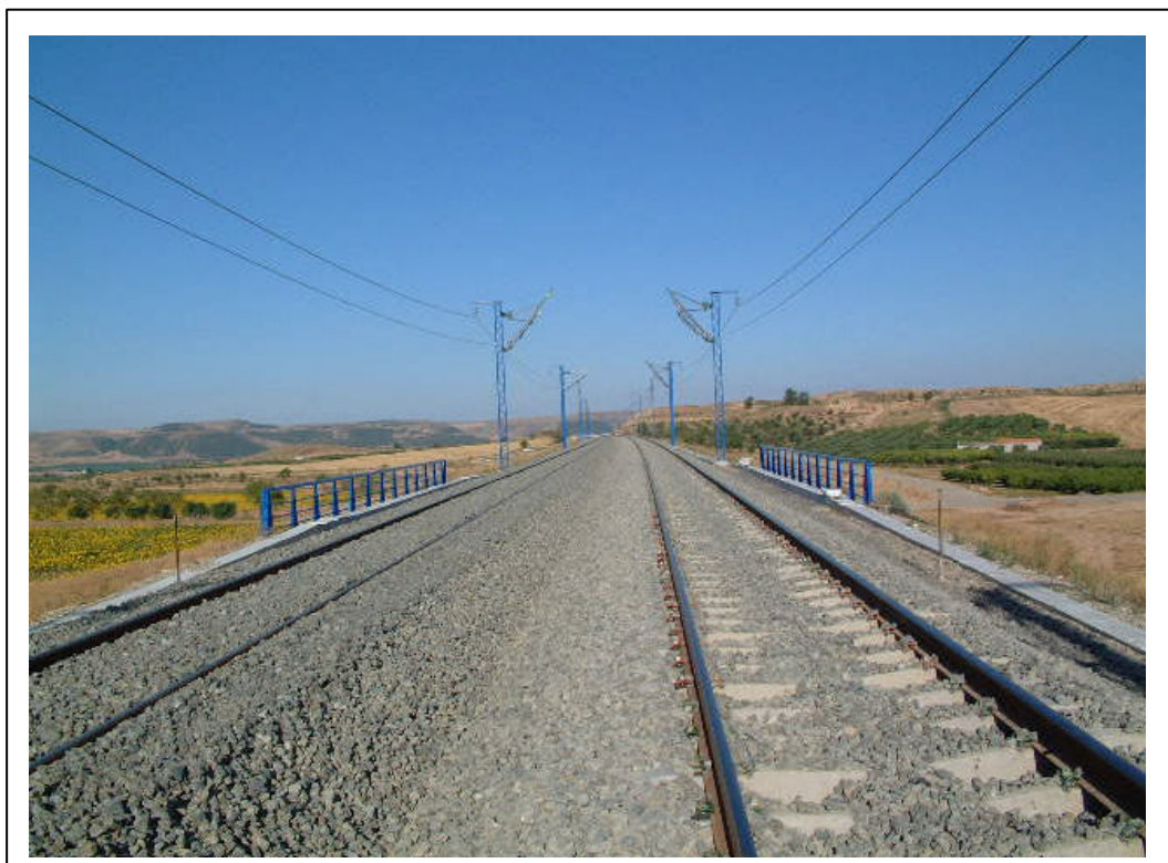
FOTOGRAFÍA 2: Vista superior del tablero
