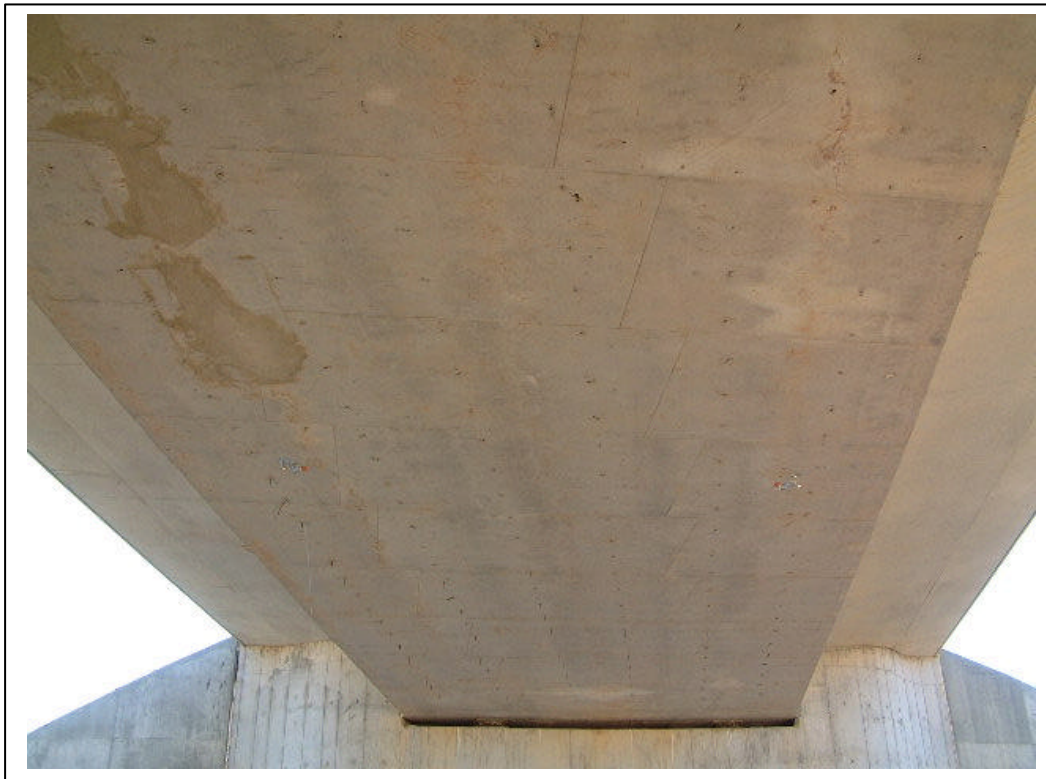
FOTOGRAFÍA N° 7: VISTA INFERIOR DESDE ESTRIBO DE ENTRADA
