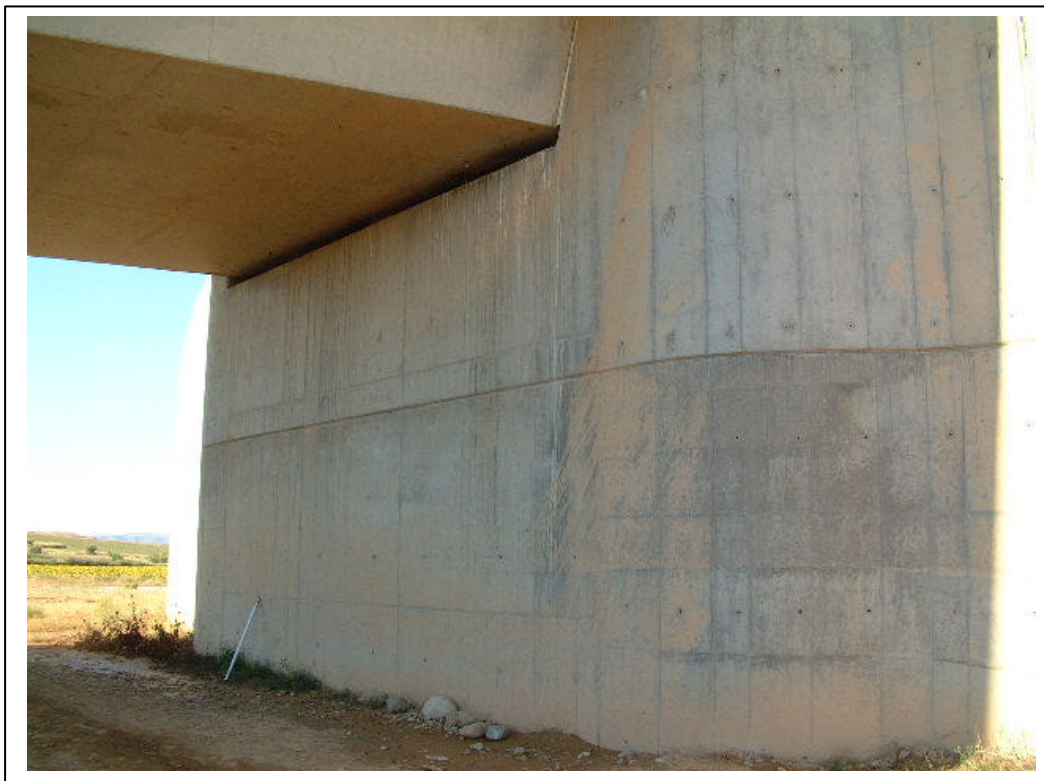
FOTOGRAFÍA Nº 5: ESTRIBO DE ENTRADA
