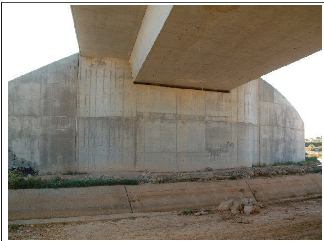
FOTOGRAFÍA Nº 6: ESTRIBO DE SALIDA
