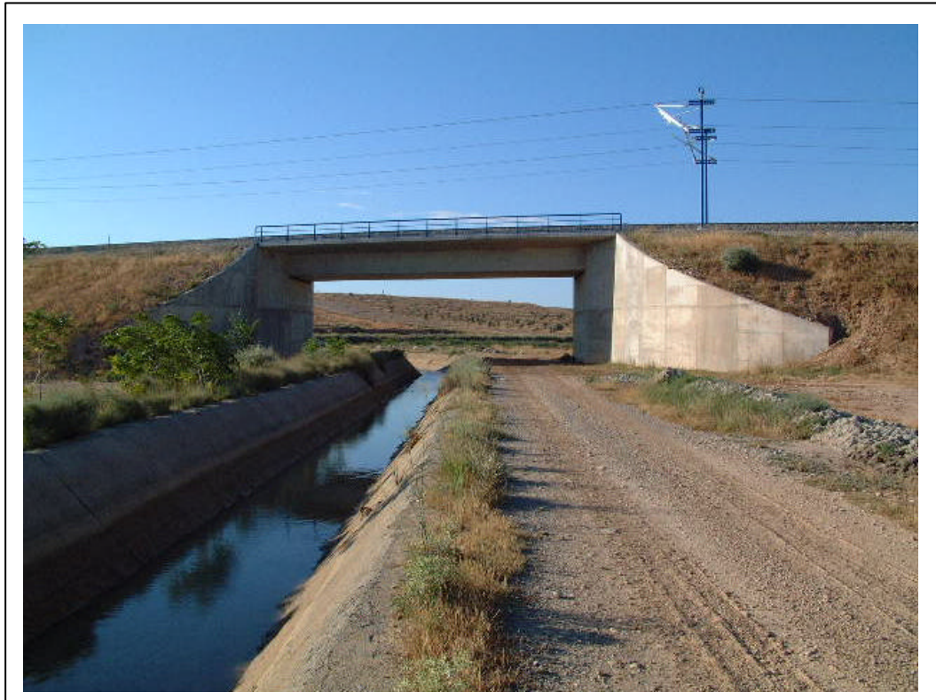
FOTOGRAFÍA 1: Vista general del puente
