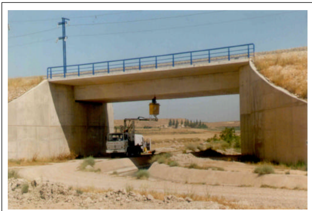
FOTOGRAFÍA 5: Colocación de aparatos de medida
