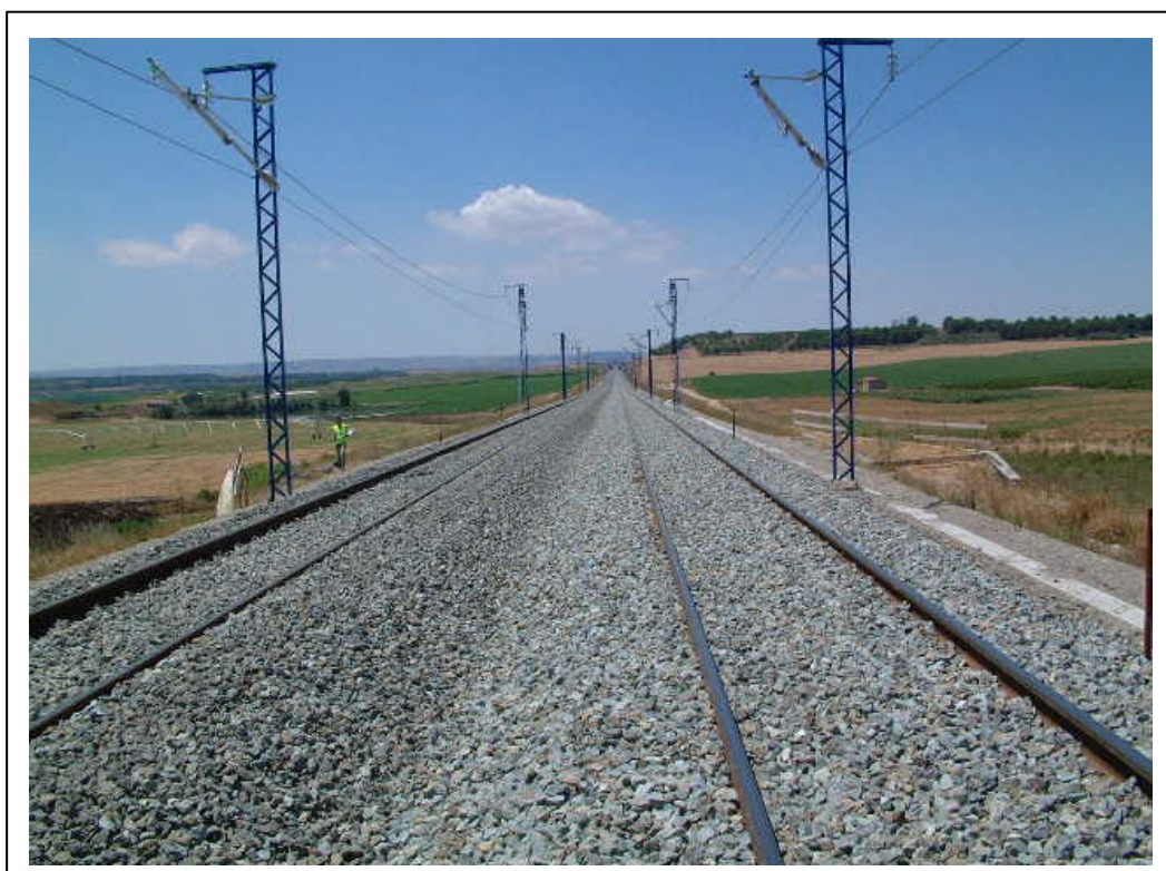
FOTOGRAFÍA 2: Vista superior del tablero
