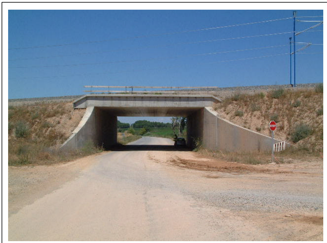
FOTOGRAFÍA 1: Vista general del puente
