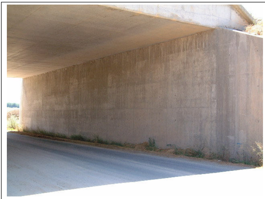
FOTOGRAFÍA Nº 5: ESTRIBO DE ENTRADA
