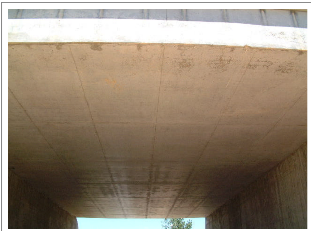
FOTOGRAFÍA 3: Vista inferior del tablero
