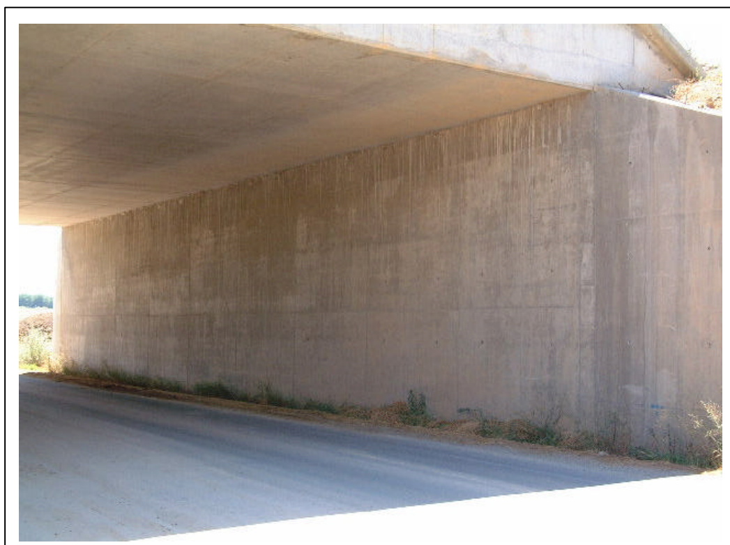
FOTOGRAFÍA 4: Vista de estribo
