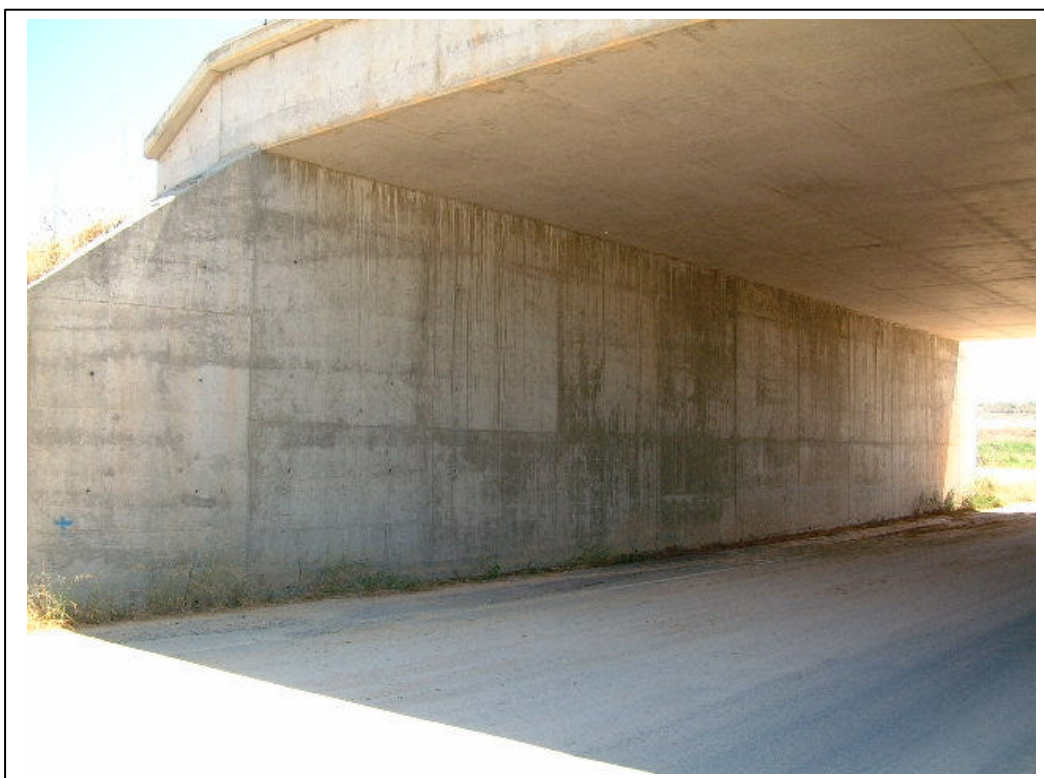
FOTOGRAFÍA Nº 6: ESTRIBO DE SALIDA
