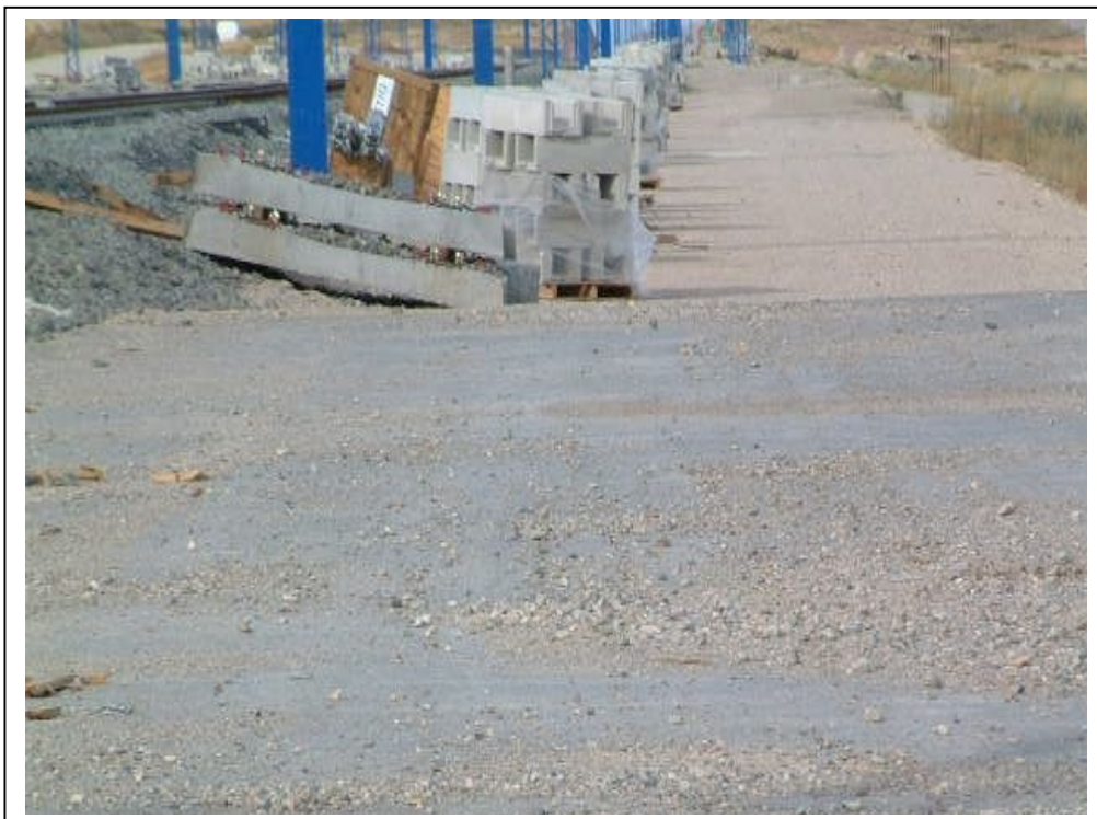
FOTOGRAFÍA Nº 9: VISTA SUPERIOR TABLERO LADO DERECHO
