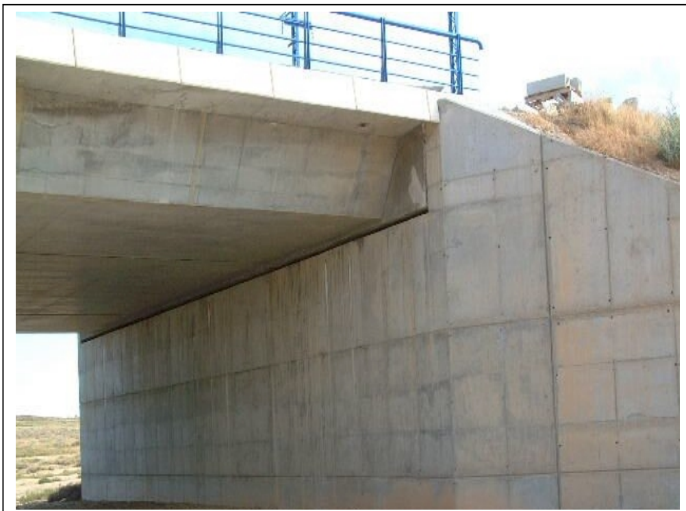
FOTOGRAFÍA Nº 5: ESTRIBO DE ENTRADA
