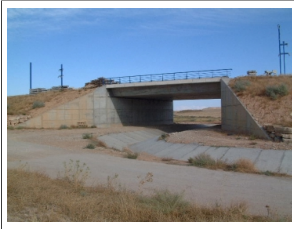
FOTOGRAFÍA 1: Vista general del puente
