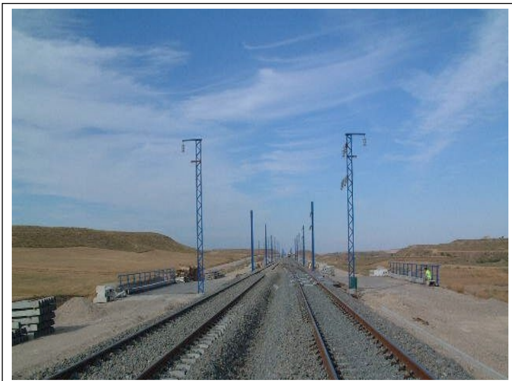
FOTOGRAFÍA N° 3: VISTA SUPERIOR DESDE ENTRADA
