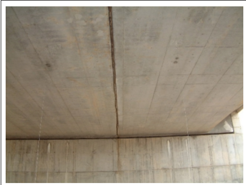
FOTOGRAFÍA 3: Vista inferior del tablero
