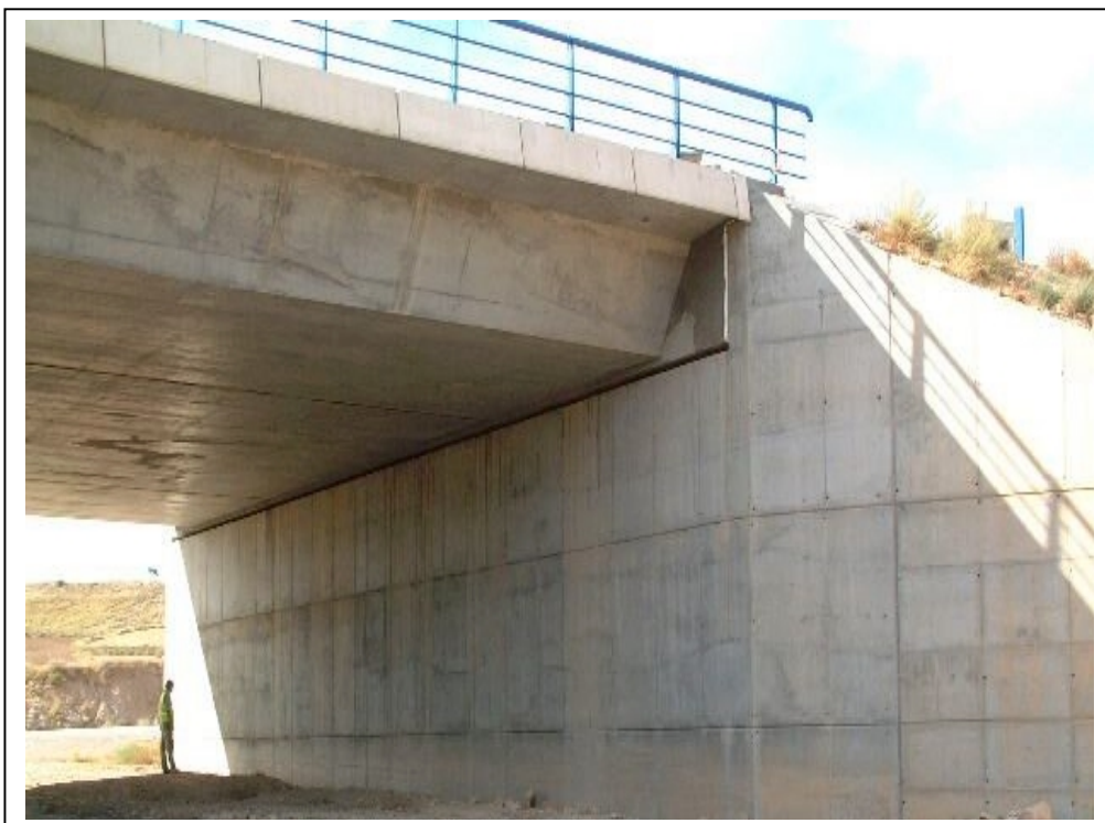
FOTOGRAFÍA Nº 6: ESTRIBO DE SALIDA
