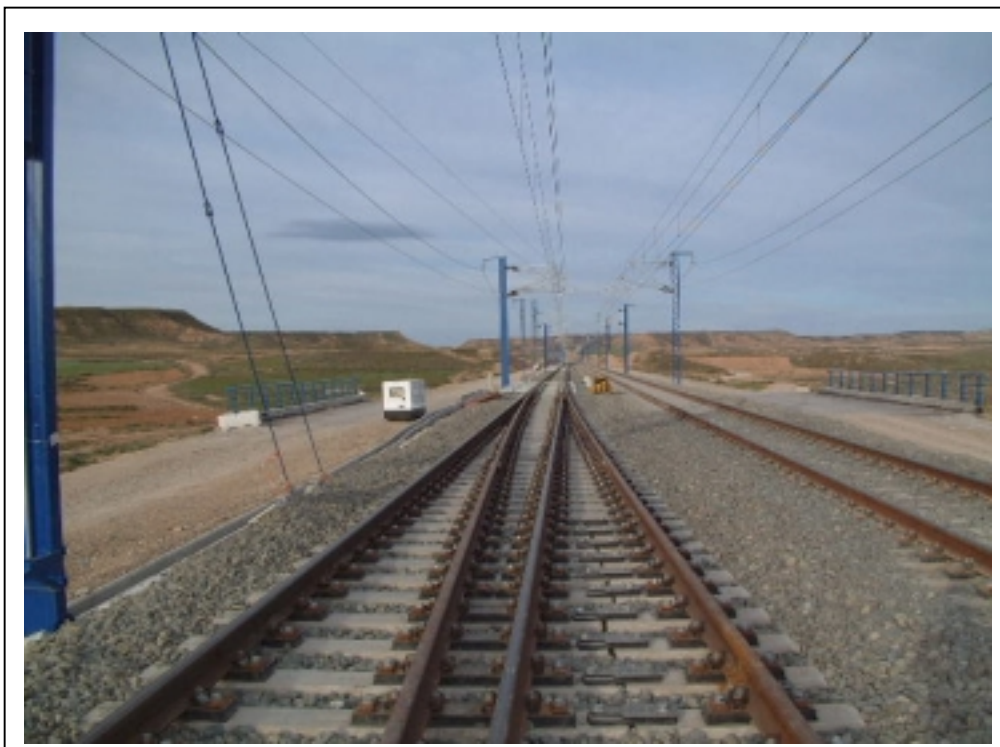
FOTOGRAFÍA 2: Vista superior del tablero
