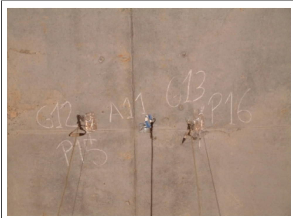
FOTOGRAFÍA 7: Galgas y transductores en centro de vano
