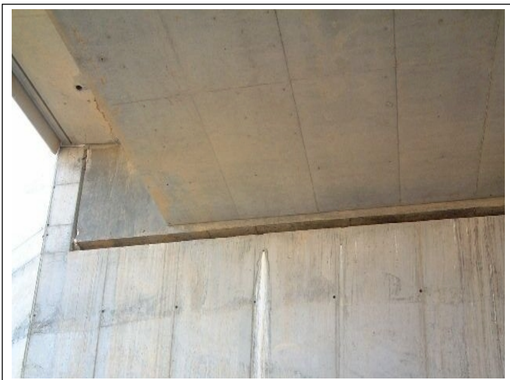
FOTOGRAFÍA N° 8: DETALLE ESTRIBO DE ENTRADA EN LD.
