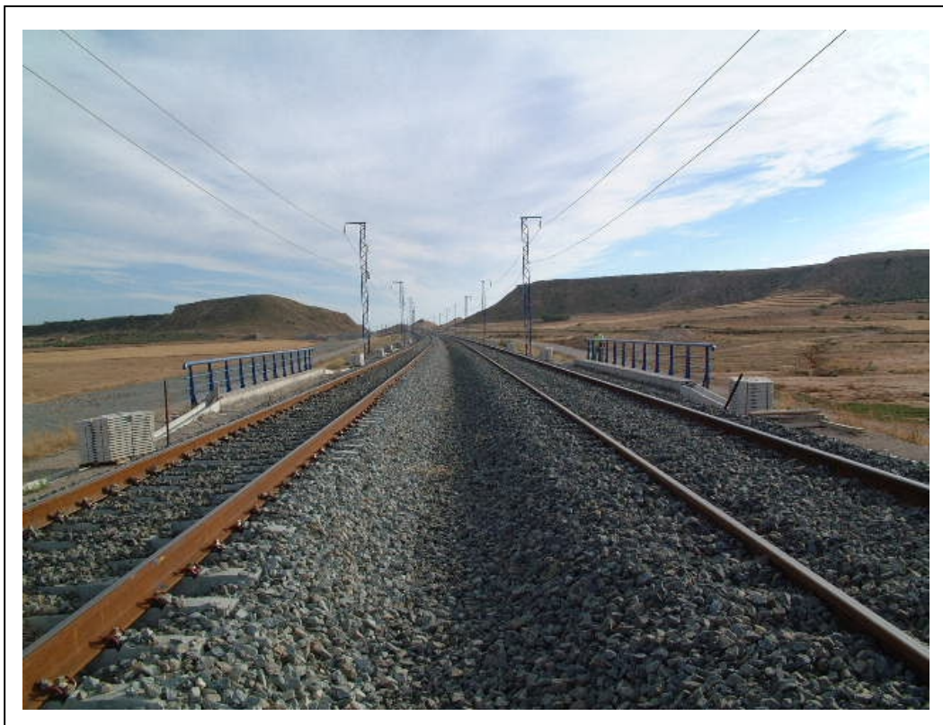
FOTOGRAFÍA 2: Vista superior del tablero
