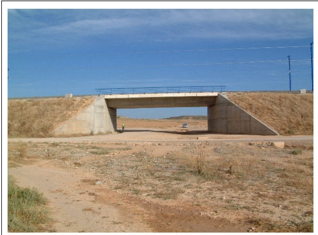
FOTOGRAFÍA 1: Vista general del puente
