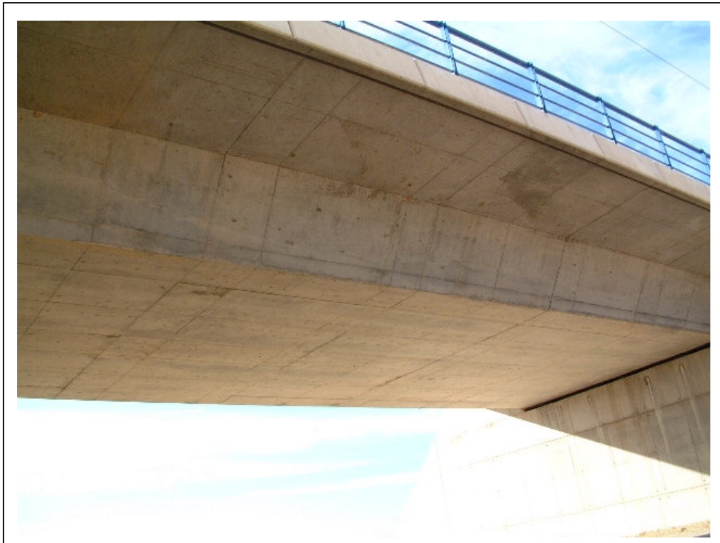
FOTOGRAFÍA 3: Vista inferior del tablero
