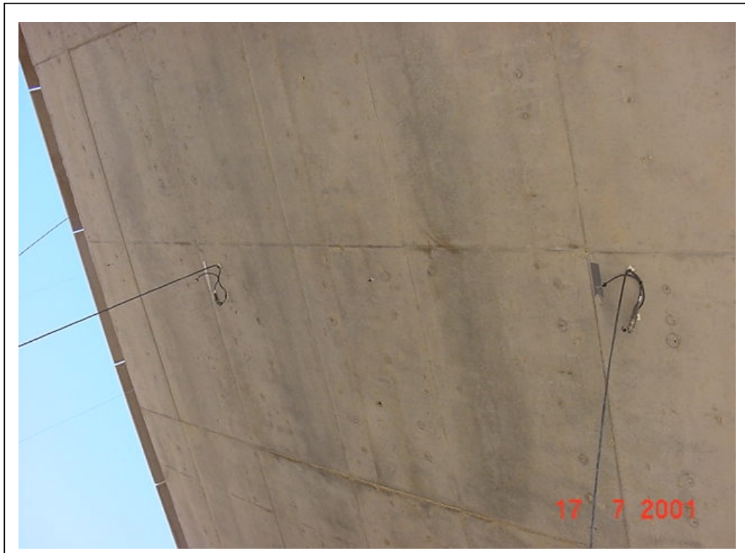
FOTOGRAFÍA 5: Transductores y galgas en centro de vano
