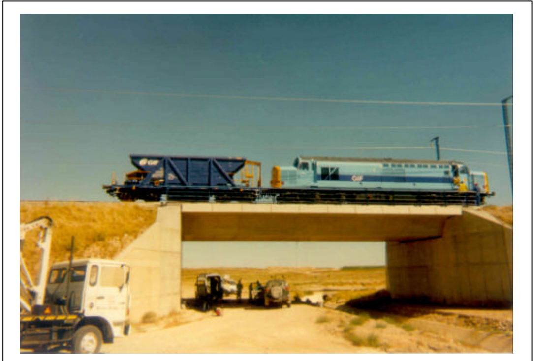
FOTOGRAFÍA 7: Tren de cargas sobre la estructura
