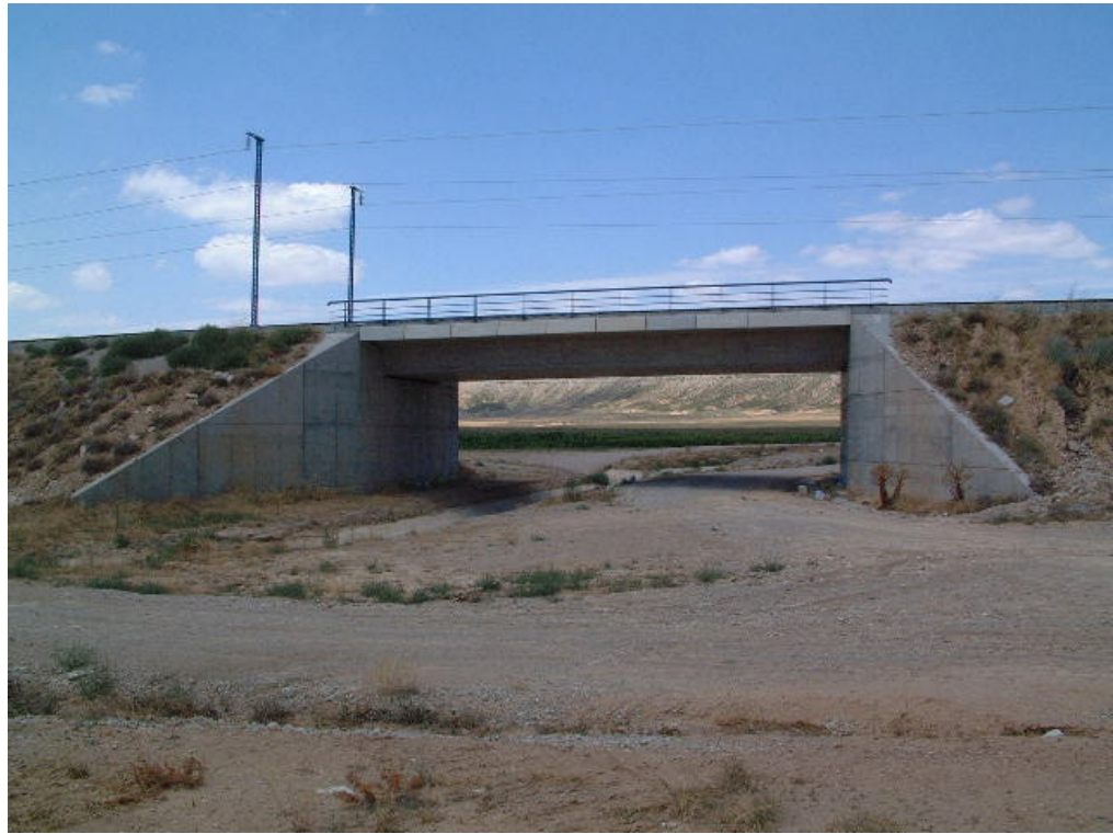
FOTOGRAFÍA 1: Vista general del puente
