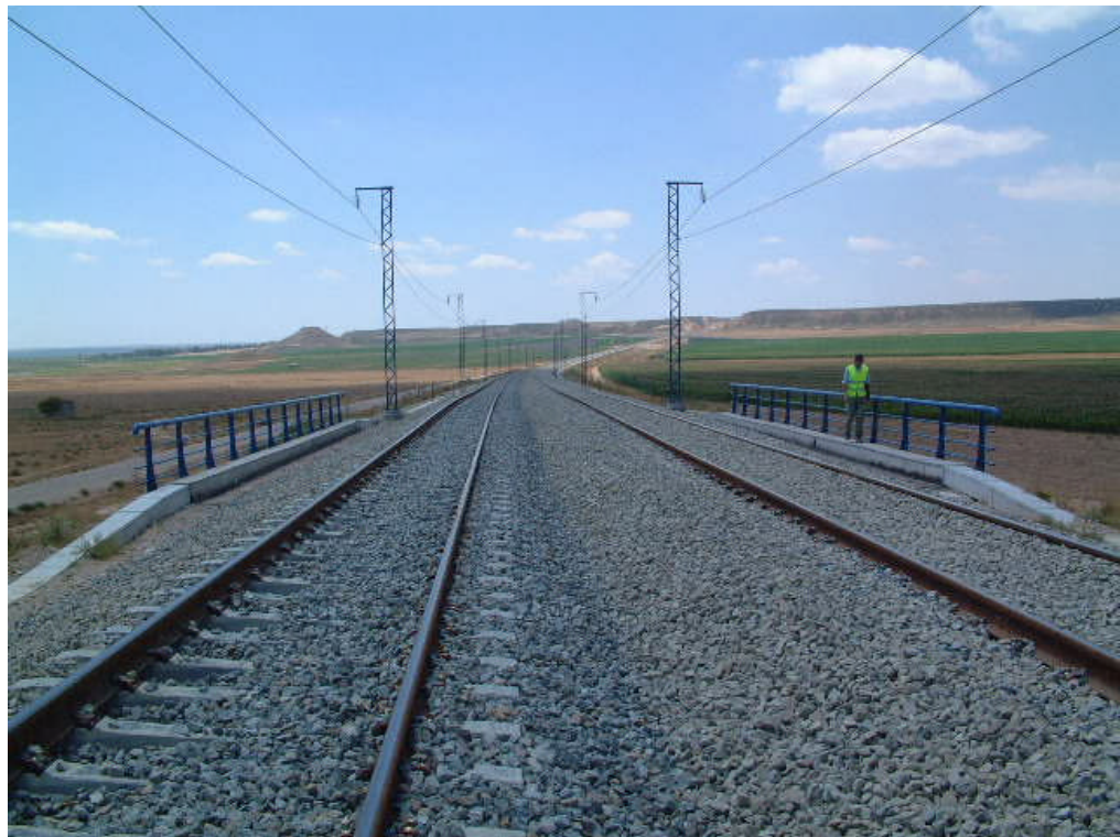
FOTOGRAFÍA 2: Vista superior del tablero
