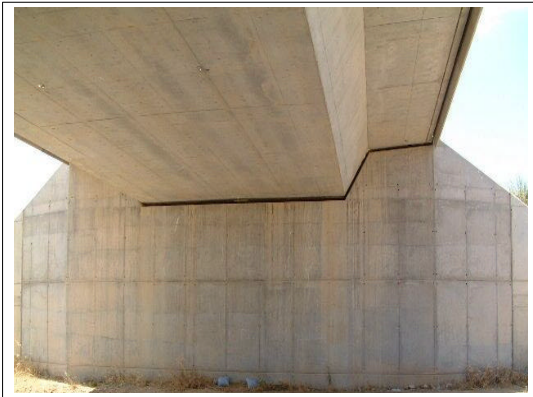
FOTOGRAFÍA Nº 5: ESTRIBO DE ENTRADA
