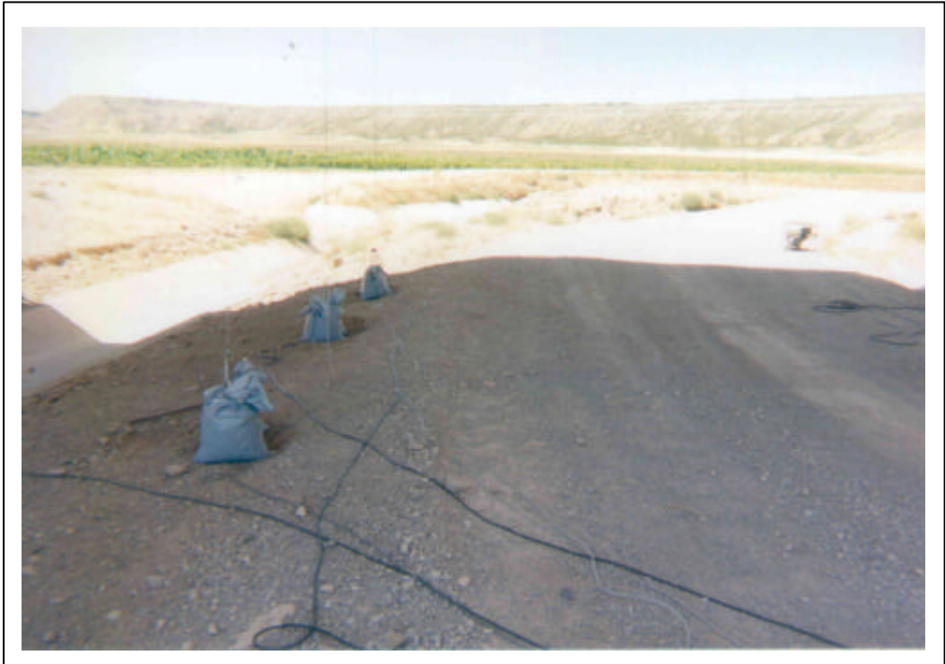
FOTOGRAFÍA 5: Transductores de desplazamientos en centro de vano
