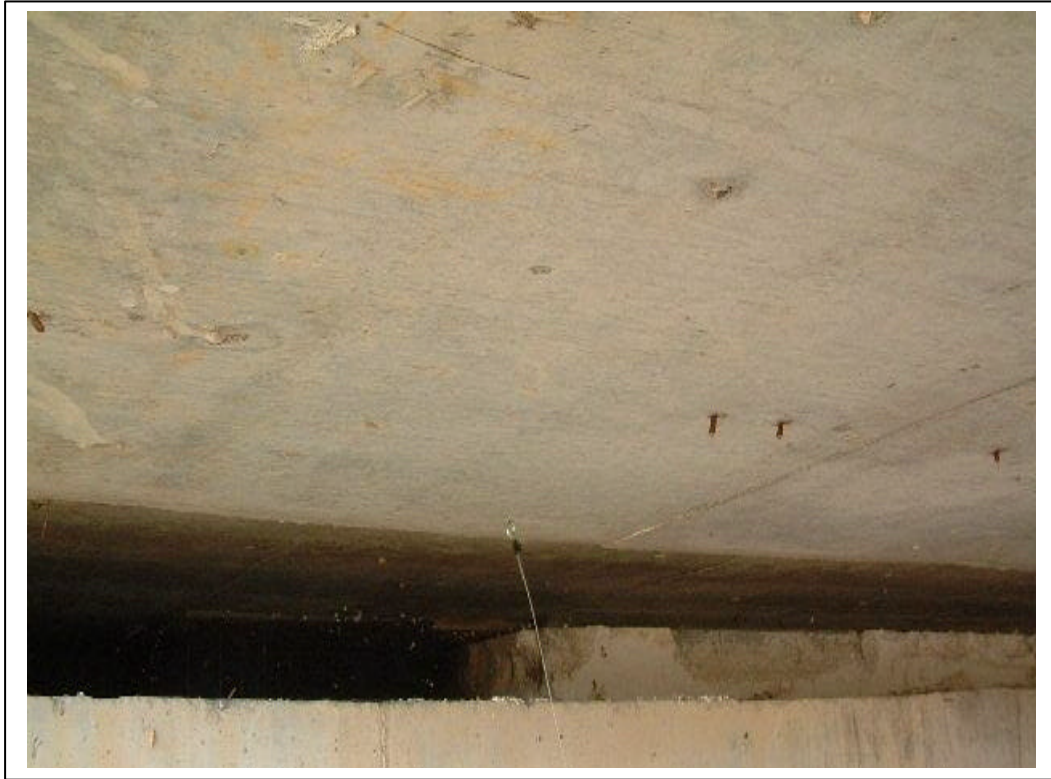
FOTOGRAFÍA Nº 9: DETALLE ESTRIBO DE SALIDA
