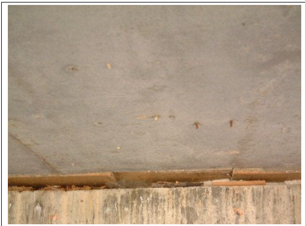
FOTOGRAFÍA N° 8: DETALLE ESTRIBO DE ENTRADA
