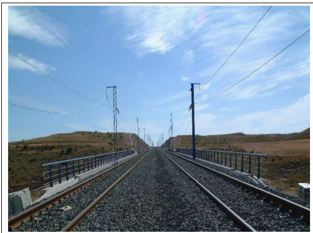
FOTOGRAFÍA Nº 4: VISTA SUPERIOR DESDE SALIDA
