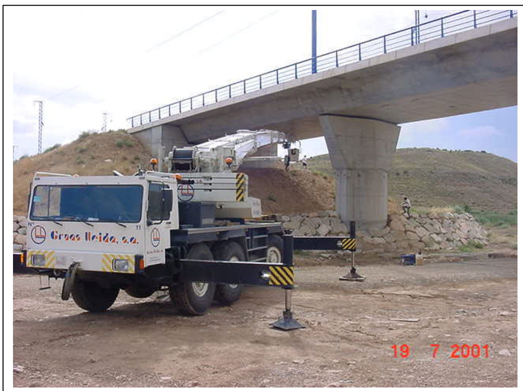
FOTOGRAFÍA 6: Medios auxiliares para colocación de aparatos
