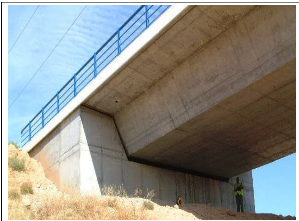
FOTOGRAFÍA Nº 6: ESTRIBO DE SALIDA
