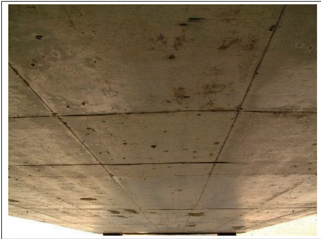
FOTOGRAFÍA N° 7: VISTA INFERIOR EN TRAMO 1
