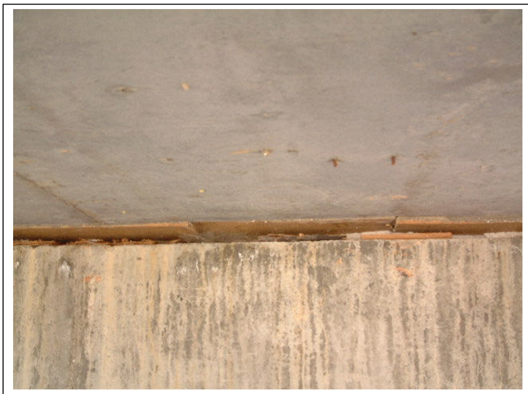
FOTOGRAFÍA 5: Detalle de apoyos
