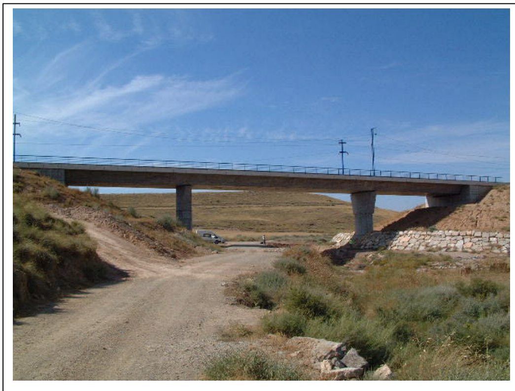
FOTOGRAFÍA 1: Vista general del puente
