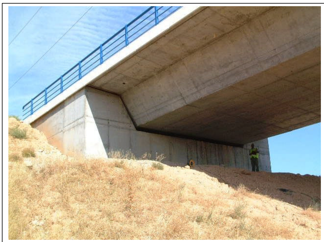
FOTOGRAFÍA 4: Vista de estribo
