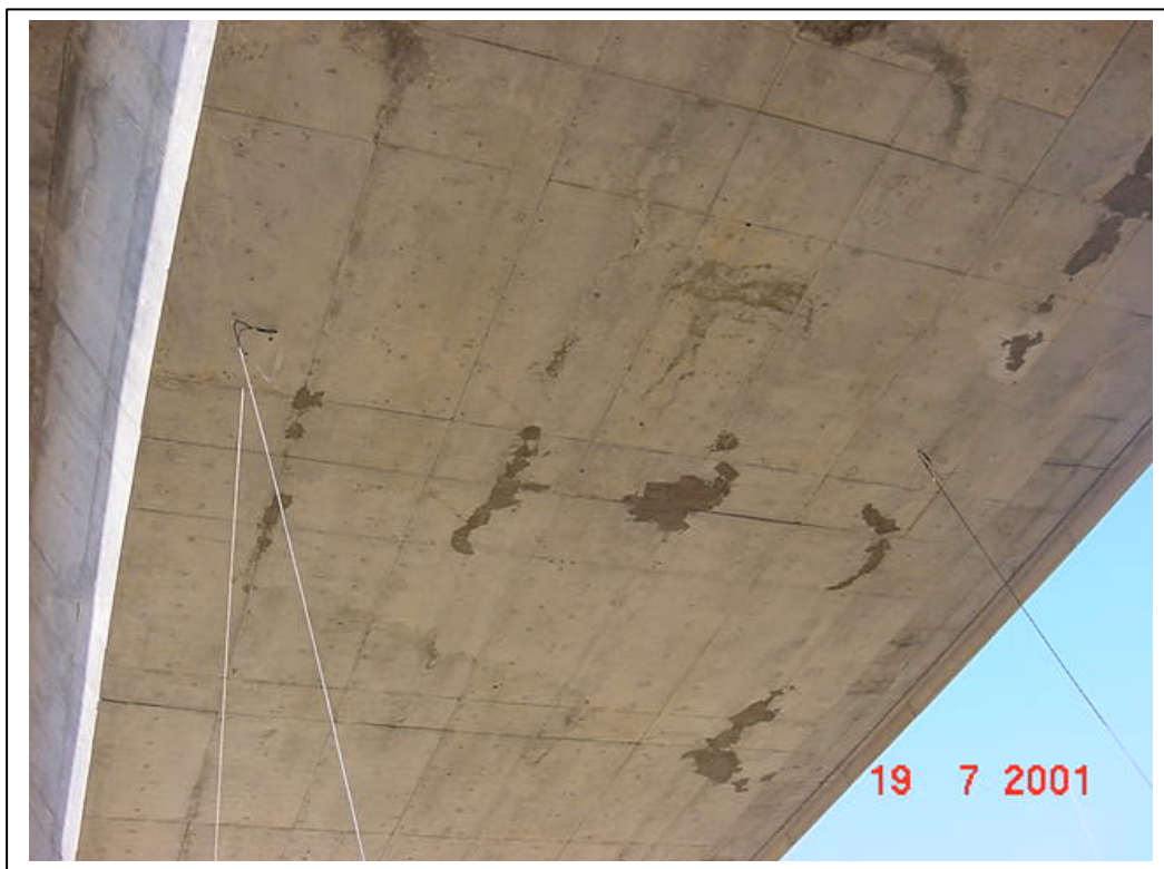
FOTOGRAFÍA 13: Detalle instrumentación en centro de vano
