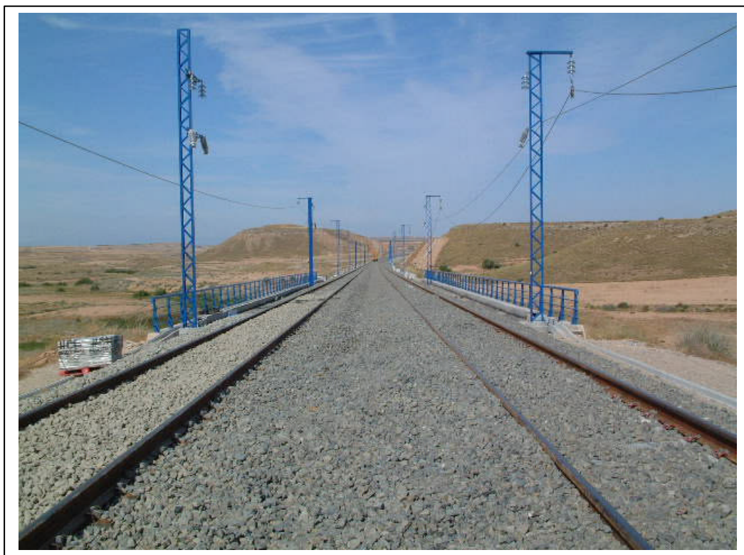
FOTOGRAFÍA 2: Vista superior del tablero
