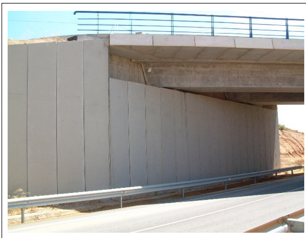
FOTOGRAFÍA 4: Vista de estribo y aleta
