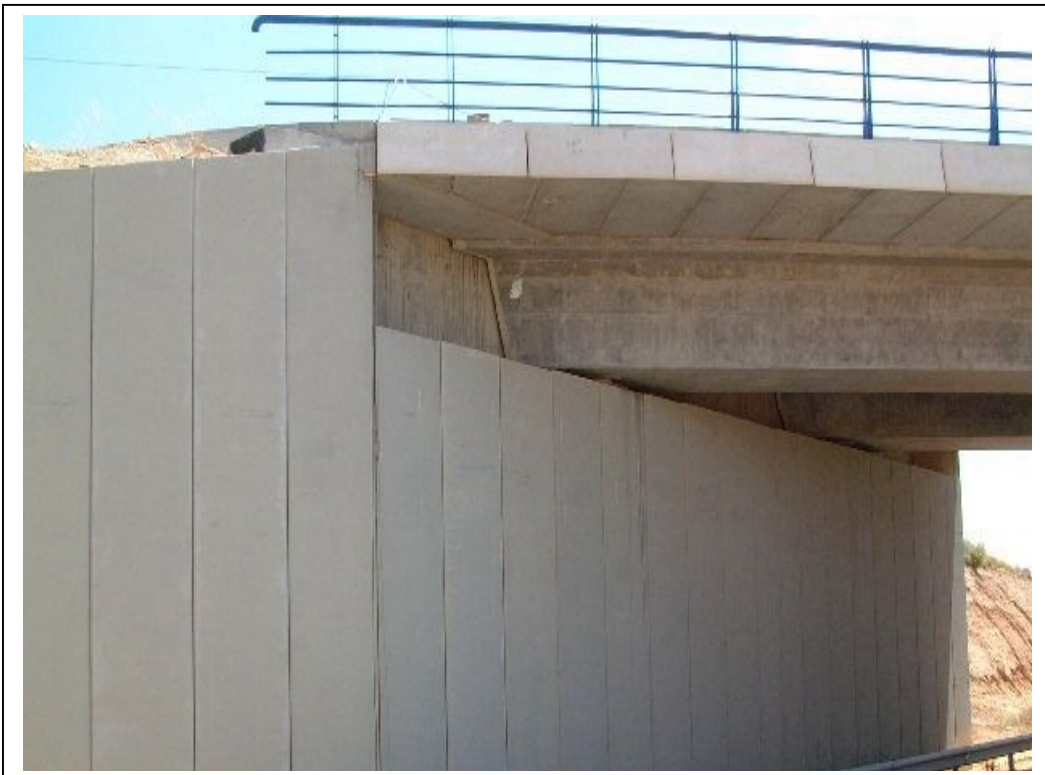
FOTOGRAFÍA Nº 6: ESTRIBO DE SALIDA
