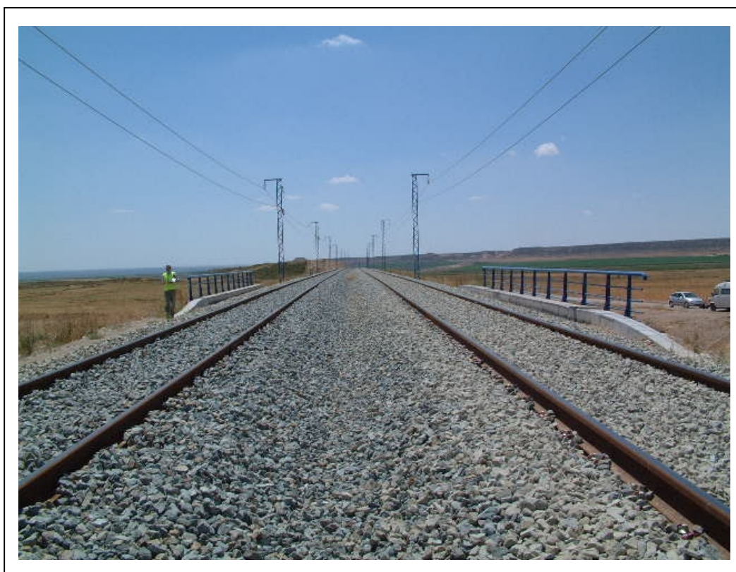
FOTOGRAFÍA 2: Vista superior del tablero
