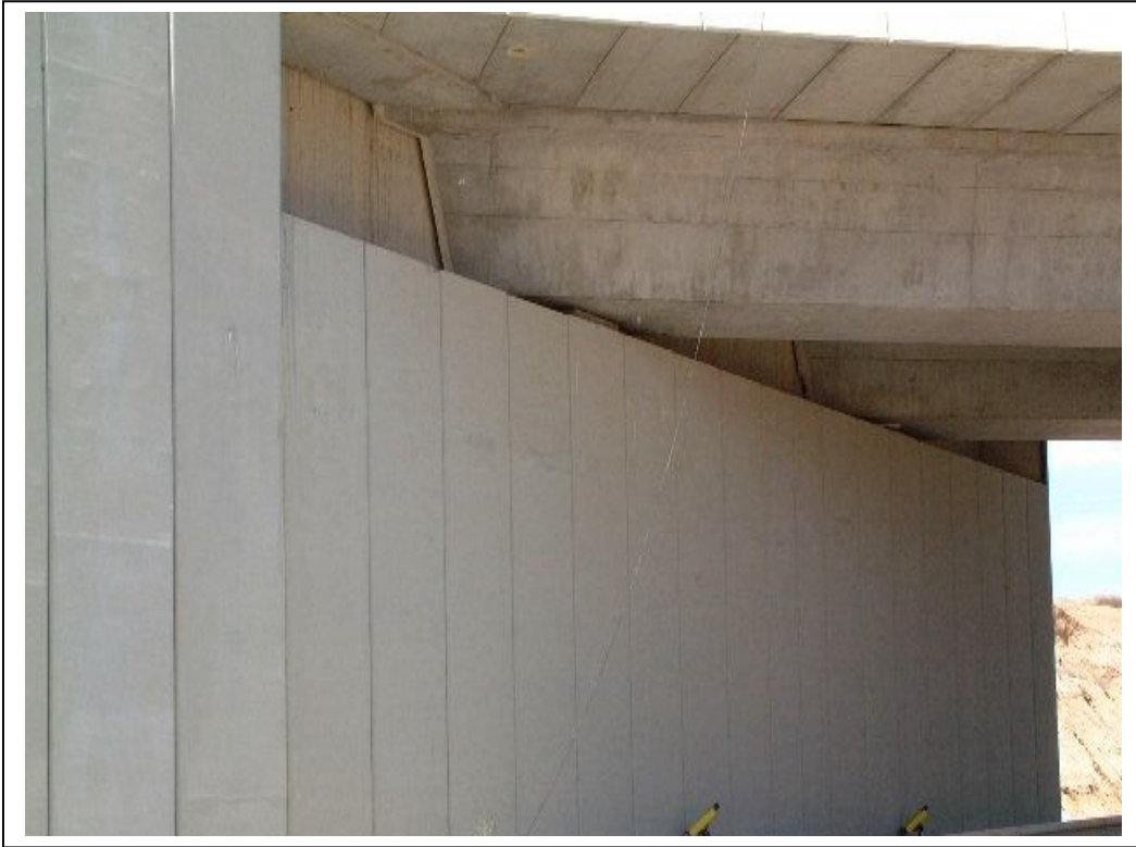
FOTOGRAFÍA Nº 5: ESTRIBO DE ENTRADA
