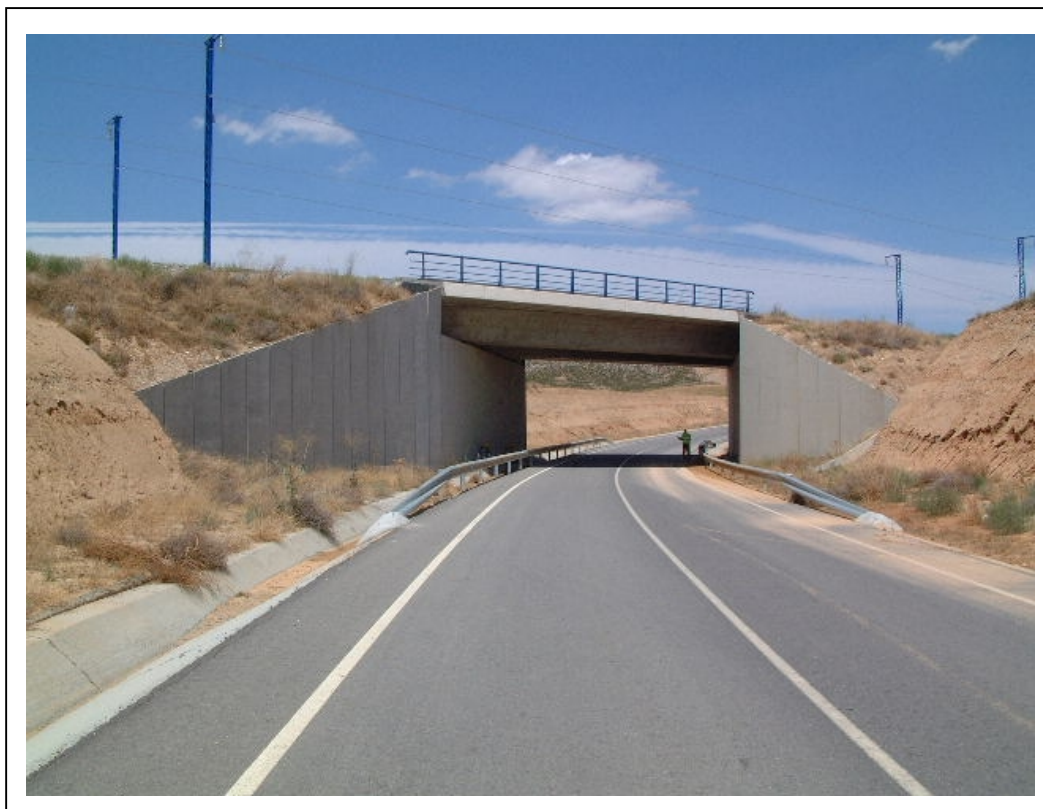
FOTOGRAFÍA 1: Vista general del puente
