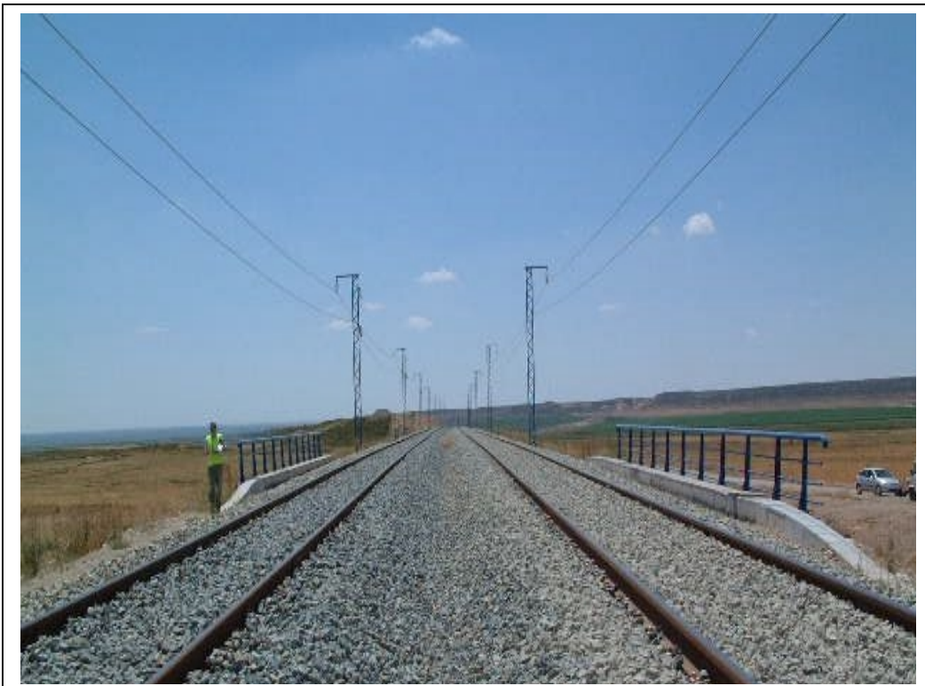
FOTOGRAFÍA Nº 4: VISTA SUPERIOR DESDE SALIDA
