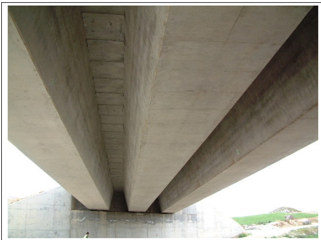
FOTOGRAFÍA Nº 7: VISTA INFERIOR DESDE EL ESTRIBO DE SALIDA.
