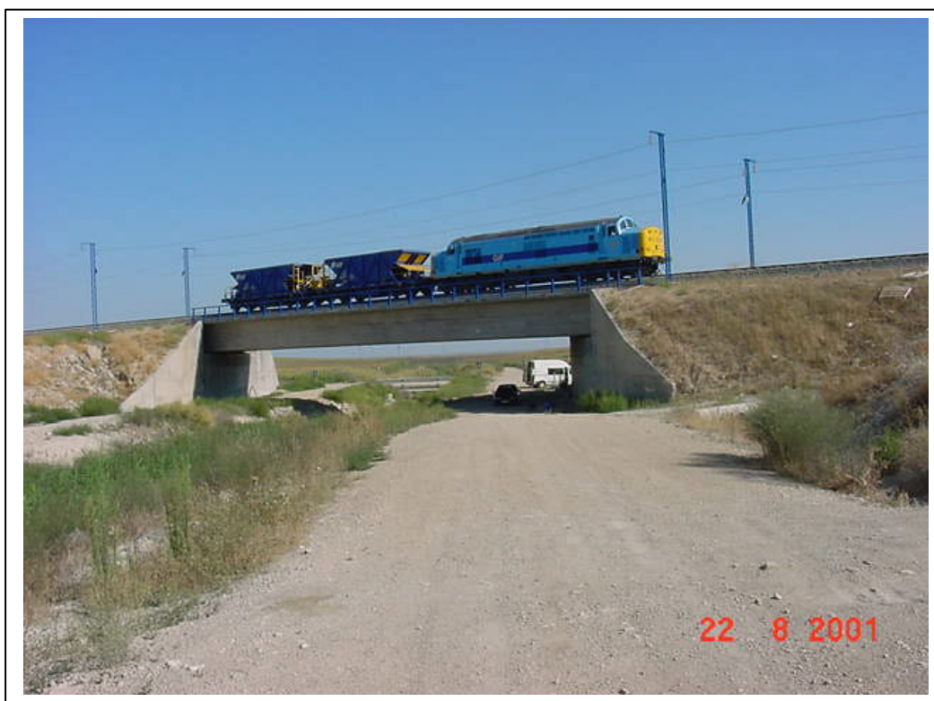
FOTOGRAFÍA 14: Tren de cargas sobre la estructura en vía 2
