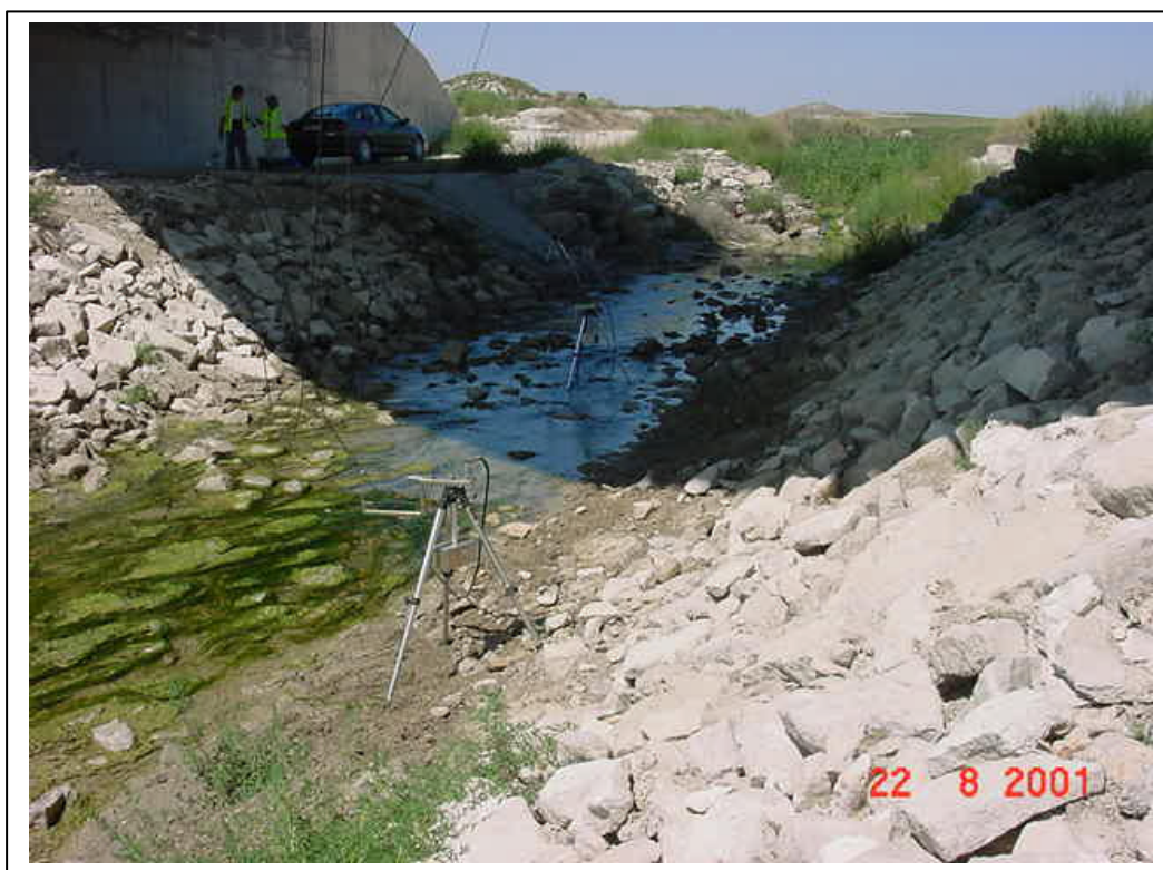
FOTOGRAFÍA 9: Instrumentación en centro de vano (2)
