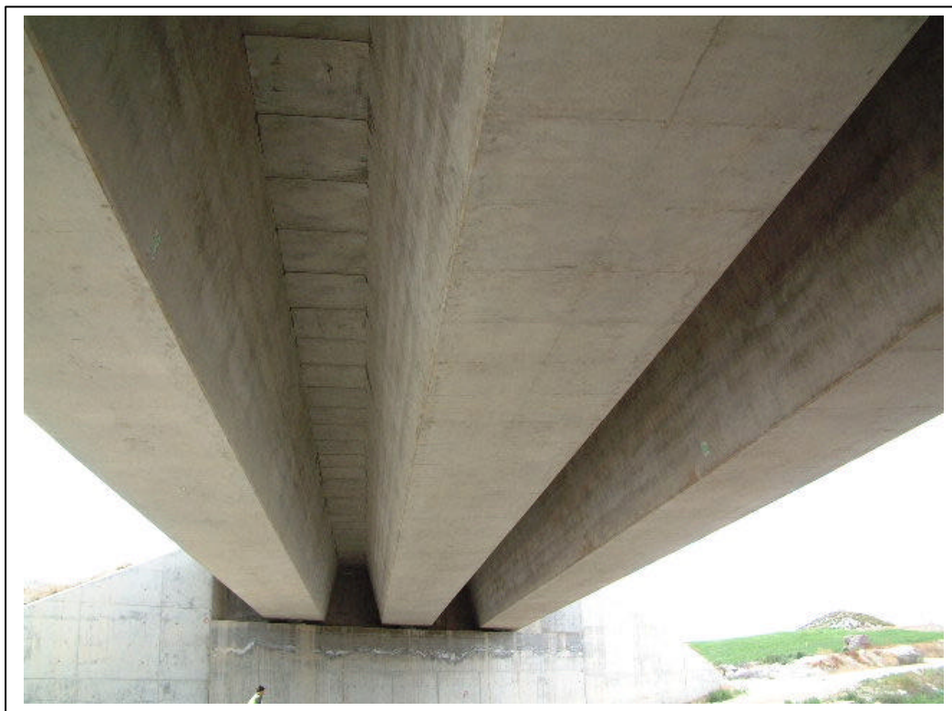
FOTOGRAFÍA 3: Vista inferior del tablero
