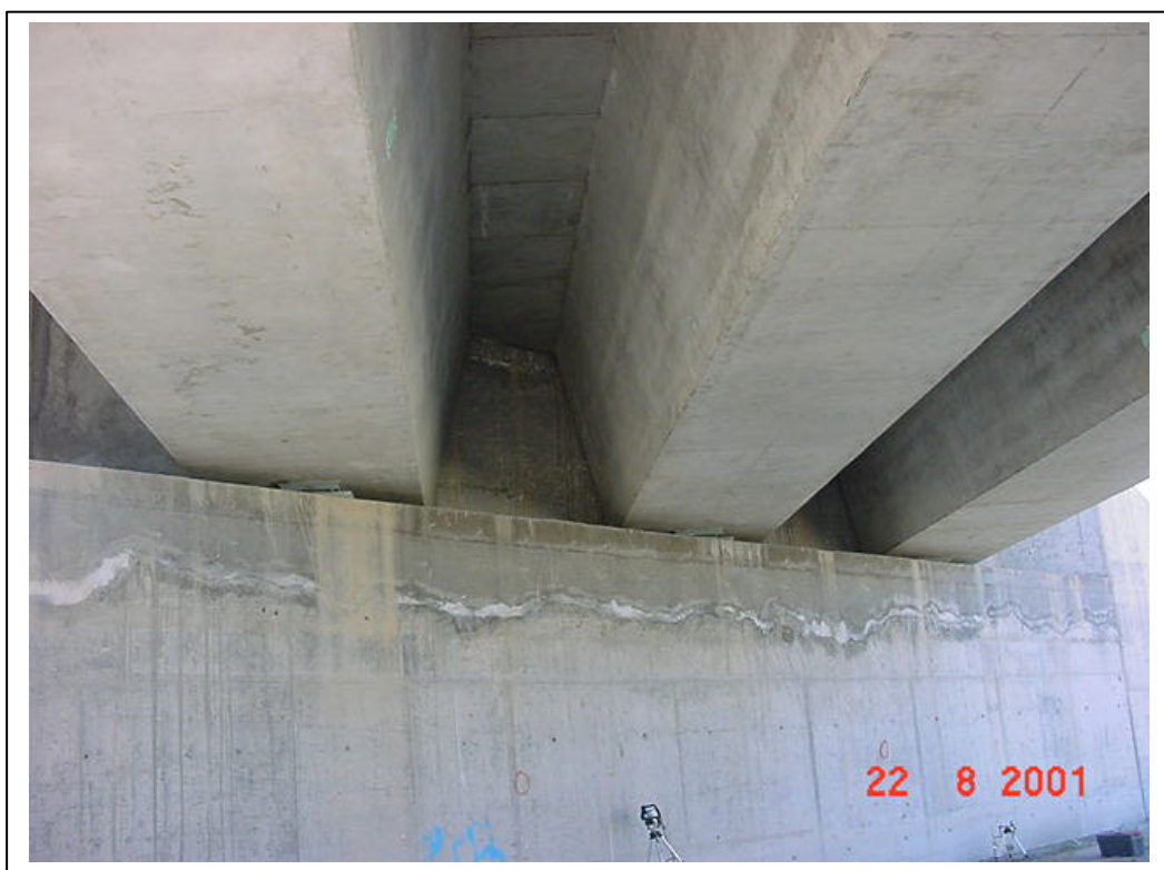
FOTOGRAFÍA 6: Detalle de estribo e instrumentación en estribo
