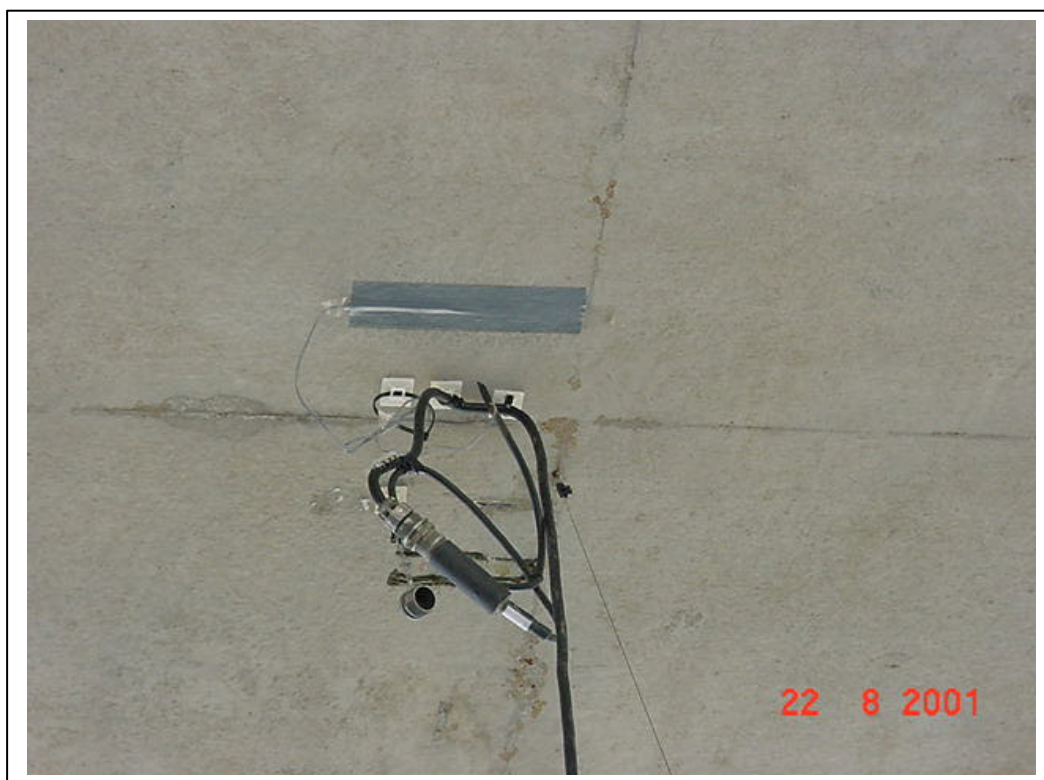
FOTOGRAFÍA 10: Transductor para medida de flechas
