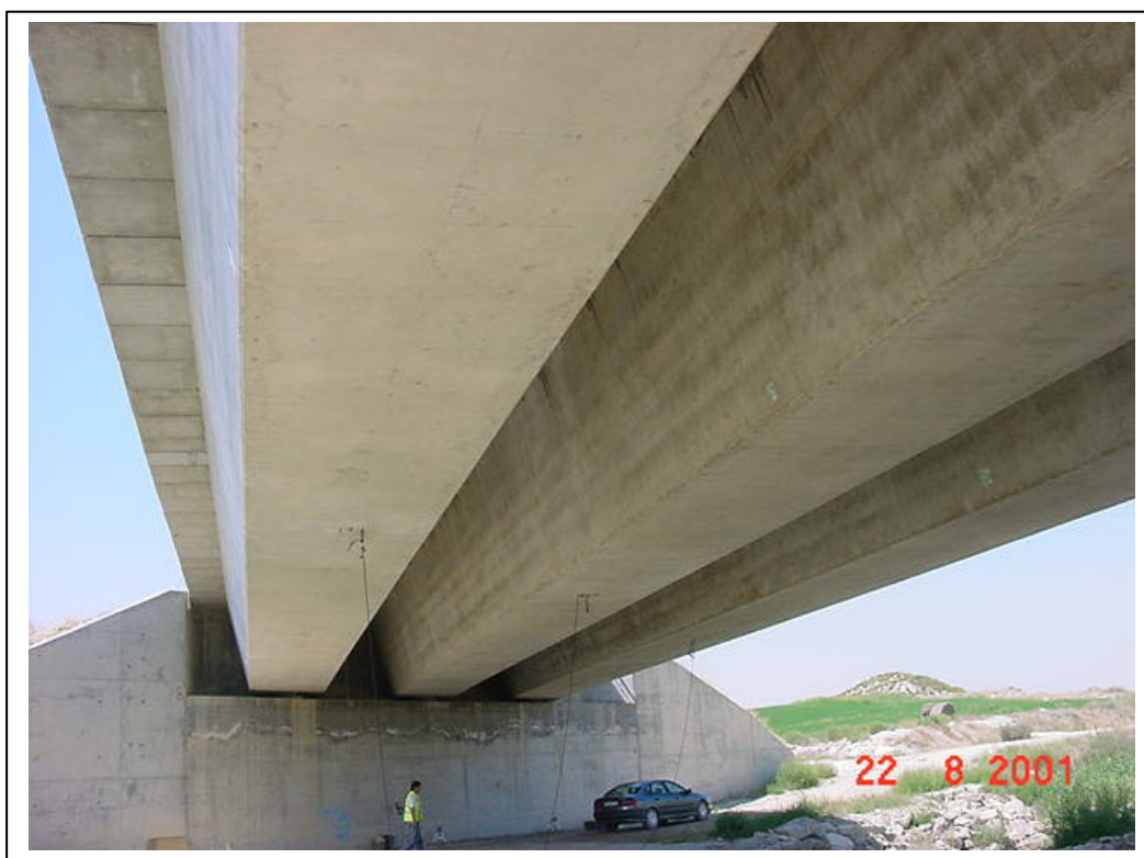
FOTOGRAFÍA 8: Instrumentación en centro de vano (1)
