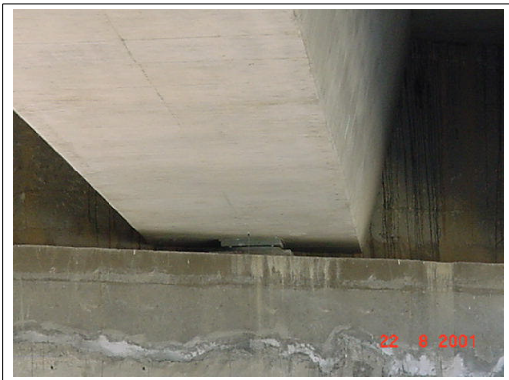
FOTOGRAFÍA 5: Detalle de apoyo
