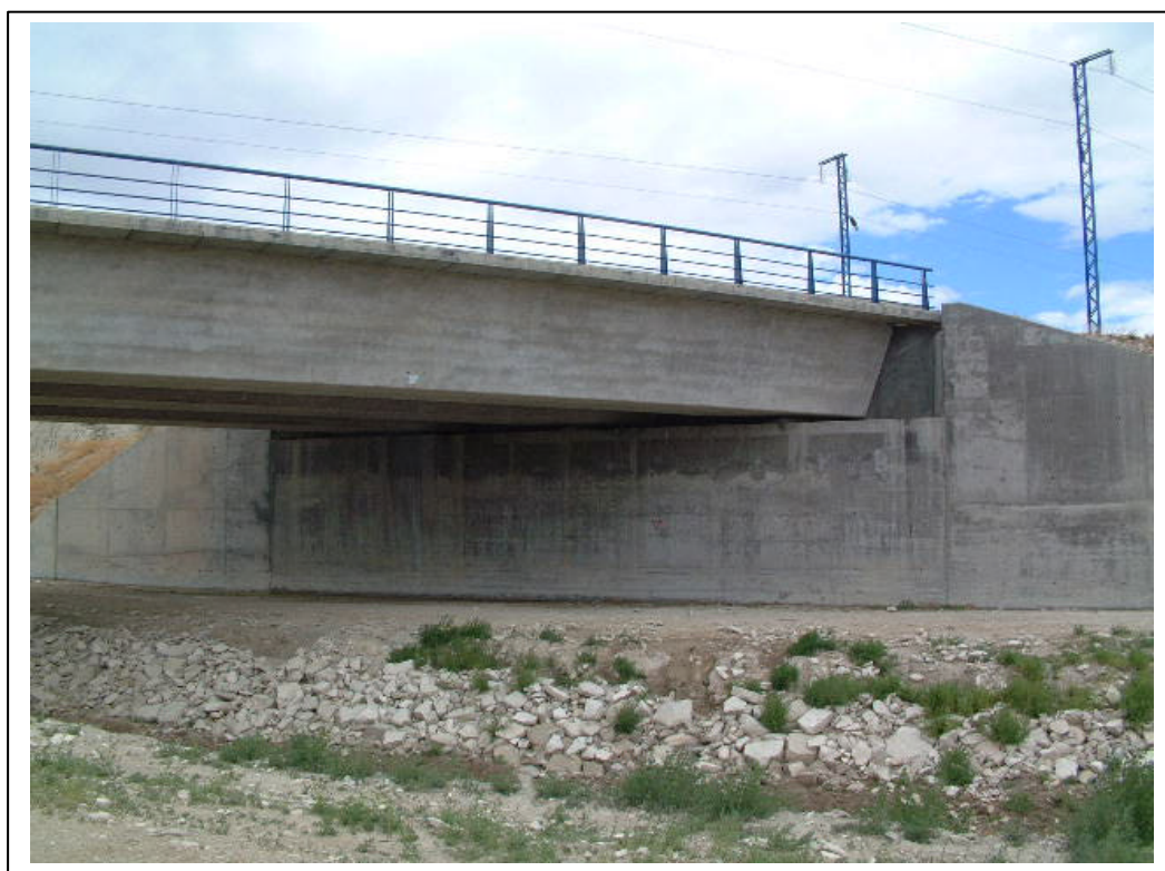
FOTOGRAFÍA 4: Vista de estribo y aletas
