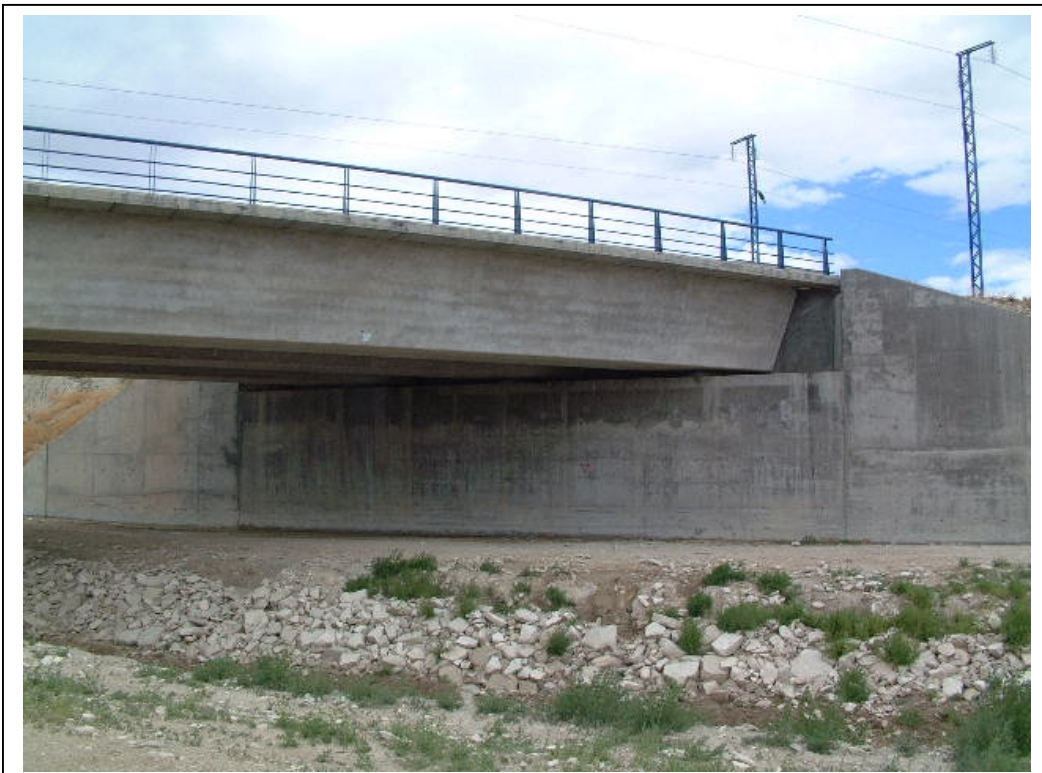
FOTOGRAFÍA Nº 6: ESTRIBO DE SALIDA
