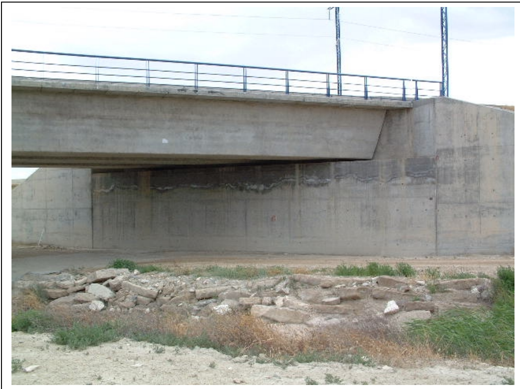
FOTOGRAFÍA Nº 5: ESTRIBO DE ENTRADA
