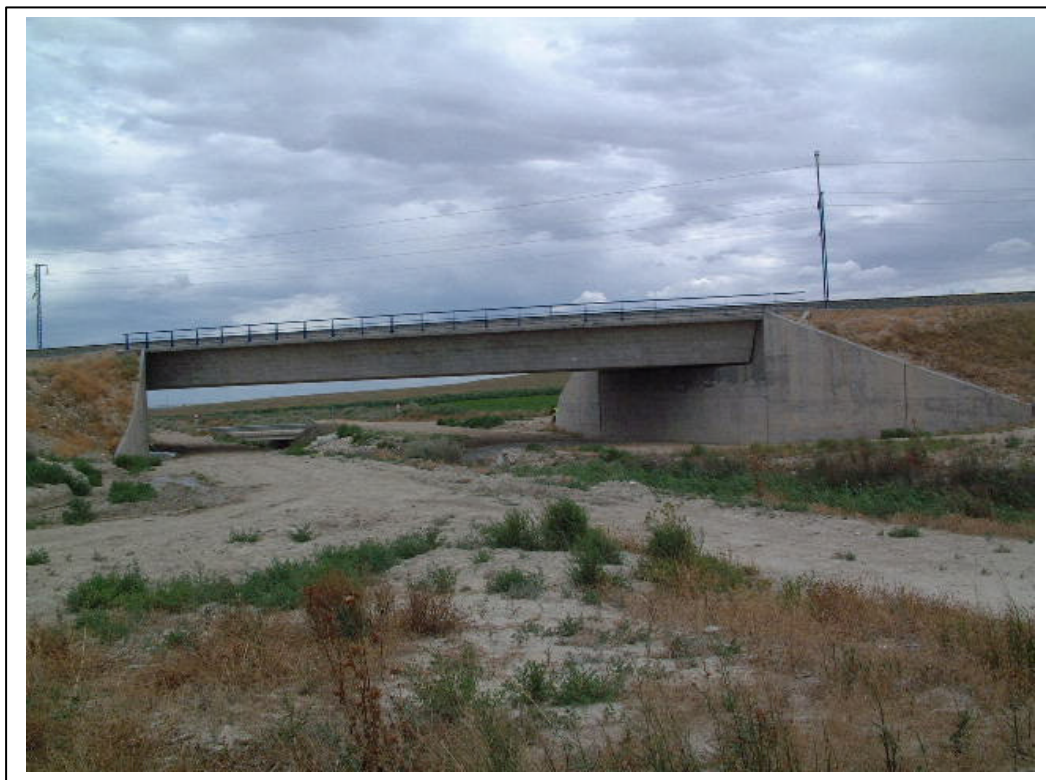
FOTOGRAFÍA 1: Vista general del puente
