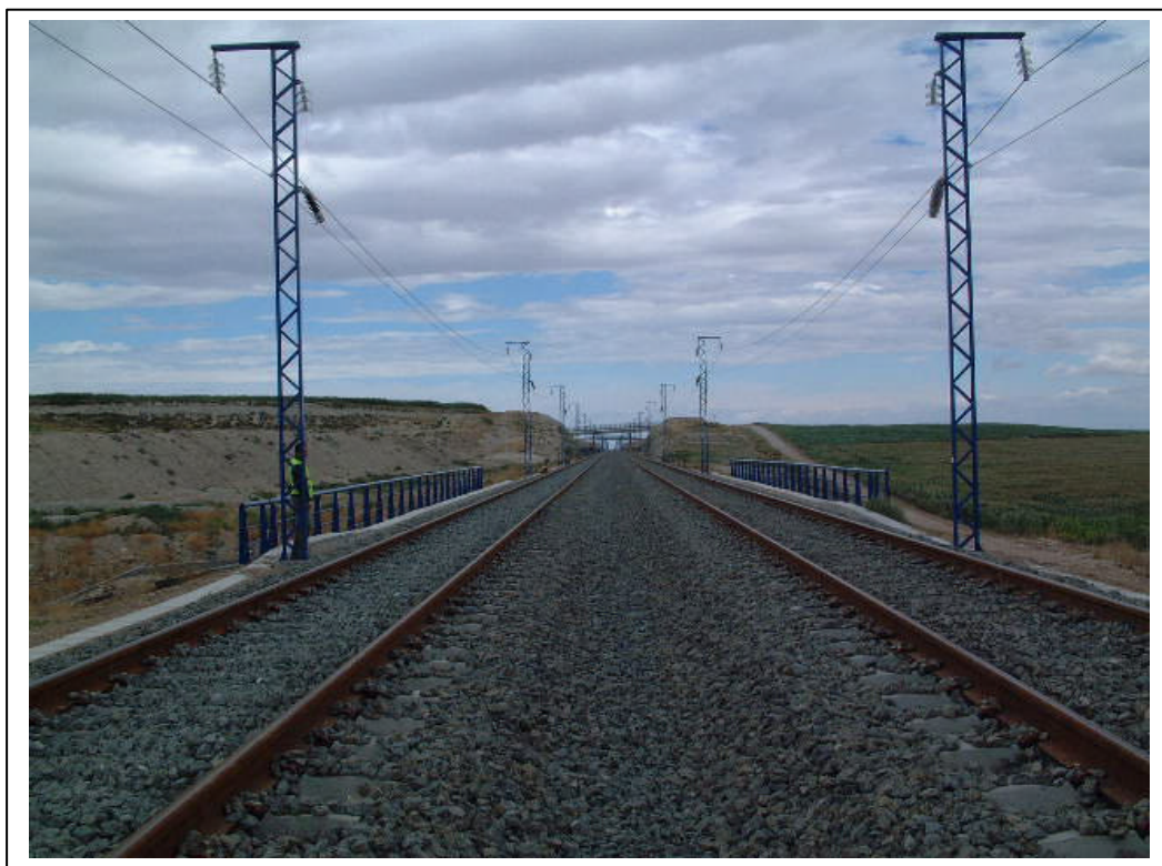
FOTOGRAFÍA 2: Vista superior del tablero
