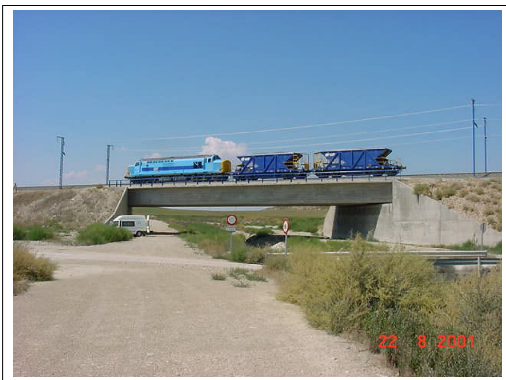
FOTOGRAFÍA 13: Tren de cargas sobre la estructura en vía 1
