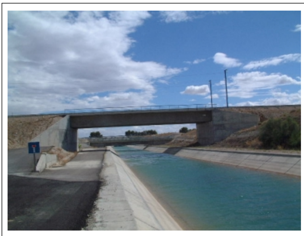
FOTOGRAFÍA 1: Vista general de la estructura
