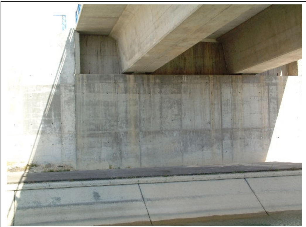
FOTOGRAFÍA Nº 6: ESTRIBO DE SALIDA
