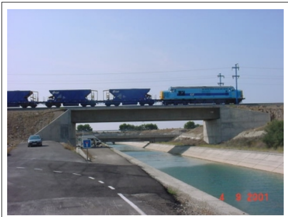
FOTOGRAFÍA 8: Tren de cargas sobre la estructura
