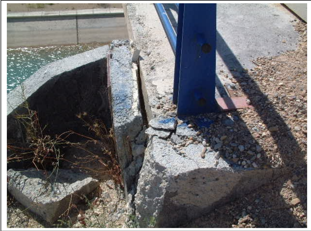
FOTOGRAFÍA Nº 9: DETALLE ESPALDÓN ESTRIBO DE SALIDA LD
