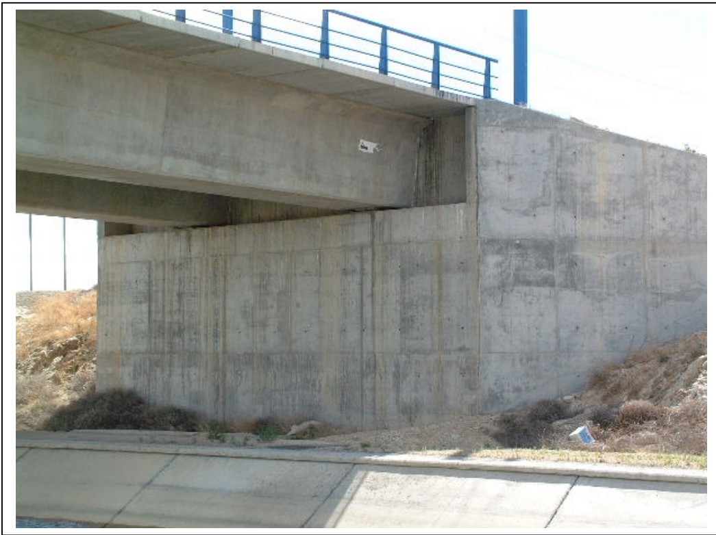
FOTOGRAFÍA Nº 5: ESTRIBO DE ENTRADA
