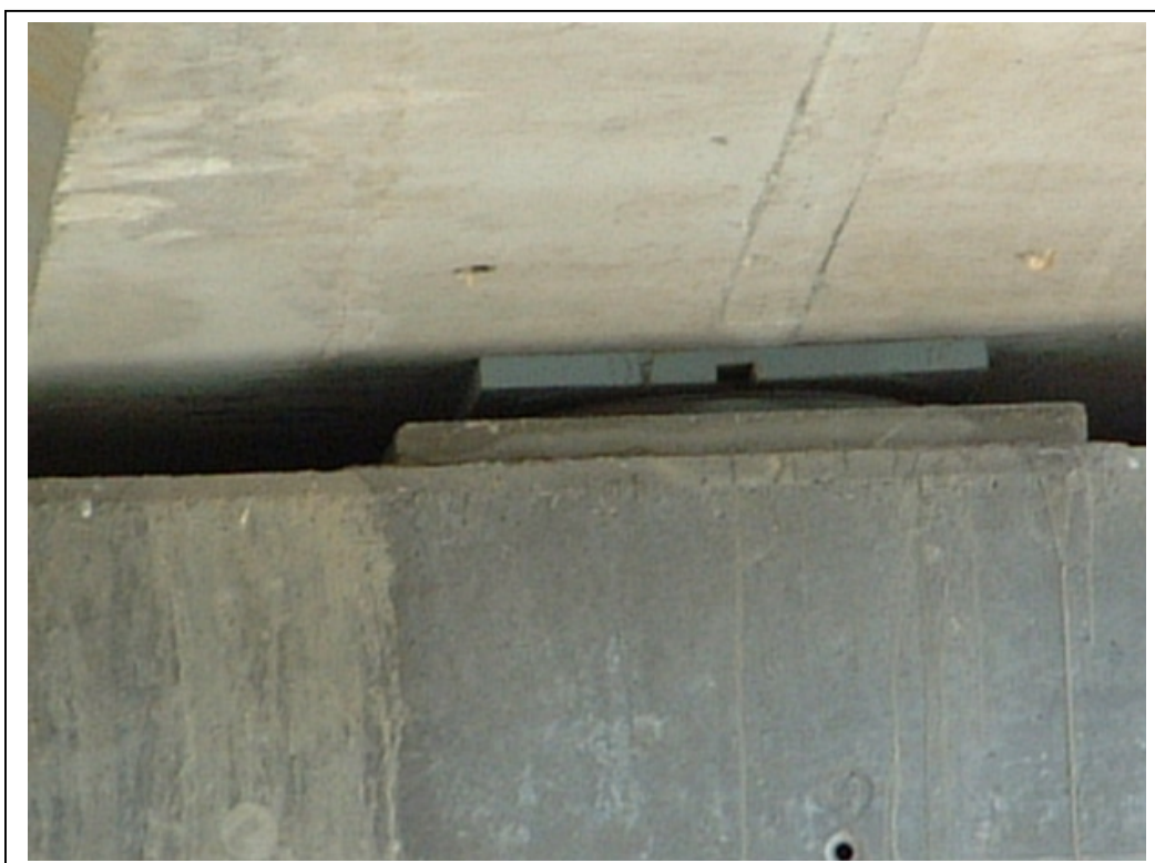
FOTOGRAFÍA N° 8: DETALLE APOYO ESTRIBO DE SALIDA
