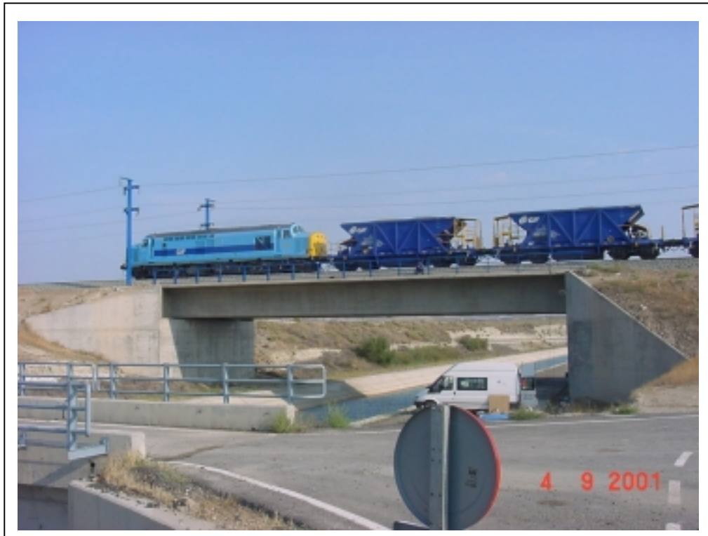
FOTOGRAFÍA 7: Tren de cargas sobre la estructura
