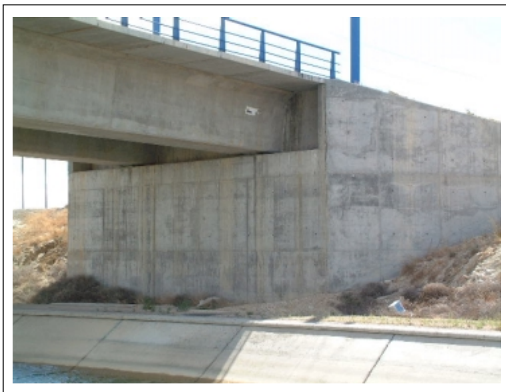
FOTOGRAFÍA 4: Vista de estribo y aleta
