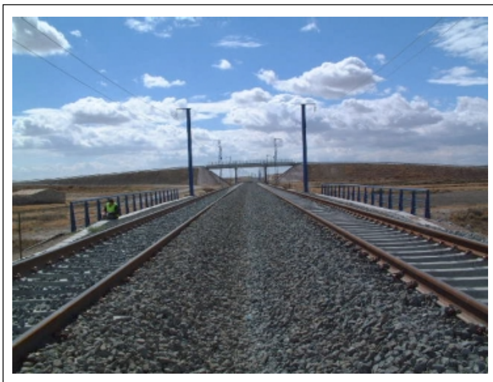
FOTOGRAFÍA 2: Vista superior del tablero
