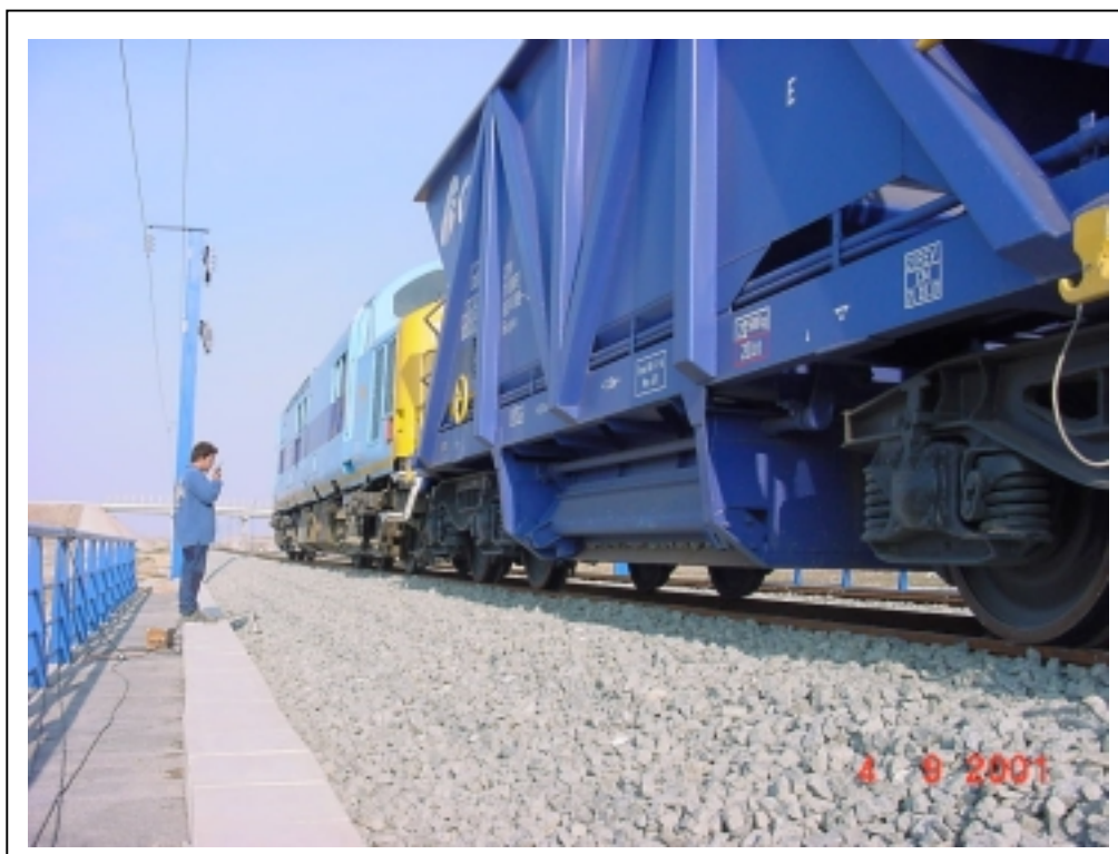
FOTOGRAFÍA 9: Posicionamiento de trenes
