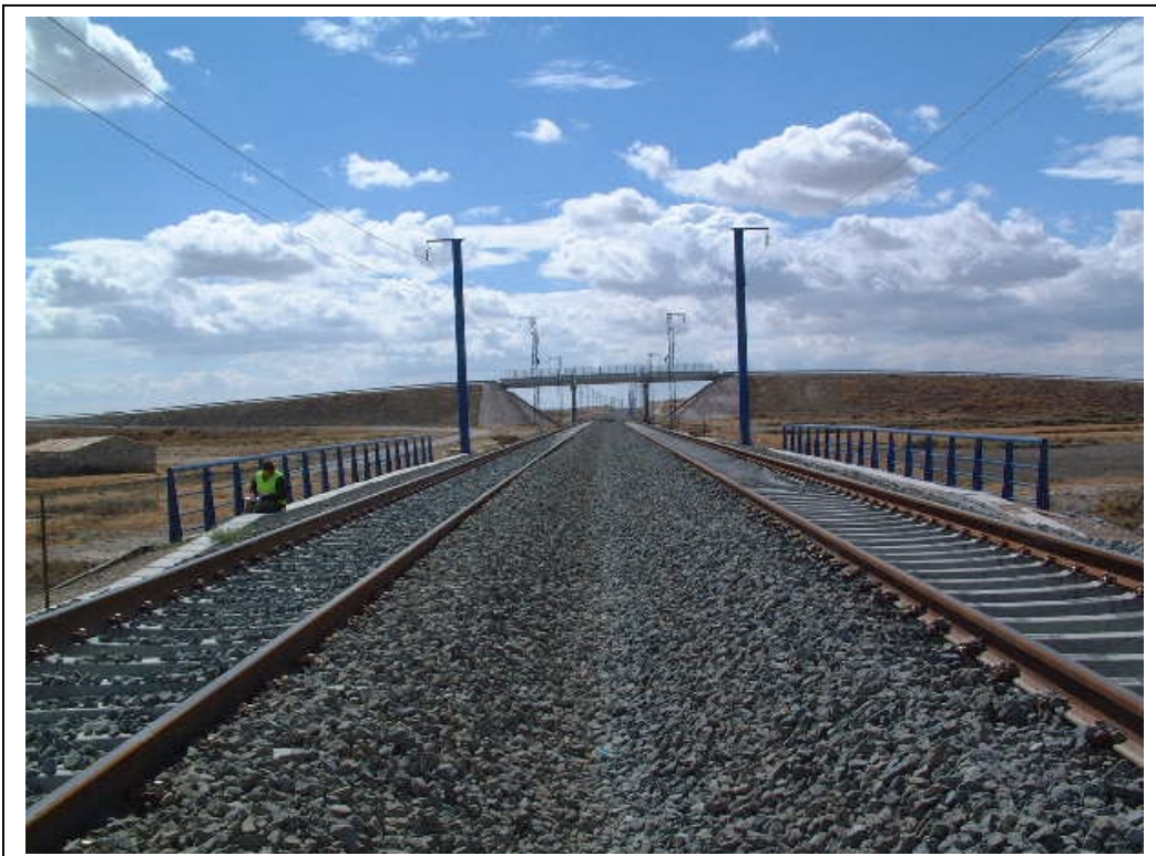
FOTOGRAFÍA Nº 4: VISTA SUPERIOR DESDE SALIDA
