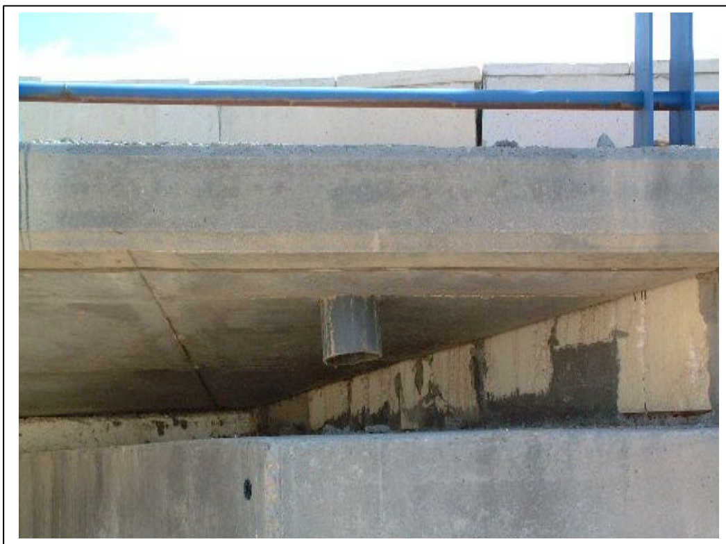
FOTOGRAFÍA Nº 9: DETALLE DESAGÜE SOBRE ESTRIBO DE ENTRADA LI.
