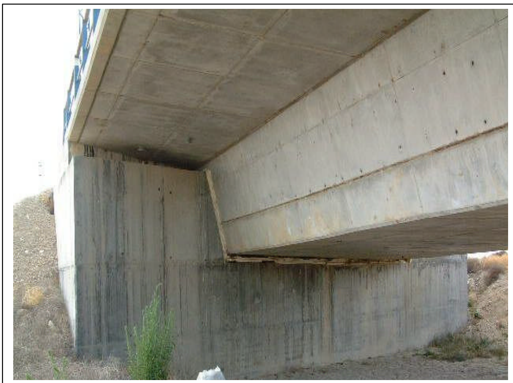
FOTOGRAFÍA Nº 5: ESTRIBO DE ENTRADA
