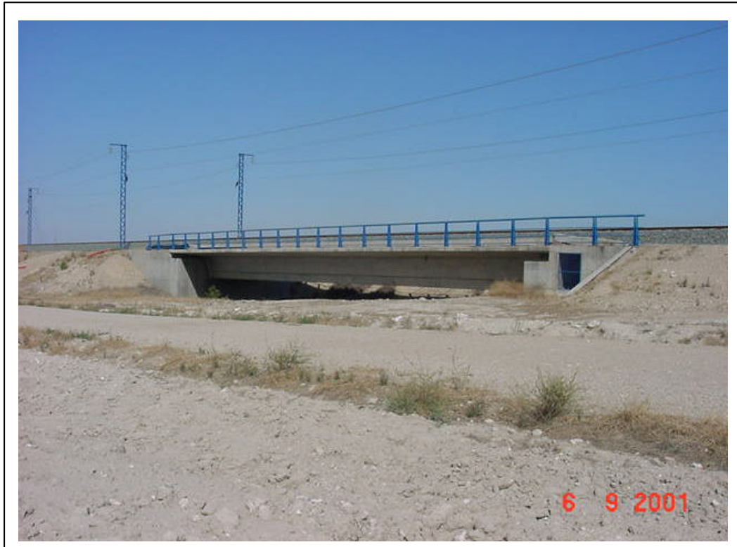
FOTOGRAFÍA 1: Vista general del puente
