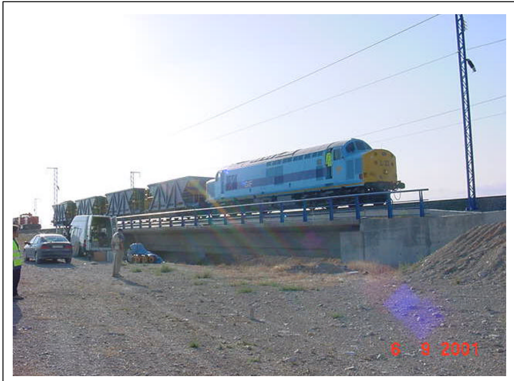
FOTOGRAFÍA 9: Prueba estática con una sólo vía cargada
