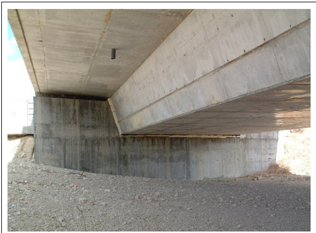
FOTOGRAFÍA 4: Vista de estribo
