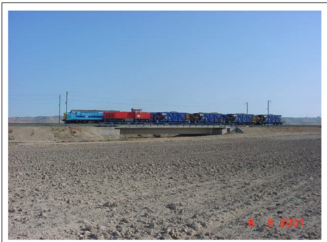
FOTOGRAFÍA 10: Prueba estática con ambas vías cargadas
