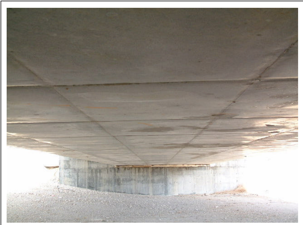
FOTOGRAFÍA 3: Vista inferior del tablero
