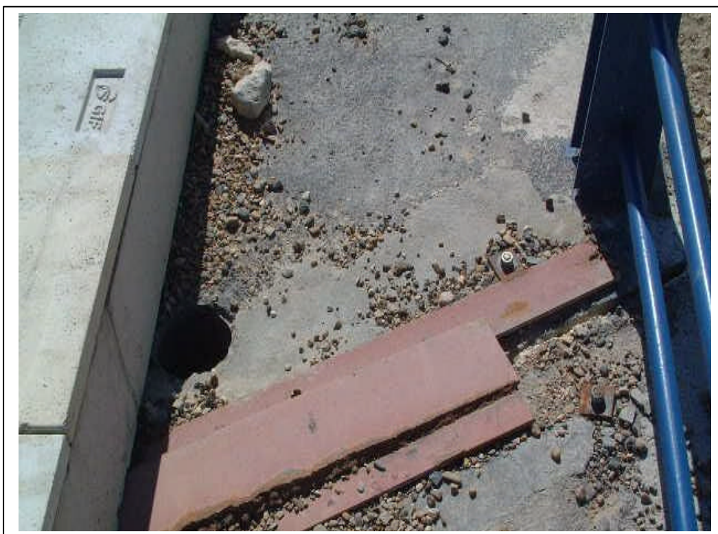
FOTOGRAFÍA Nº 10: DETALLE JUNTA SOBRE ESTRIBO DE SALIDA LI.
