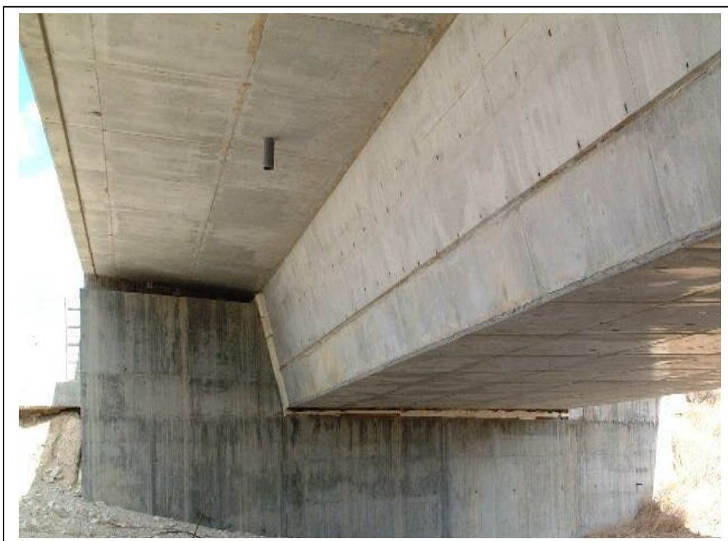
FOTOGRAFÍA Nº 6: ESTRIBO DE SALIDA
