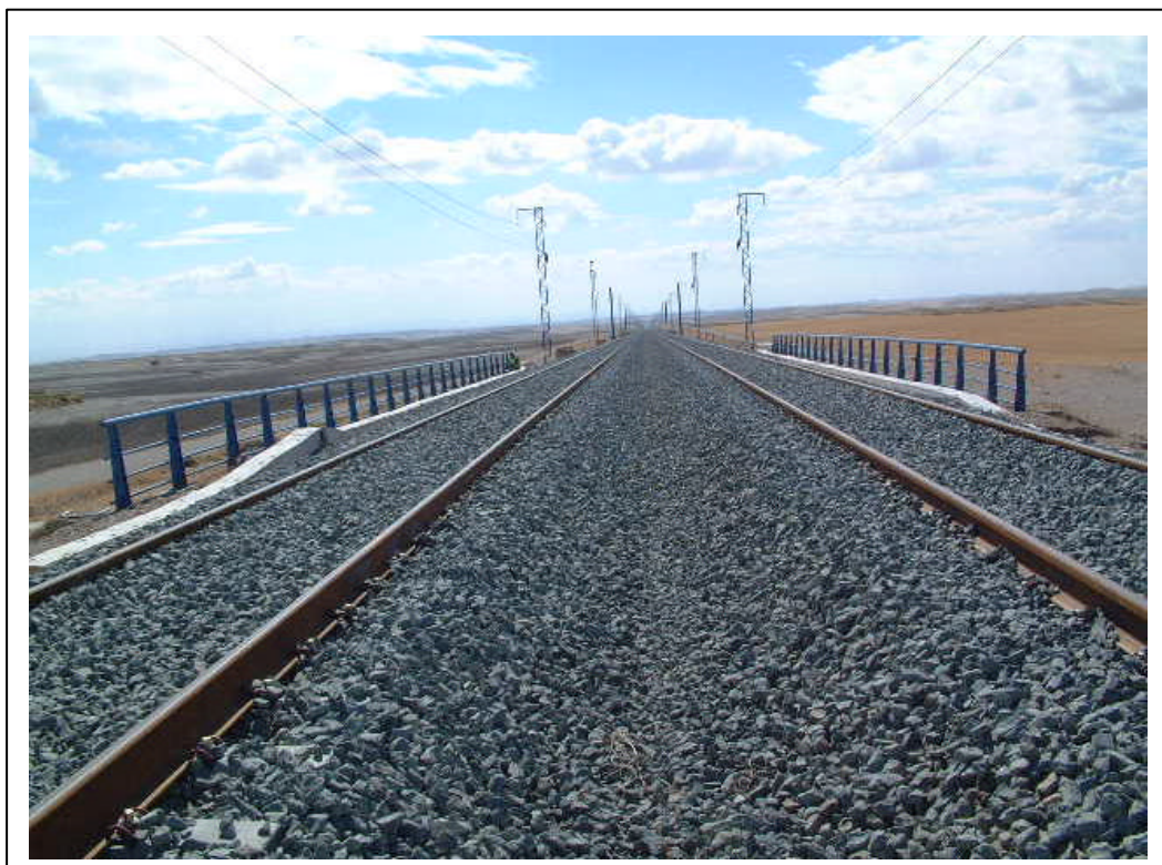
FOTOGRAFÍA 2: Vista superior del tablero
