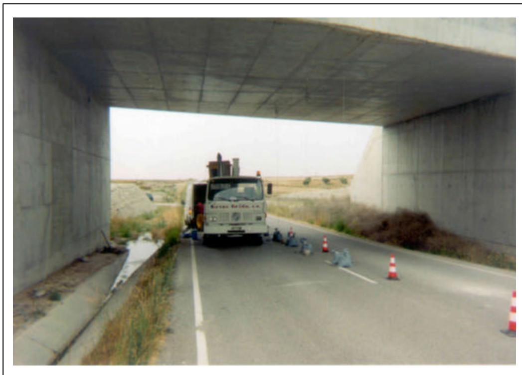
FOTOGRAFÍA 9: Disposición de transductores en centro de vano
