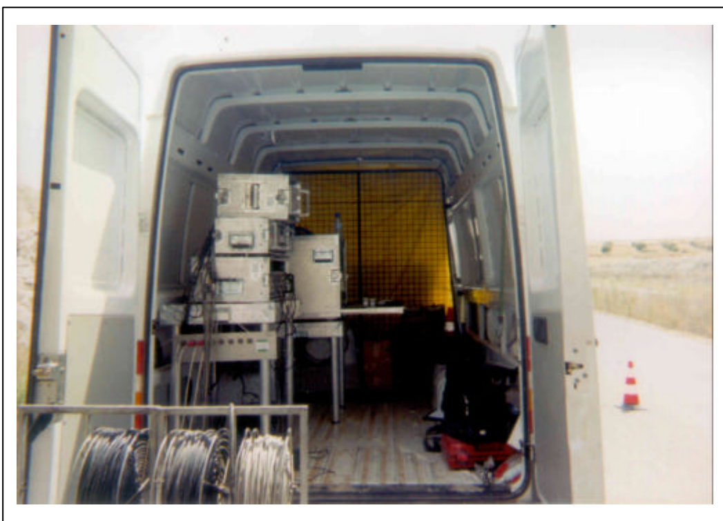
FOTOGRAFÍA 6: Equipos de adquisición de datos
