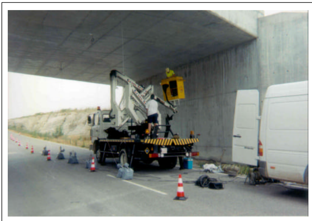
FOTOGRAFÍA 5: Colocación de aparatos de medida
