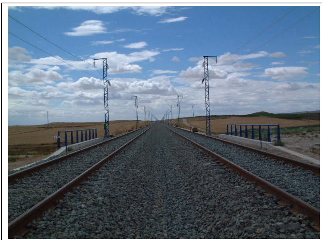
FOTOGRAFÍA Nº 4: VISTA SUPERIOR DESDE SALIDA
