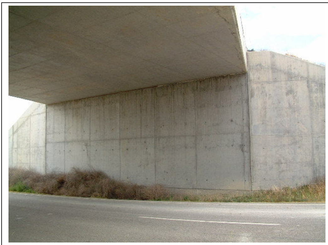
FOTOGRAFÍA Nº 5: ESTRIBO DE ENTRADA
