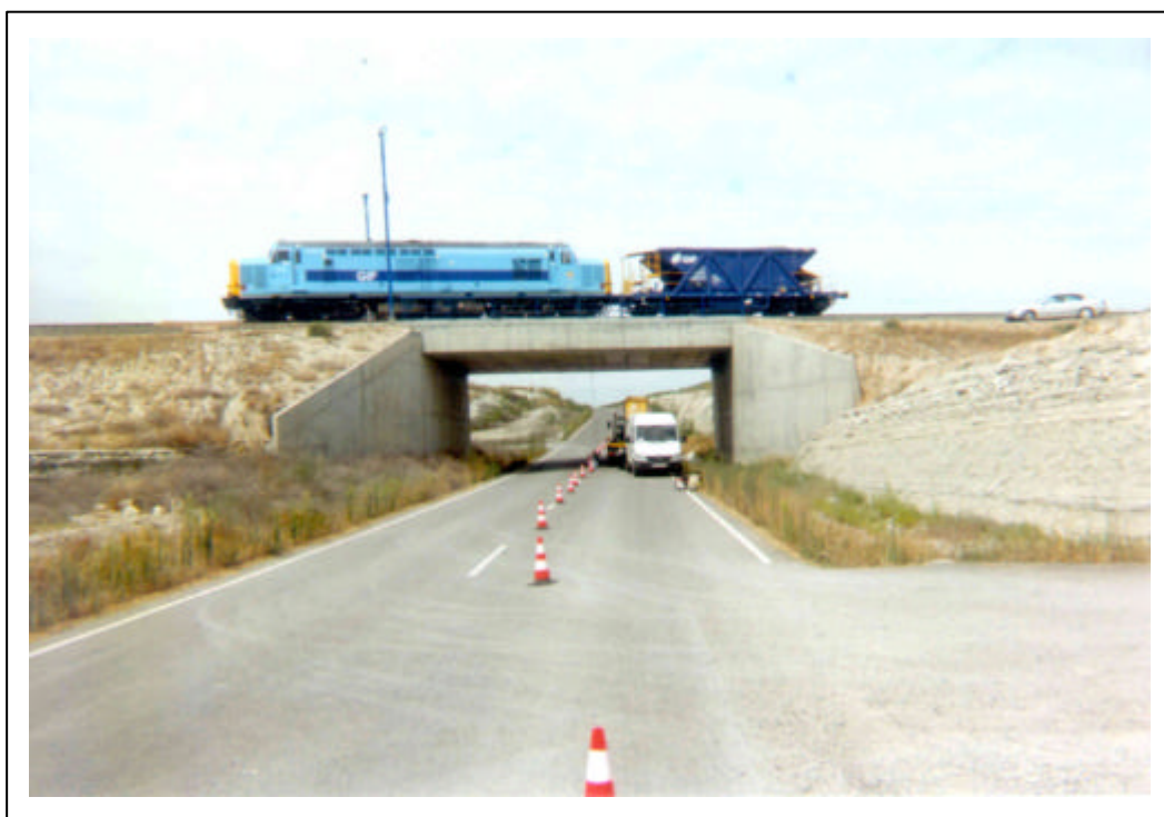
FOTOGRAFÍA 10: Tren de cargas sobre la estructura
