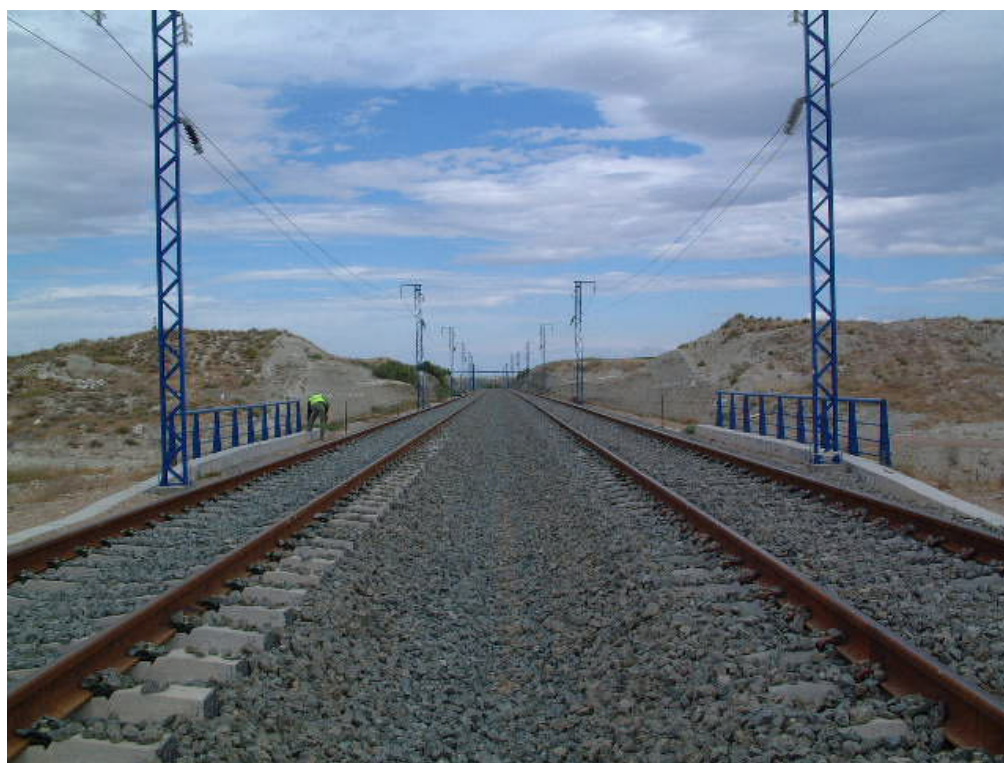
FOTOGRAFÍA 2: Vista superior del tablero
