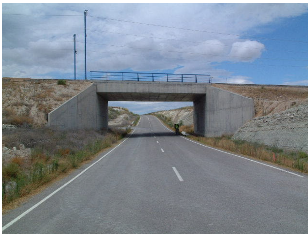
FOTOGRAFÍA 1: Vista general del puente
