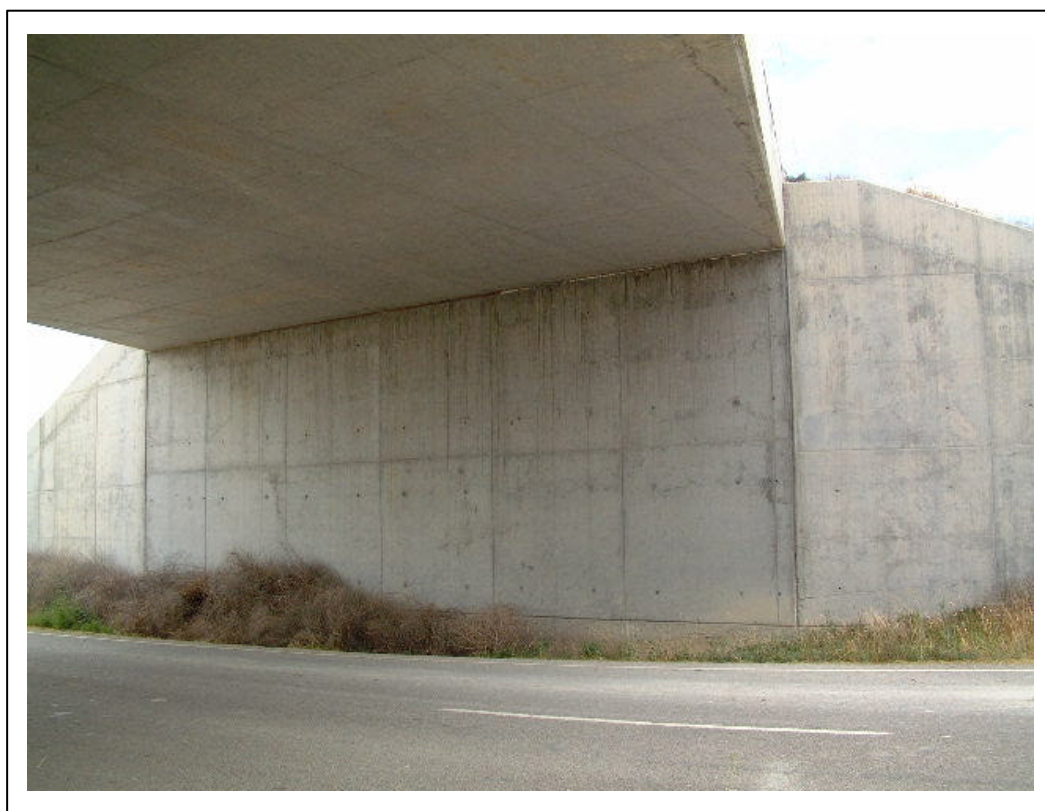
FOTOGRAFÍA 4: Vista de estribo y aleta
