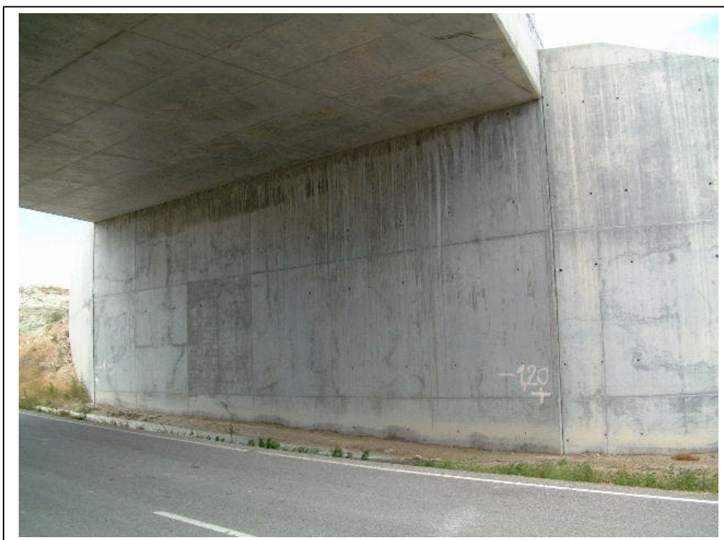
FOTOGRAFÍA Nº 6: ESTRIBO DE SALIDA
