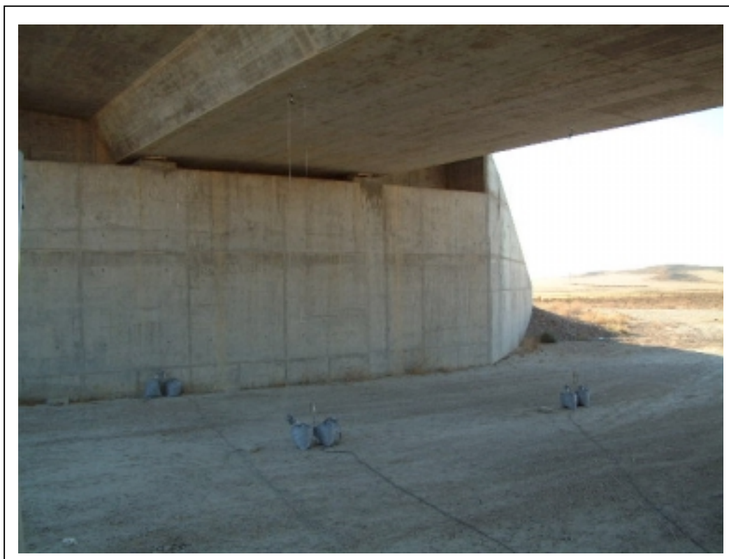
FOTOGRAFÍA 5: Instrumentación en centro de vano
