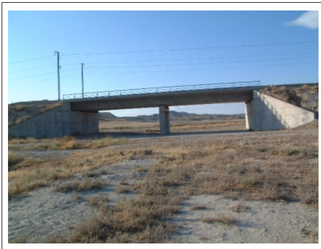
FOTOGRAFÍA 1: Vista general del puente
