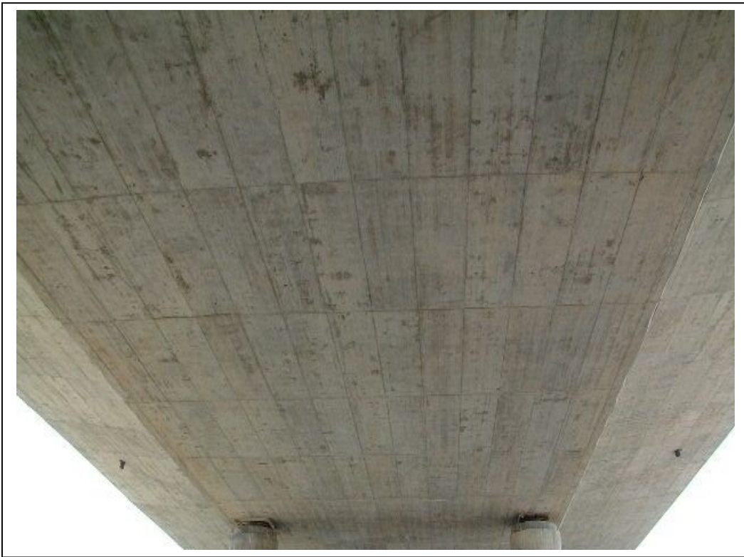
FOTOGRAFÍA N° 7: VISTA INFERIOR DESDE EL ESTRIBO DE ENTRADA
