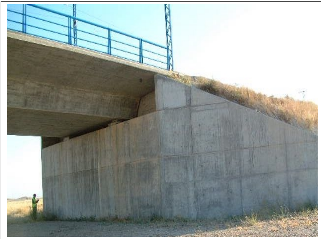
FOTOGRAFÍA Nº 5: ESTRIBO DE ENTRADA
