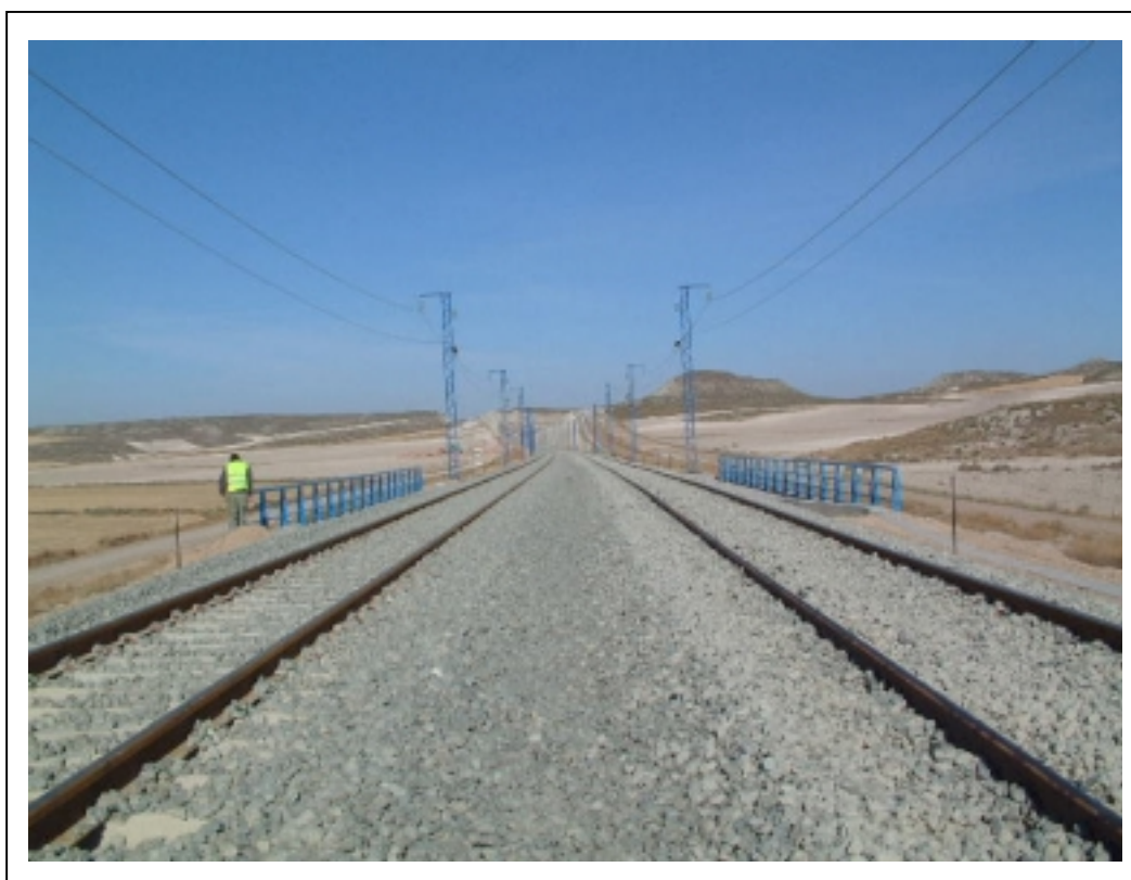
FOTOGRAFÍA 2: Vista superior del tablero
