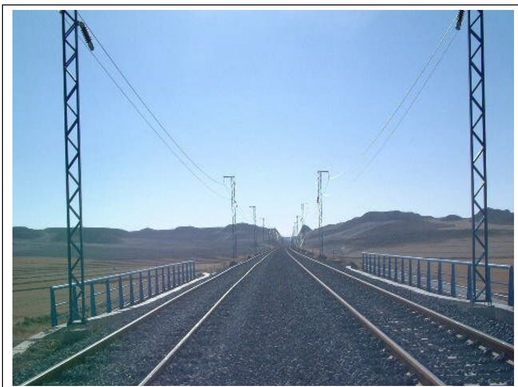
FOTOGRAFÍA Nº 4: VISTA SUPERIOR DESDE SALIDA
