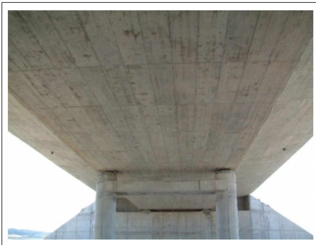
FOTOGRAFÍA 3: Vista inferior del puente
