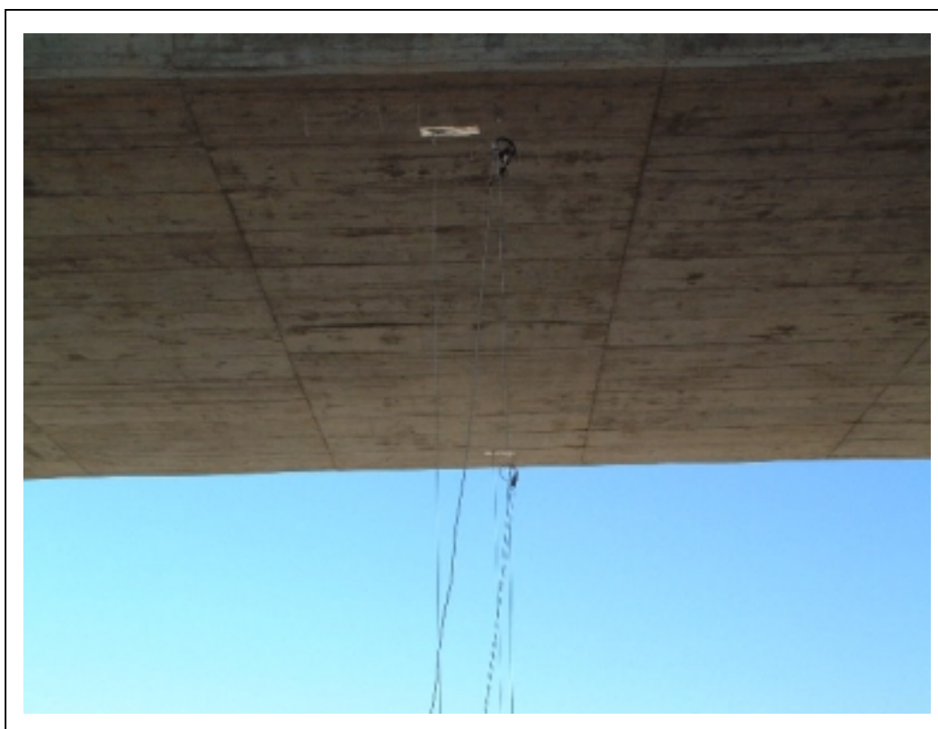
FOTOGRAFÍA 6: Instrumentación en centro de vano
