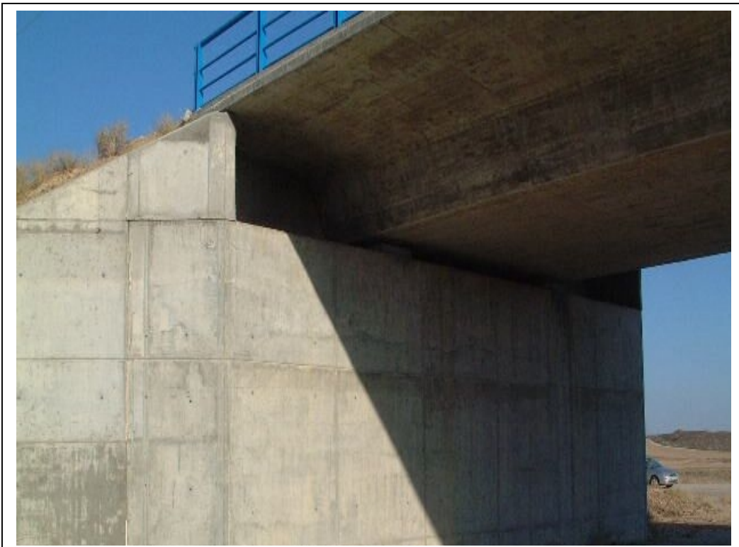
FOTOGRAFÍA Nº 6: ESTRIBO DE SALIDA
