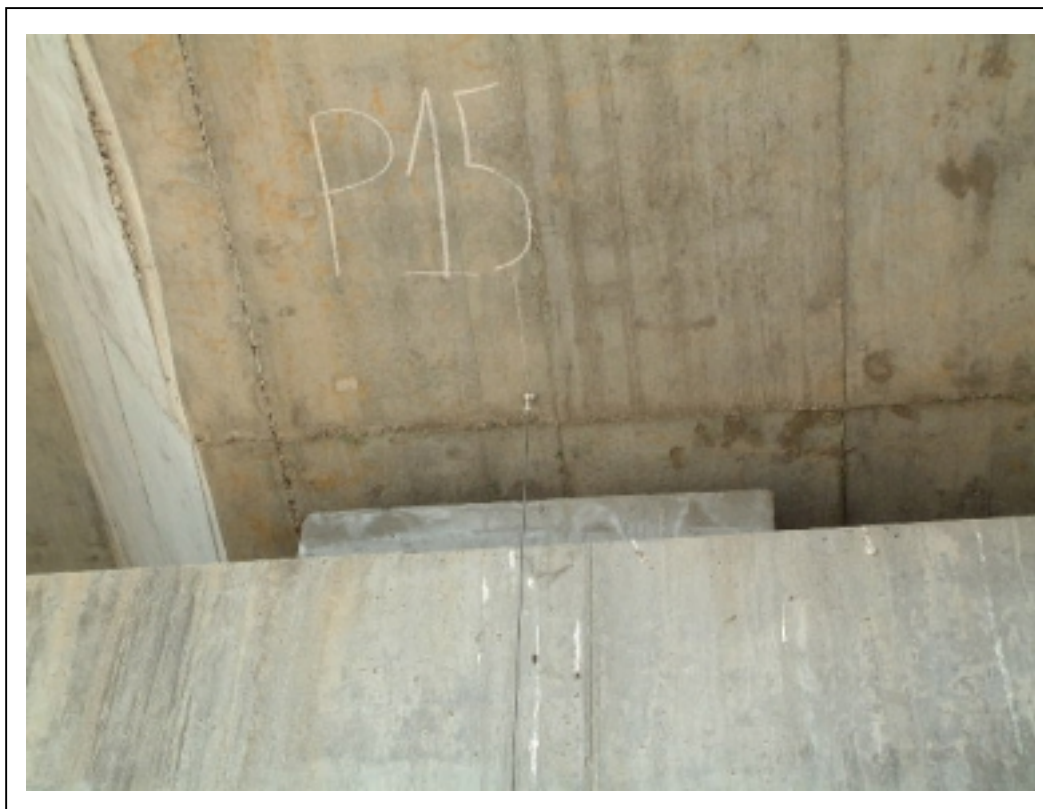
FOTOGRAFÍA 9: Transductor de desplazamiento junto a apoyo
