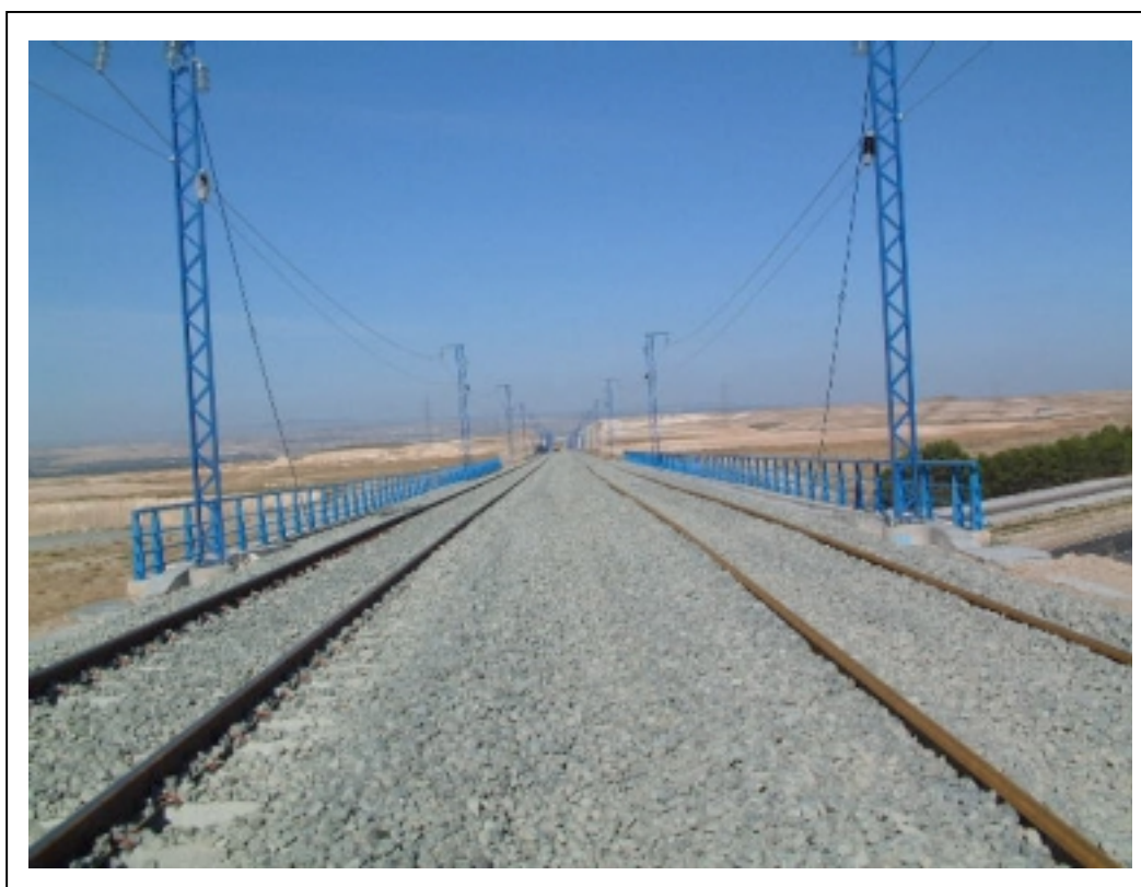
FOTOGRAFÍA 2: Vista superior del tablero
