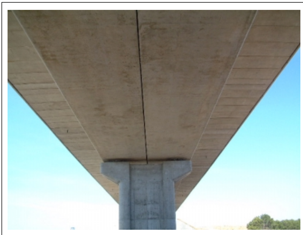
FOTOGRAFÍA 3: Vista inferior del puente
