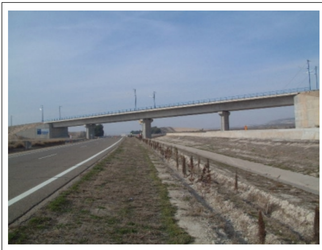
FOTOGRAFÍA 1: Vista general del puente
