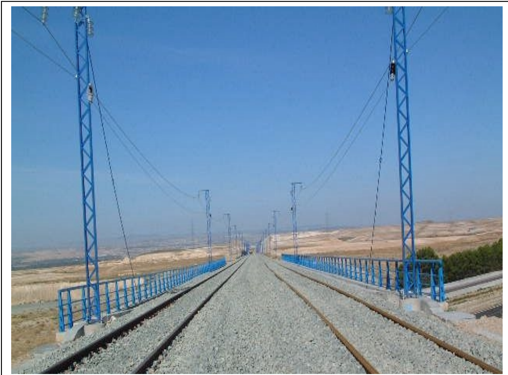
FOTOGRAFÍA Nº 4: VISTA SUPERIOR DESDE SALIDA
