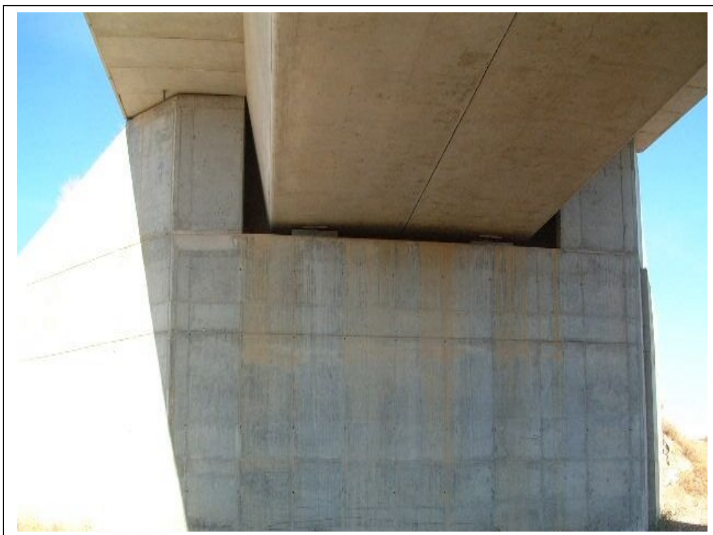
FOTOGRAFÍA Nº 5: ESTRIBO DE ENTRADA
