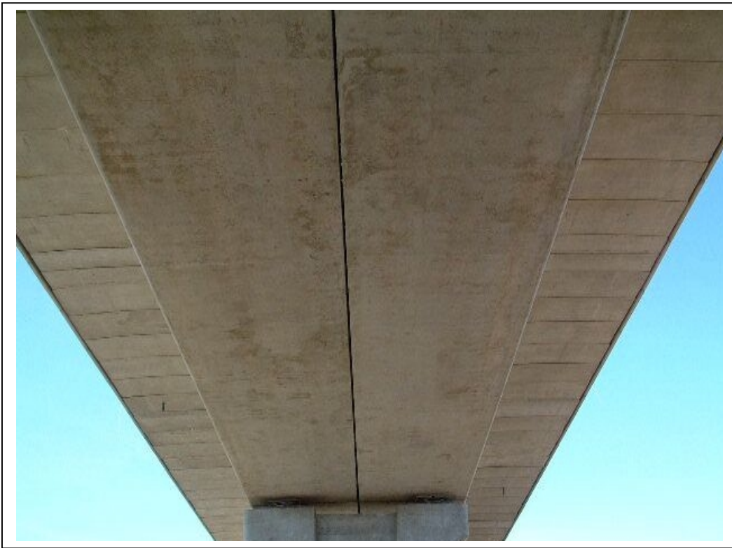
FOTOGRAFÍA N° 7: VISTA INFERIOR EN TRAMO 4 DESDE LA SALIDA
