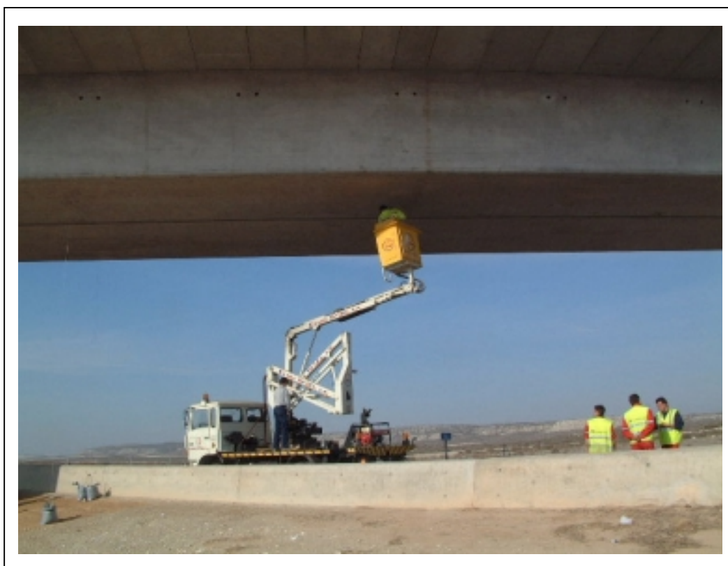
FOTOGRAFÍA 6: Equipo auxiliar para colocación aparatos
