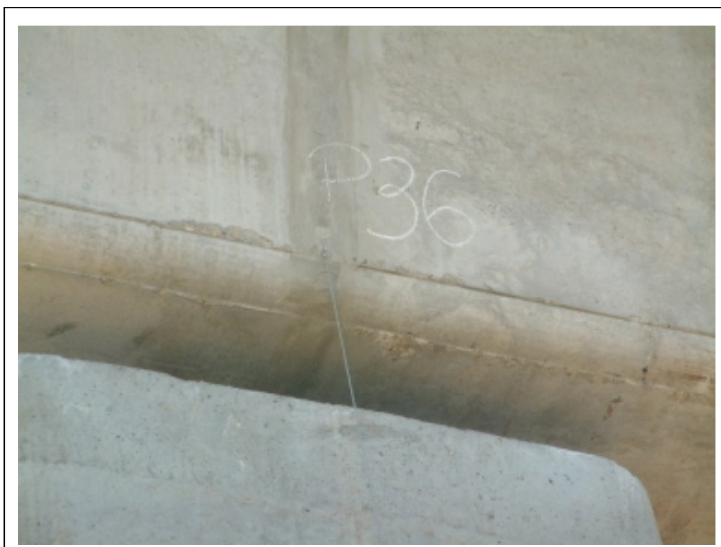
FOTOGRAFÍA 10: Instrumentación en apoyo
