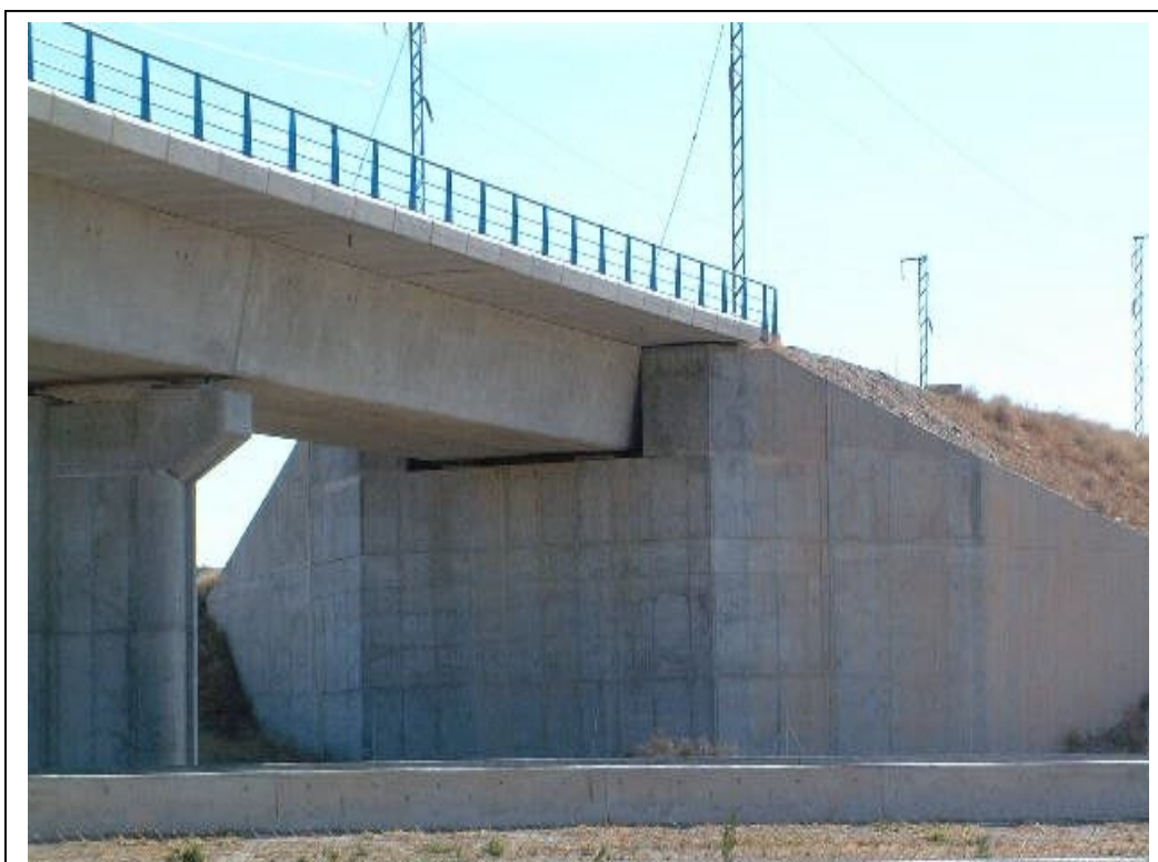
FOTOGRAFÍA Nº 6: ESTRIBO DE SALIDA
