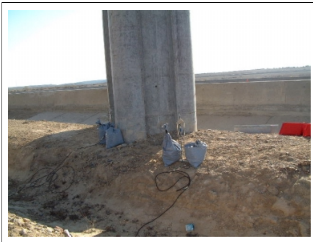
FOTOGRAFÍA 9: Transductores de desplazamiento junto a pila
