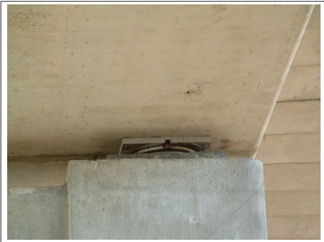
FOTOGRAFÍA Nº 9: APOYO EN PILA 4 EN EL LADO IZQUIERDO
