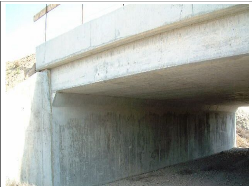
FOTOGRAFÍA Nº 6: ESTRIBO DE SALIDA
