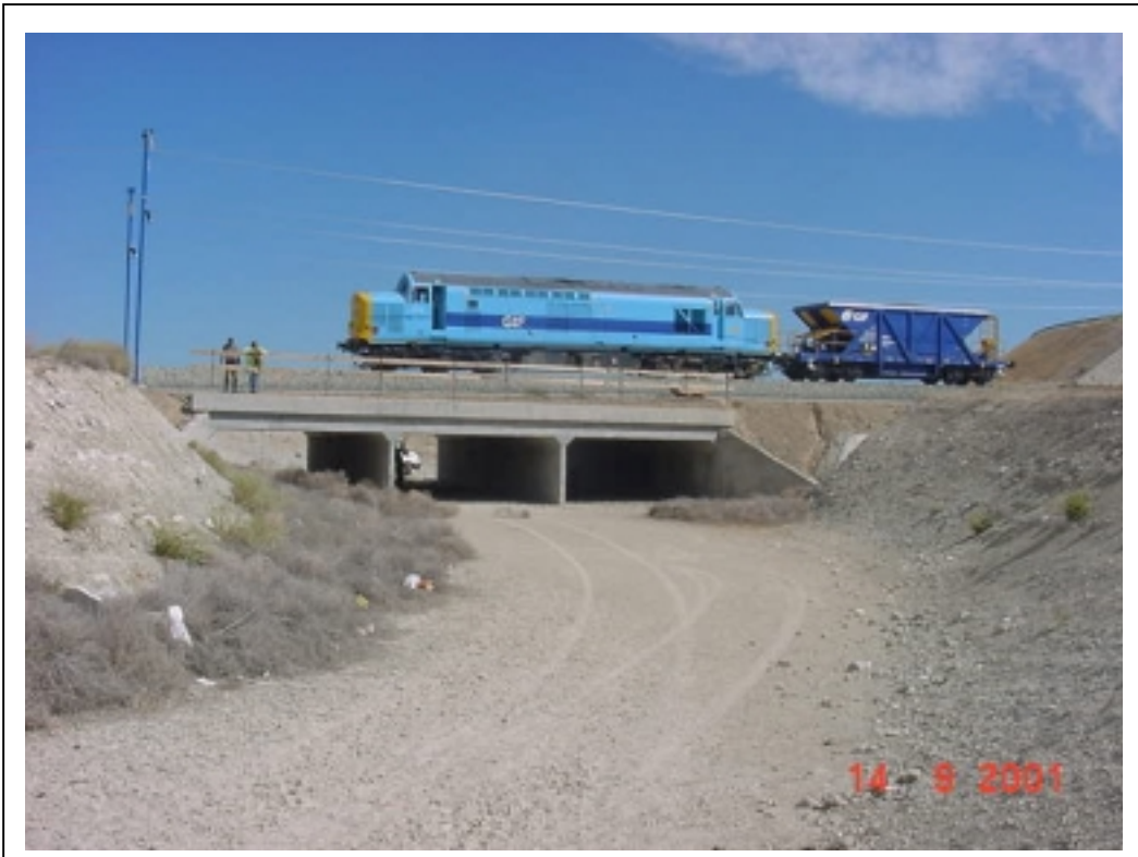
FOTOGRAFÍA 9: Posición estática (ejes locomotora en vano 2)
