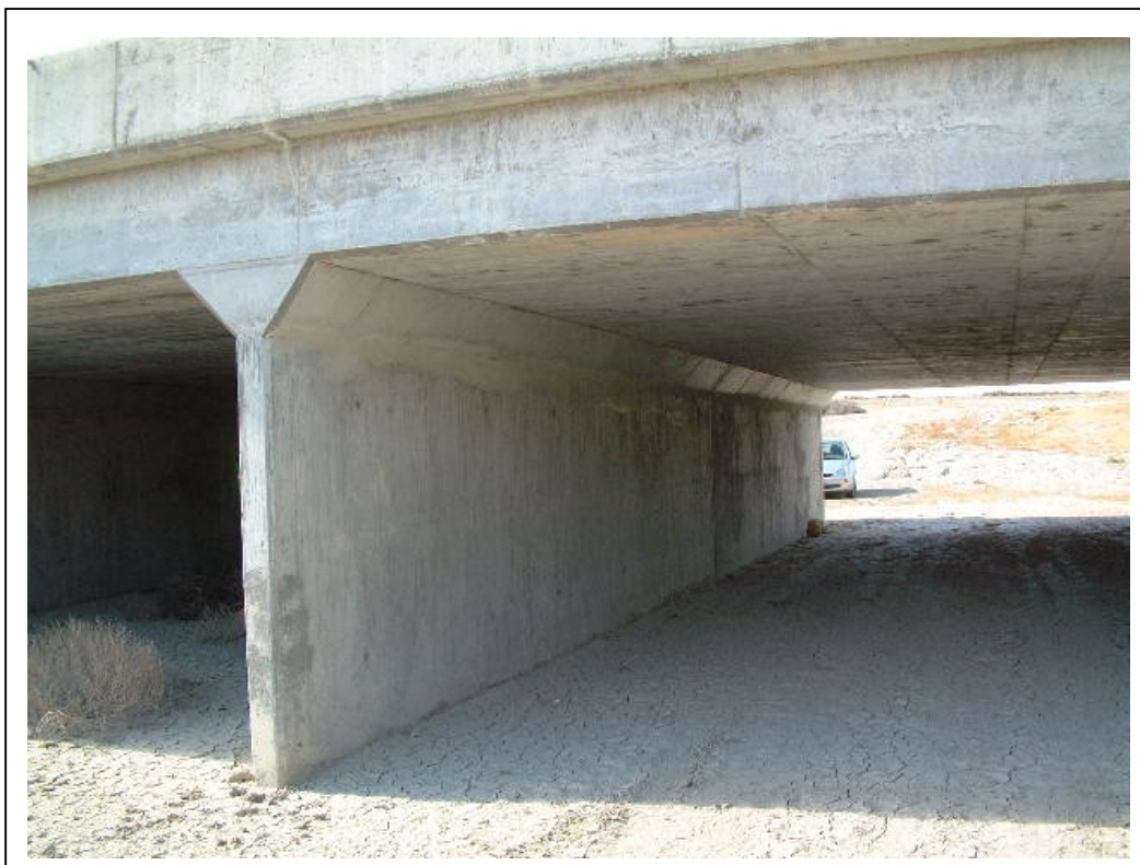
FOTOGRAFÍA 3: Vista inferior del tablero
