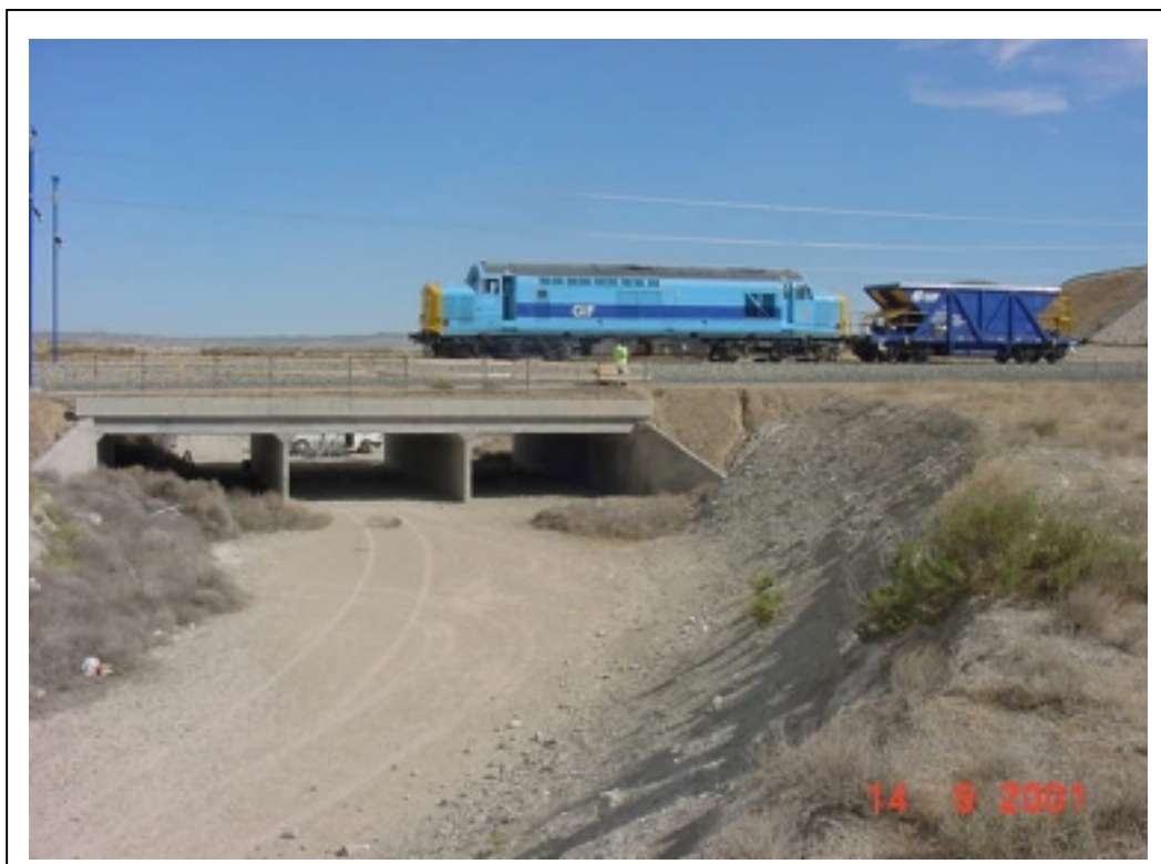
FOTOGRAFÍA 8: Posición estática (ejes locomotora en vano 3)
