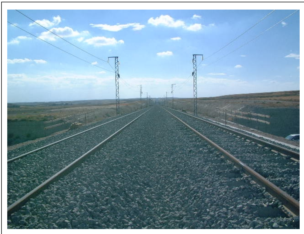
FOTOGRAFÍA 2: Vista superior del tablero
