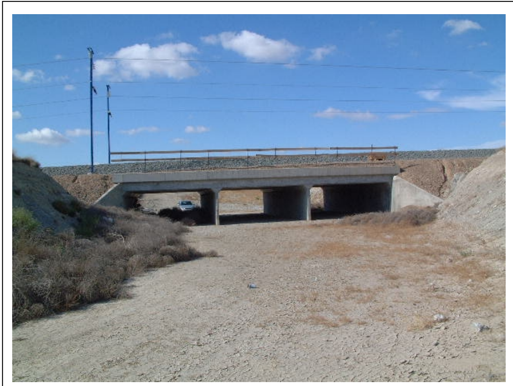
FOTOGRAFÍA 1: Vista general del puente
