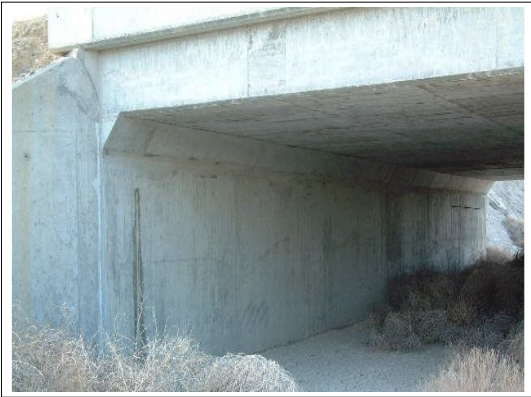
FOTOGRAFÍA Nº 5: ESTRIBO DE ENTRADA
