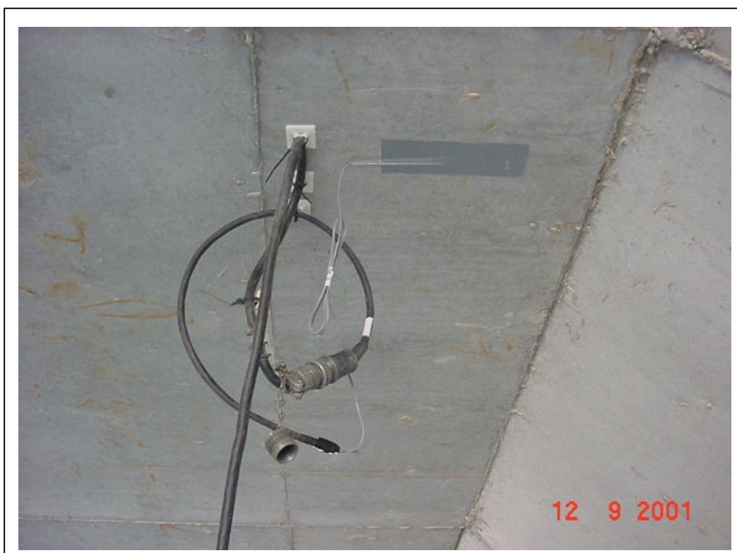
FOTOGRAFÍA 5: Detalle transductor y galga en centro de vano
