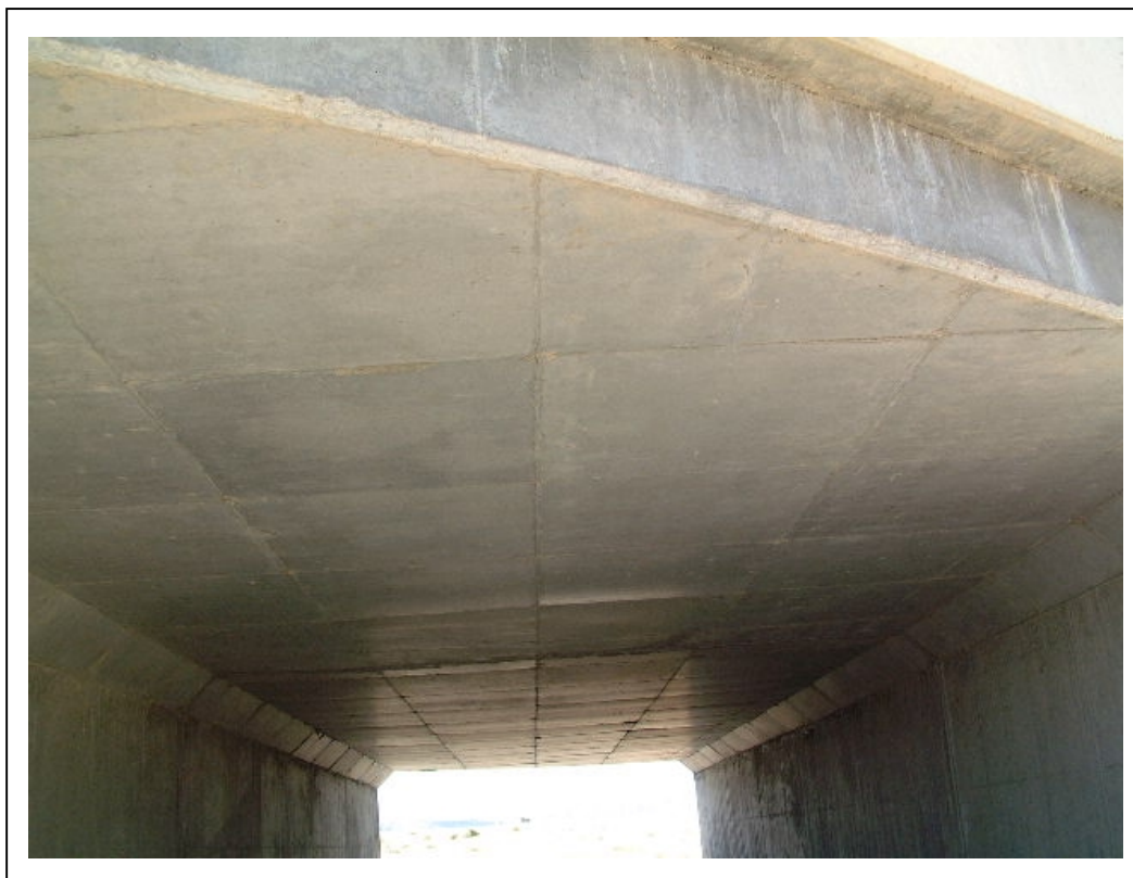
FOTOGRAFÍA 3: Vista inferior del tablero
