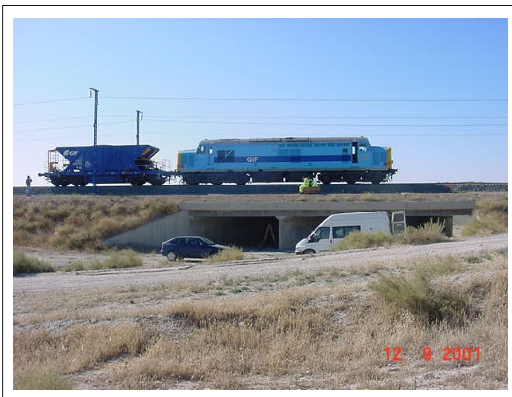
FOTOGRAFÍA 8: Tren de cargas sobre la estructura
