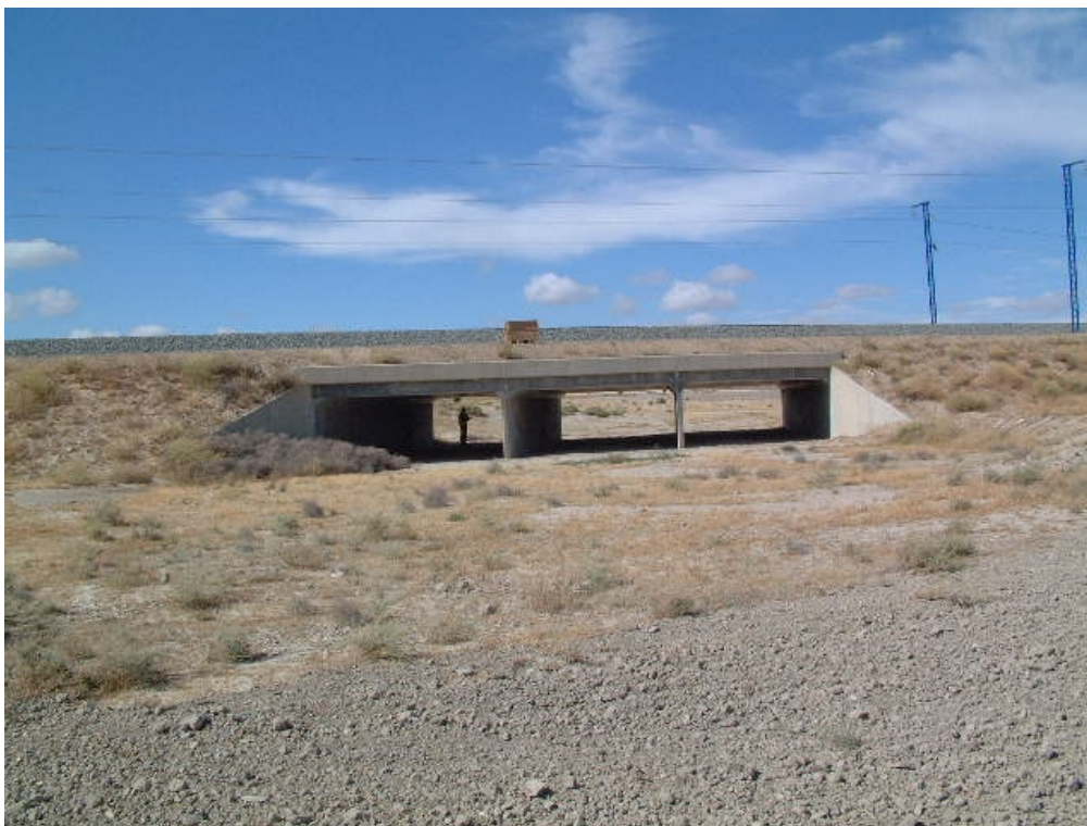
FOTOGRAFÍA 1: Vista general del puente
