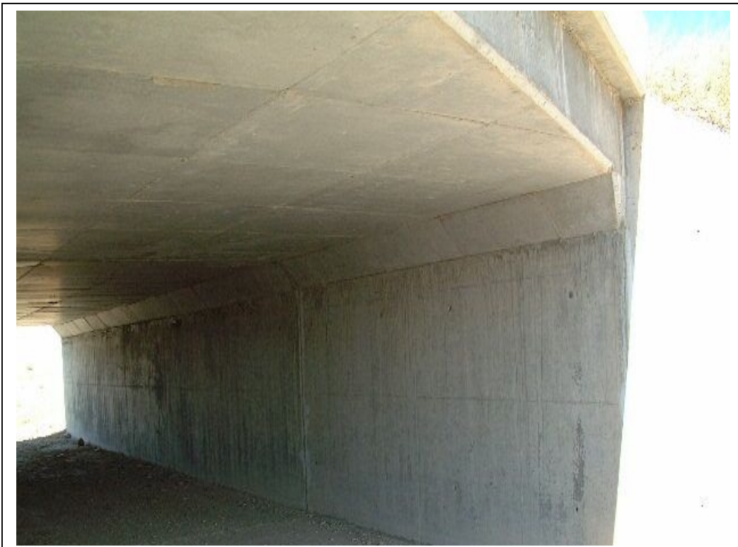
FOTOGRAFÍA Nº 6: ESTRIBO DE SALIDA
