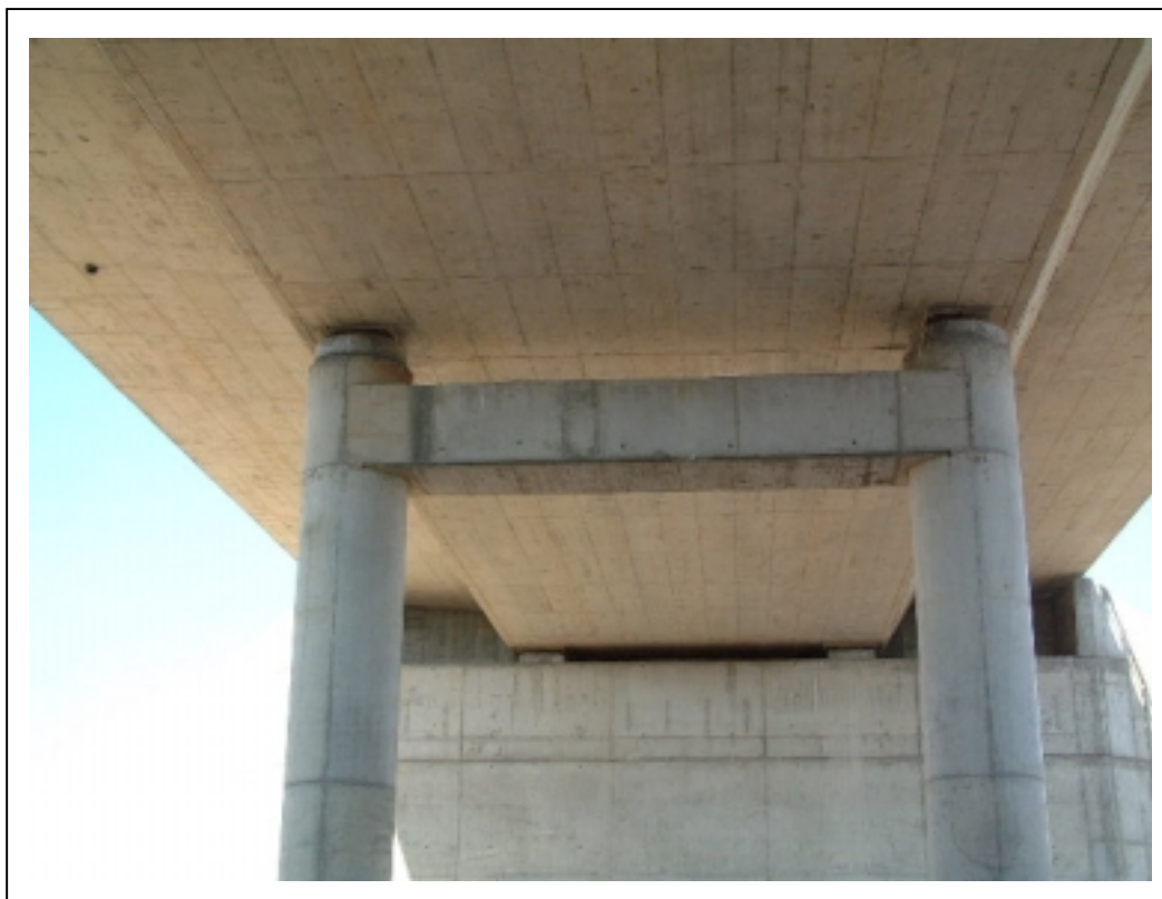
FOTOGRAFÍA 3: Vista inferior del puente
