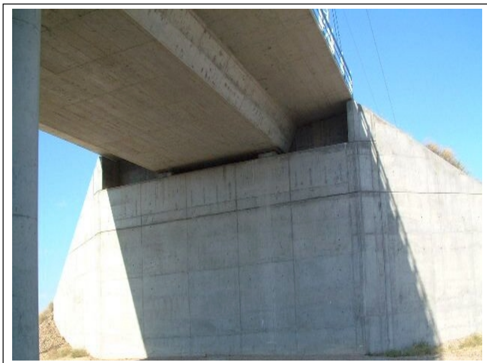
FOTOGRAFÍA Nº 6: ESTRIBO DE SALIDA
