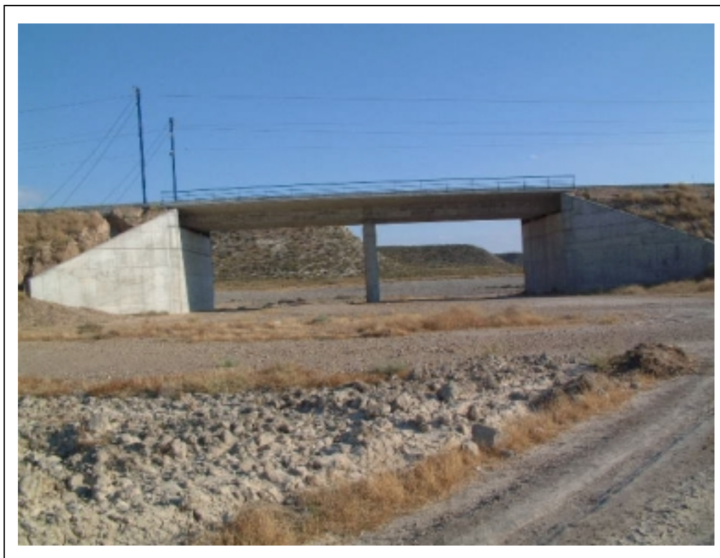
FOTOGRAFÍA 1: Vista general del puente
