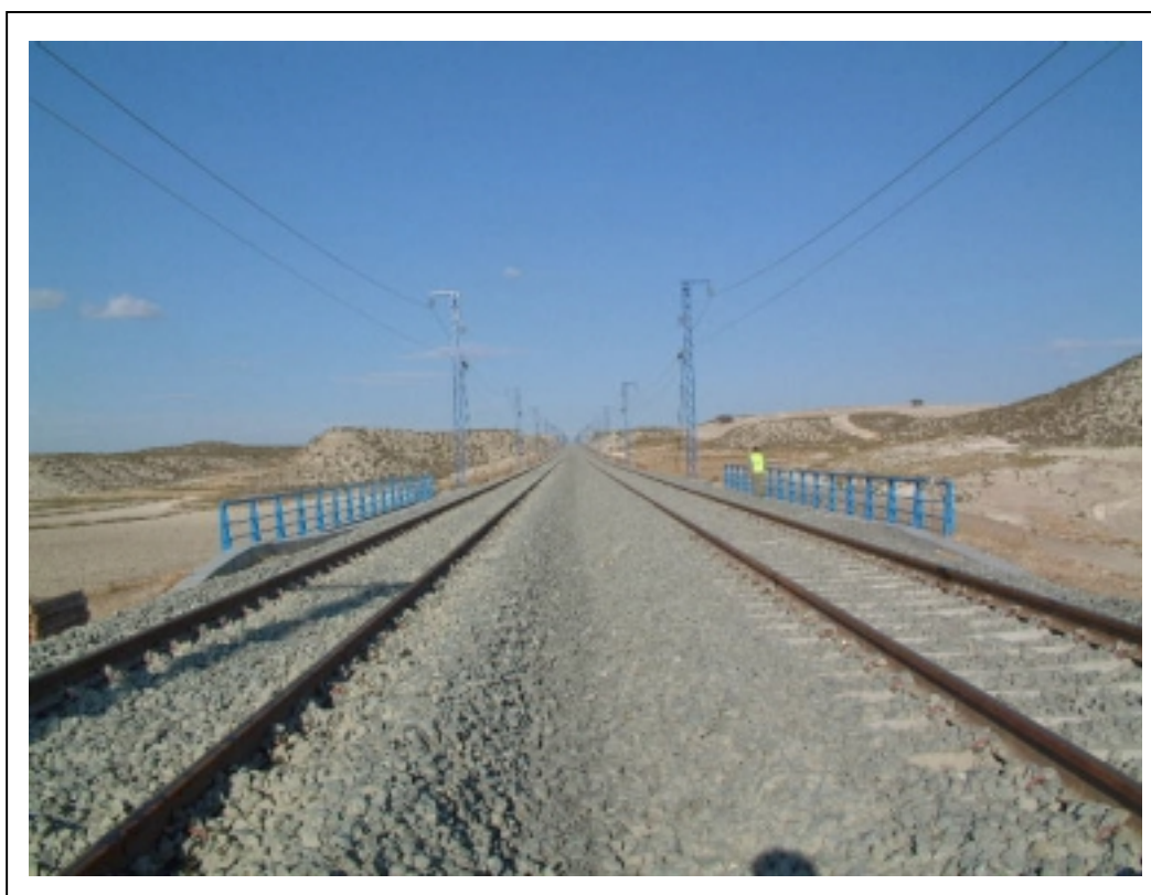
FOTOGRAFÍA 2: Vista superior del tablero
