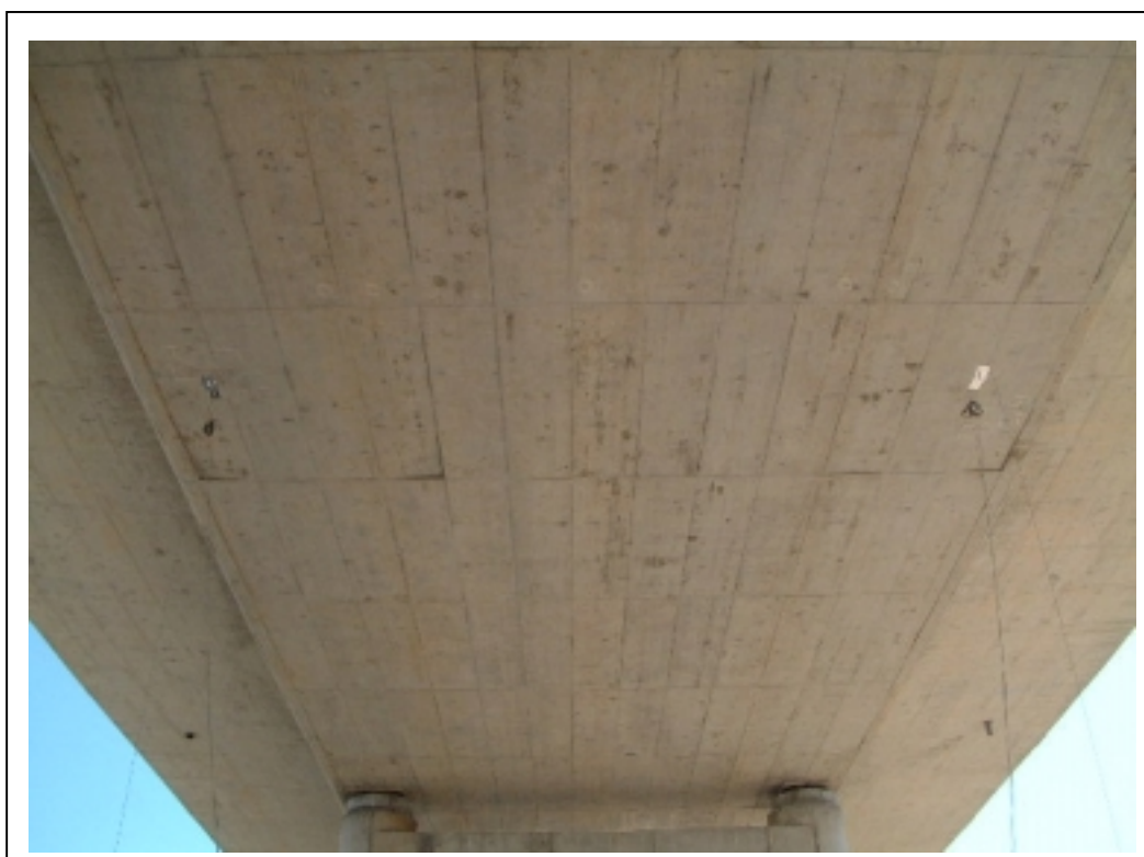
FOTOGRAFÍA 6: Instrumentación en centro de vano
