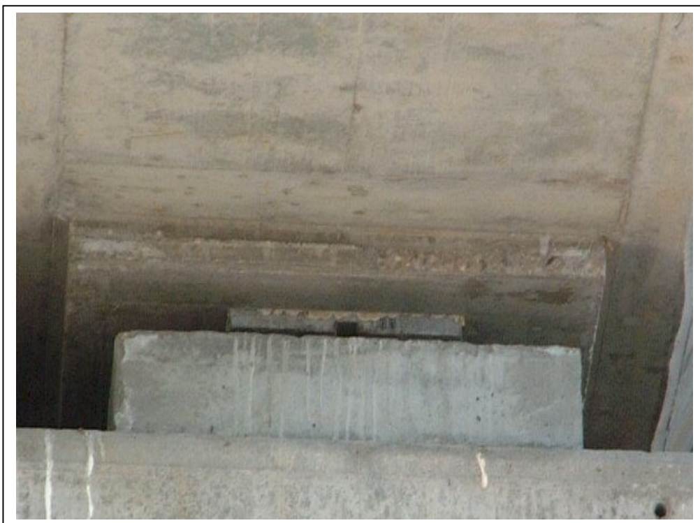
FOTOGRAFÍA N° 8: APOYO EN EL ESTRIBO FRONTAL LADO DERECHO
