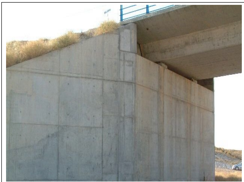
FOTOGRAFÍA Nº 5: ESTRIBO DE ENTRADA
