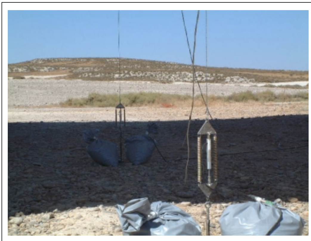
FOTOGRAFÍA 9: Instrumentación en centro de vano
