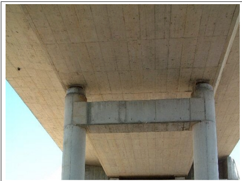
FOTOGRAFÍA N° 7: VISTA INFERIOR DESDE EL ESTRIBO DE ENTRADA
