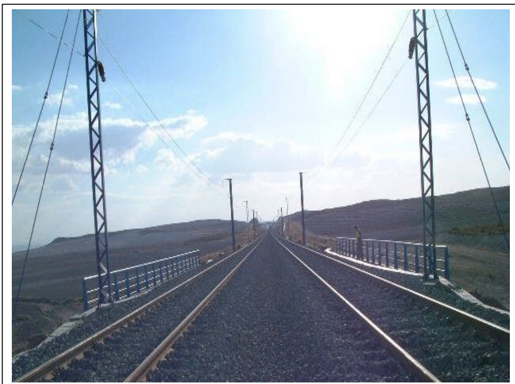
FOTOGRAFÍA Nº 4: VISTA SUPERIOR DESDE SALIDA
