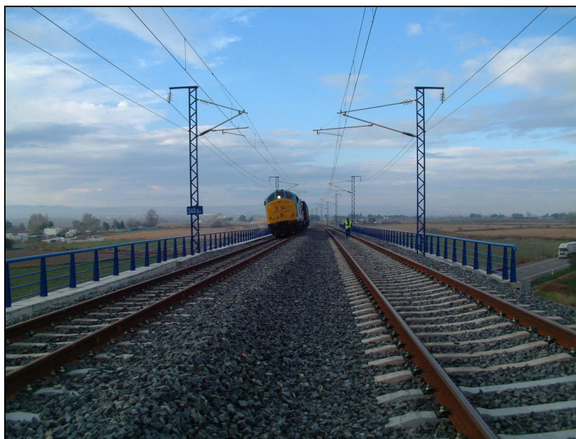
Nº 8.- Realización de las prueba dinámica lenta.
