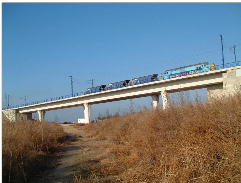
Nº 3.- Realización de las pruebas estáticas en los vanos 3 y 4.
