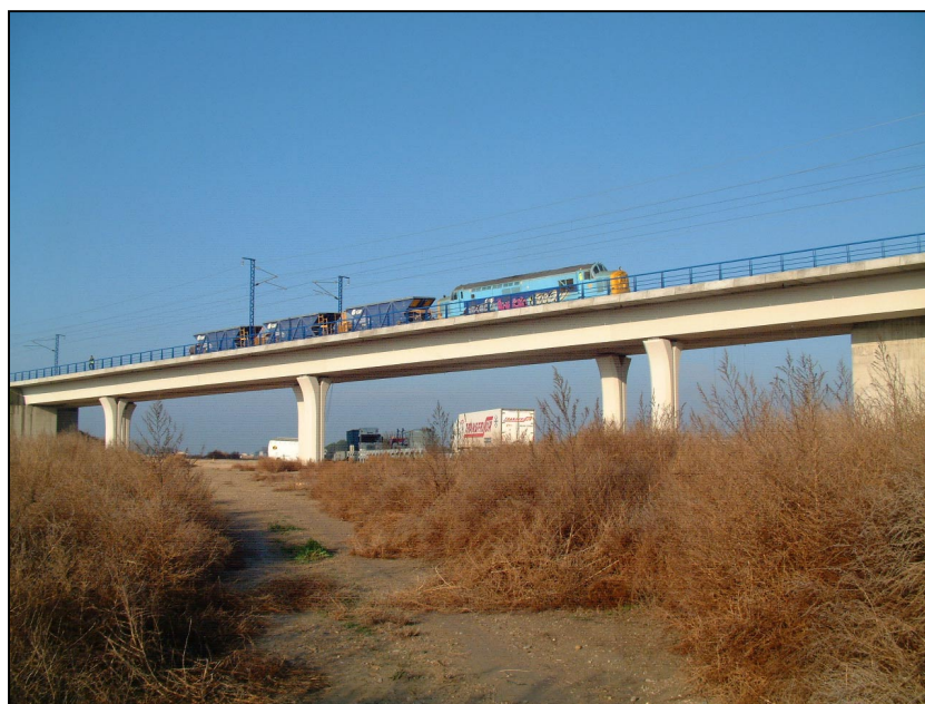
Nº 5.- Realización de las pruebas estáticas en los vanos 2 y 3.
