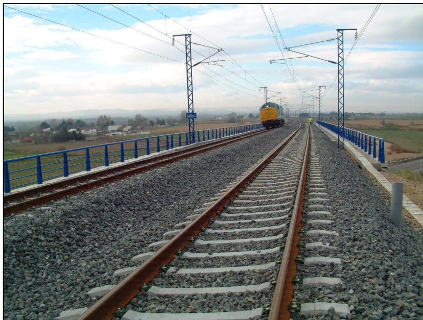
Nº 10.- Realización de la prueba dinámica a máxima velocidad.
