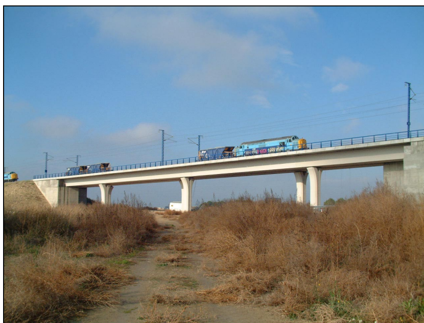
Nº 7.- Realización de las pruebas estáticas en los vanos 1 y 3.
