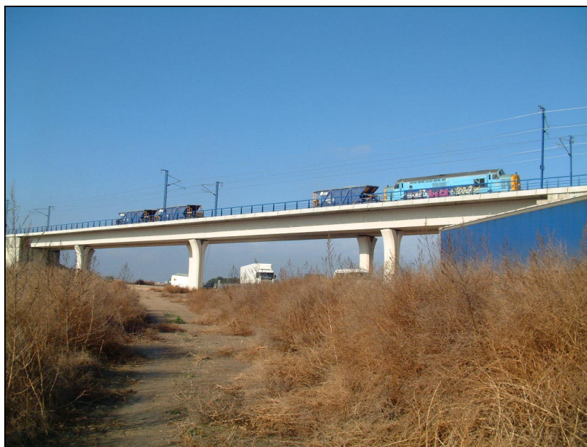
Nº 6.- Realización de las pruebas estáticas en los vanos 2 y 4.
