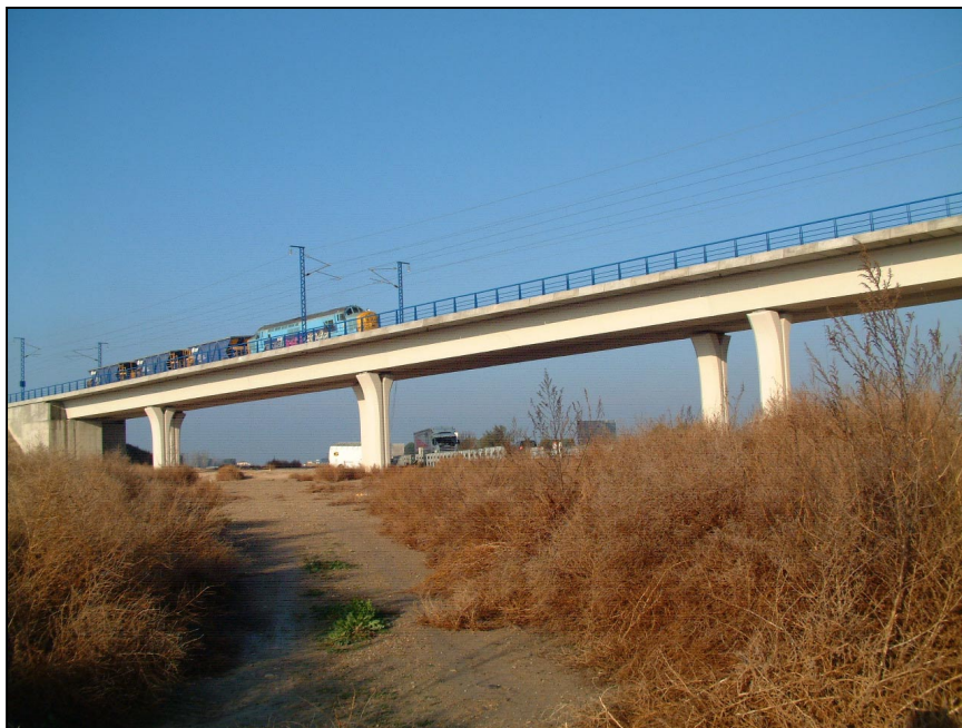
Nº 4.- Realización de las pruebas estáticas en los vanos 1 y 2.
