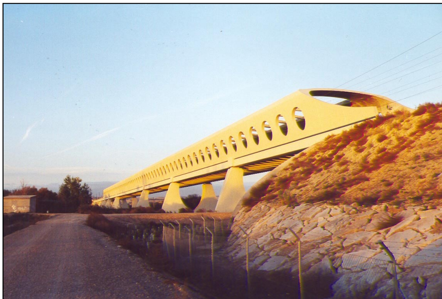
Nº 11.- Vista general de la estructura.
