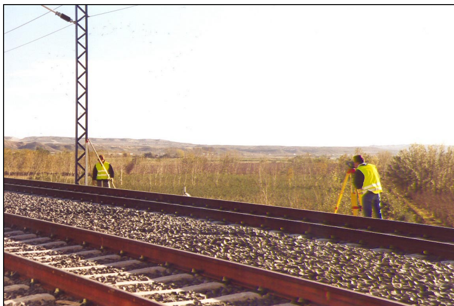
Nº 6.- Nivelación de la estructura durante las pruebas.
