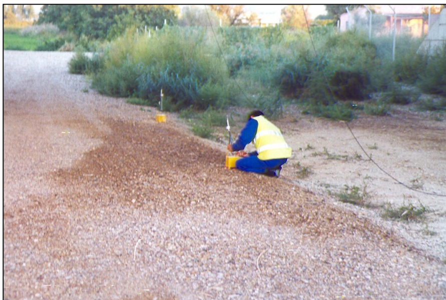
Nº 1.- Colocación de la instrumentación
