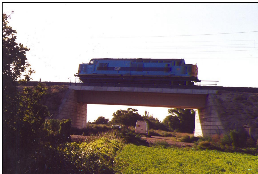
Nº 3.- Vista lateral de la estructura durante la prueba estática
