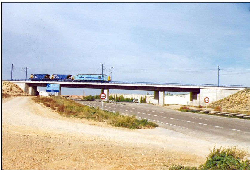
Nº 8.- Prueba de carga estática en vanos nº 1 y nº 2, con dos filas de una locomotora y dos tolvas.
