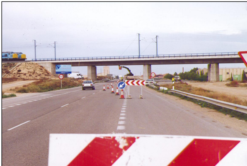
Nº 4.- Colocación de puntos de flecha en centro de luz mediante un camión grúa con cesta.
