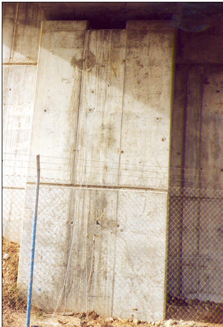
Nº 5.- Instrumentación mediante aros extensométricos de los puntos de flecha en estribo.
