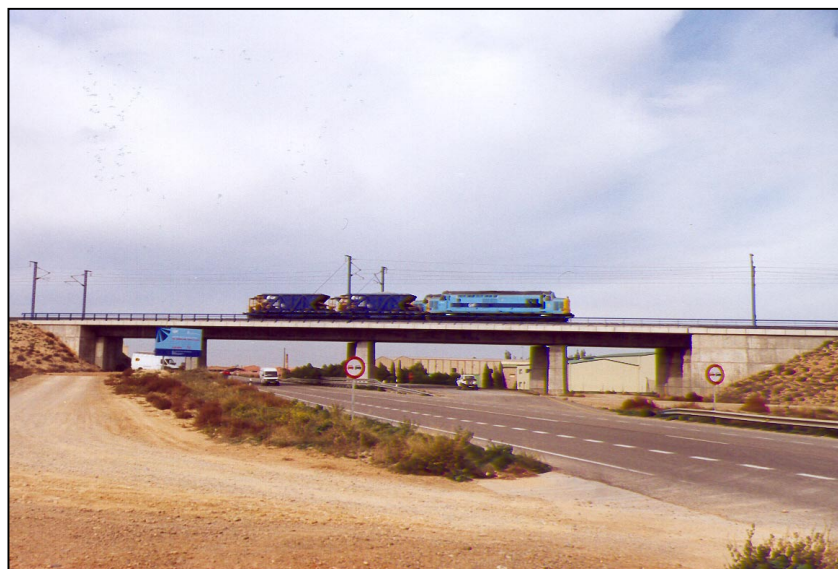
Nº 9.- Prueba de carga estática en vanos nº 2 y nº 3, con dos filas de una locomotora y dos tolvas.
