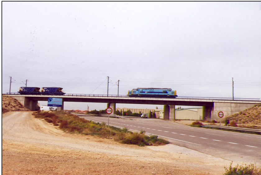
Nº 11.- Prueba de carga estática en vanos nº 1 y nº 3, con dos filas de una locomotora y dos tolvas.
