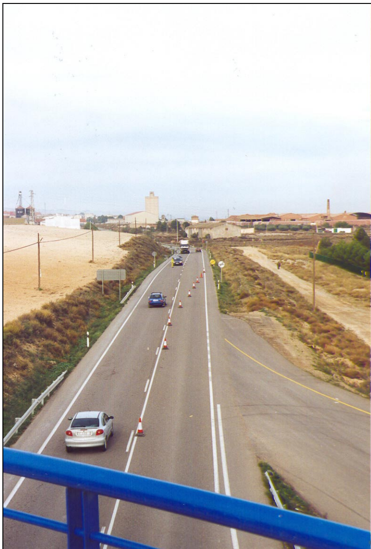
Nº 2.- Vista superior de la señalización realizada para el corte de tráfico efectuado en la N-232, sentido Zaragoza.
