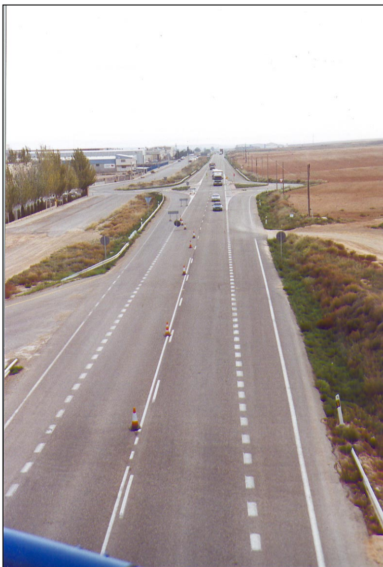
Nº 1.- Vista superior de la señalización realizada para el corte de tráfico efectuado en la N-232, dirección Alcañiz.
