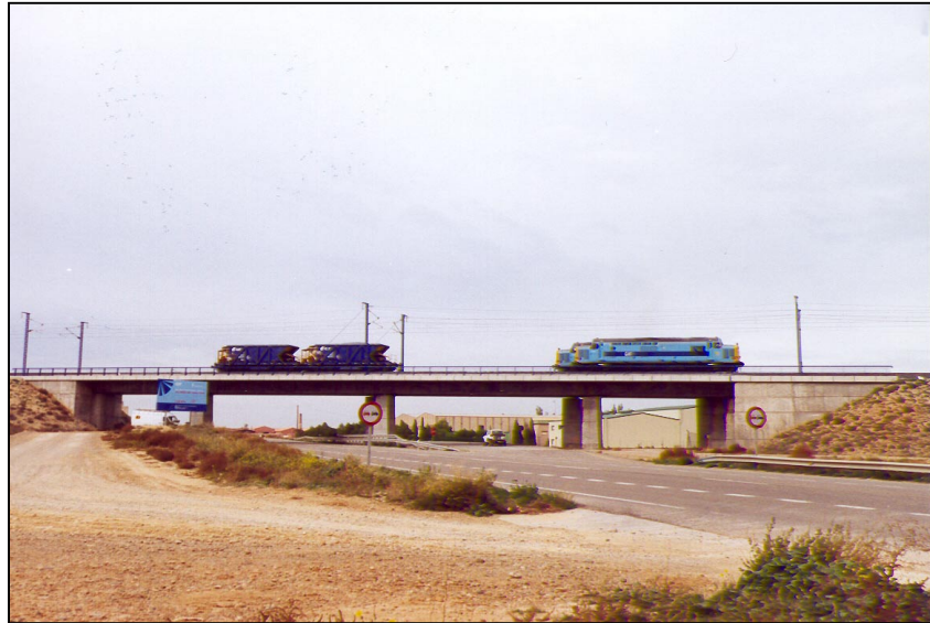
Nº 12.- Prueba de carga estática en vanos nº 2 y nº 4, con dos filas de una locomotora y dos tolvas.
