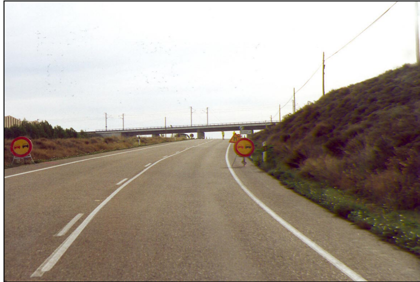
Nº 3.- Señalización realizada para el corte de tráfico efectuado en la N-232 en el carril sentido Alcañiz.
