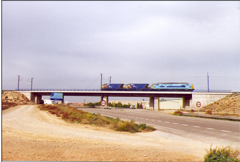
Nº 10.- Prueba de carga estática en vanos nº 3 y nº 4, con dos filas de una locomotora y dos tolvas.
