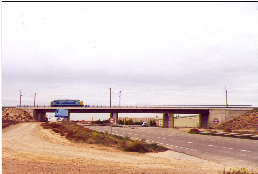
Nº 13.- Prueba de carga dinámica a 30 km/h con locomotora.
