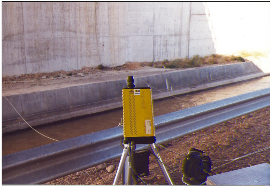
Nº 1.- Colocación de la instrumentación
