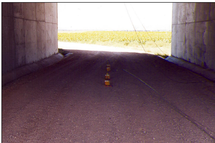
Nº 1.- Colocación de la instrumentación
