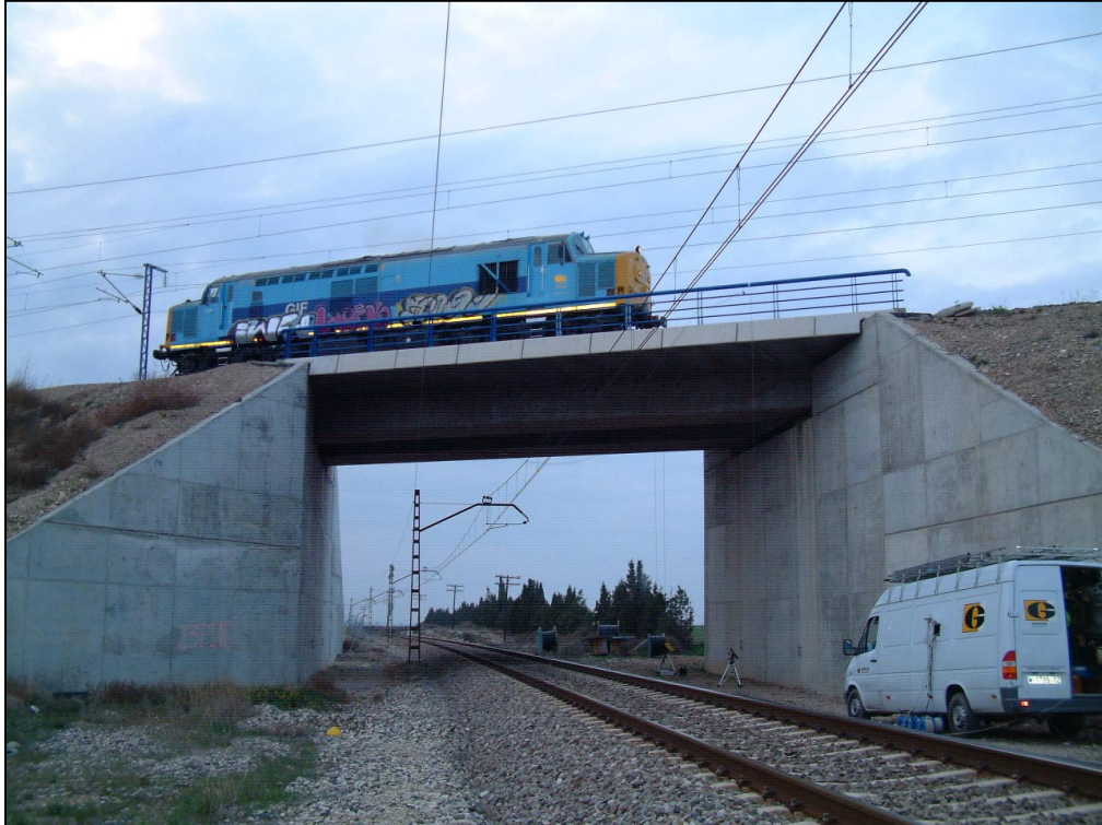
Nº 4.- Prueba de carga dinámica
