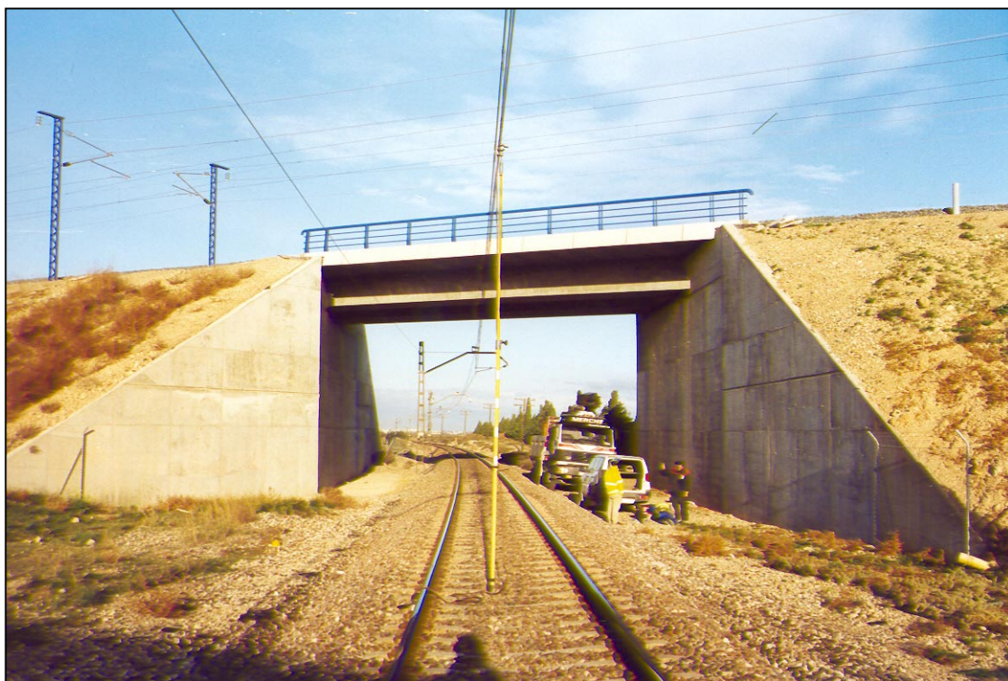
Nº 1.- Instrumentación de la estructura, con corte de tensión en catenaria
