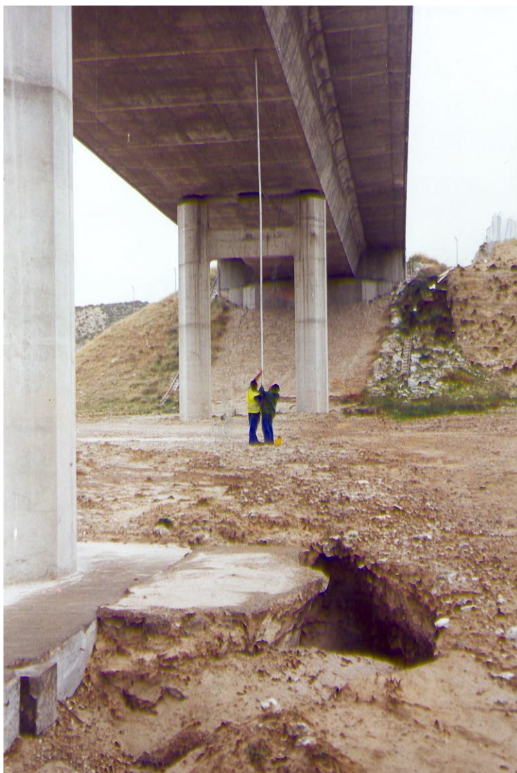
Nº 1.- Colocación de puntos de flecha en centro de luz mediante pértiga.
