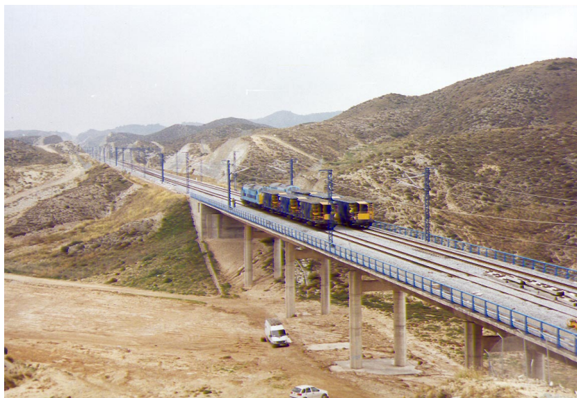
Nº 4.- Prueba de carga estática en vanos nº3 y nº4, con una locomotora y tres tolvas por vía.
