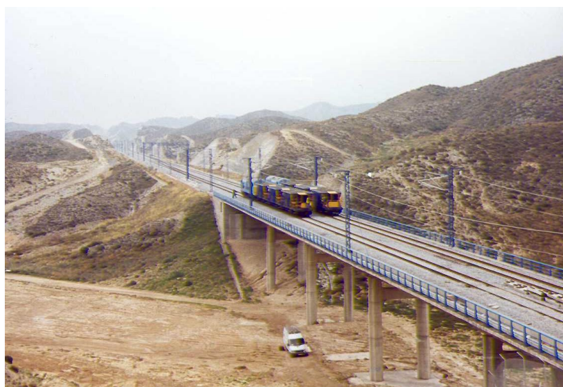
Nº 5.- Prueba de carga estática en vanos nº4 y nº5, con una locomotora y tres tolvas por vía.
