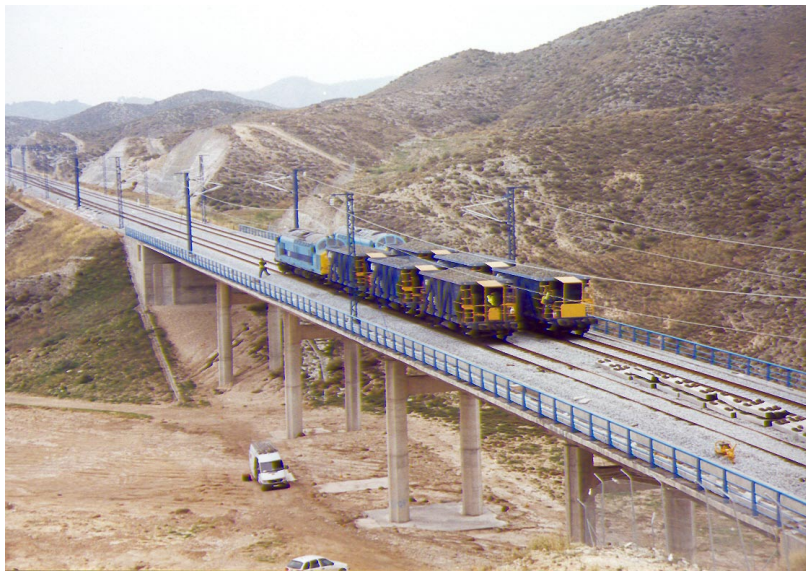
Nº 3.- Prueba de carga estática en vanos nº2 y nº3, con una locomotora y tres tolvas por vía.
