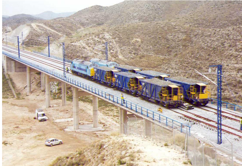
Nº 2.- Prueba de carga estática en vanos nº1 y nº2, con una locomotora y tres tolvas por vía.
