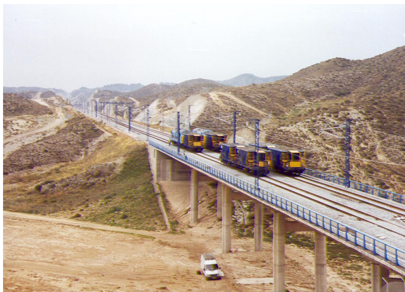
Nº 7.- Prueba de carga estática en vanos nº3 y nº5, con una locomotora y tres tolvas por vía.
