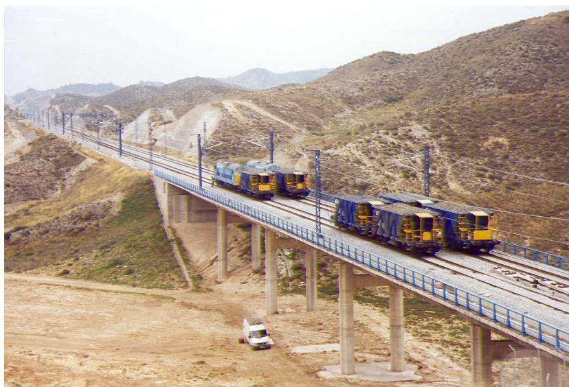
Nº 6.- Prueba de carga estática en vanos nº2 y nº4, con una locomotora y tres tolvas por vía.
