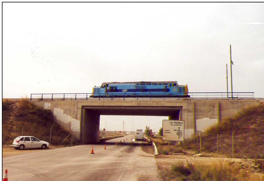
Nº 2.- Realización de la prueba estática
