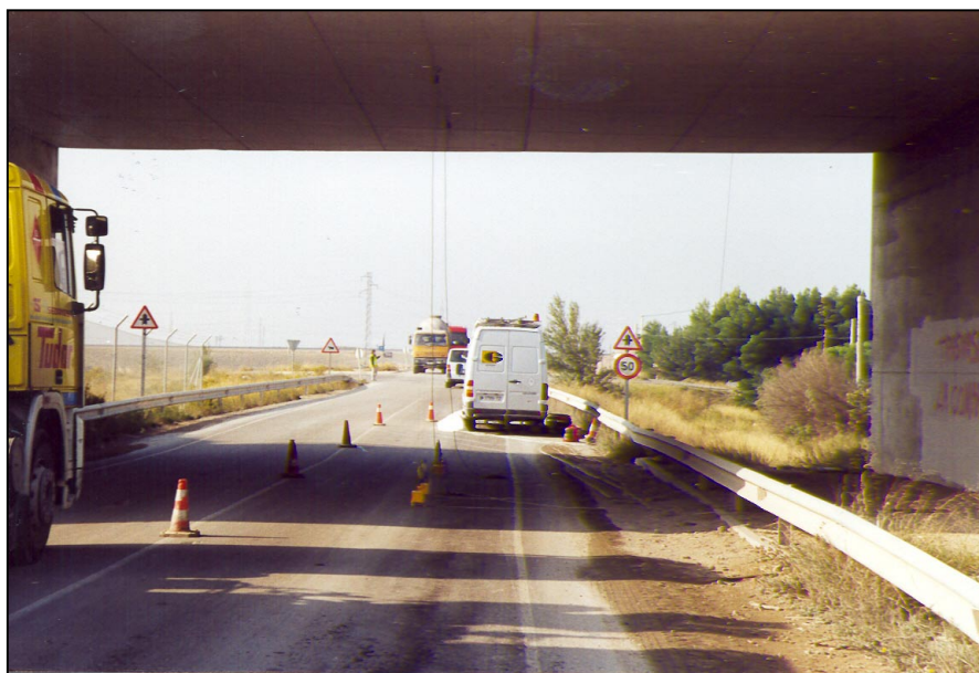
Nº 1.- Colocación de la instrumentación y corte de tráfico
