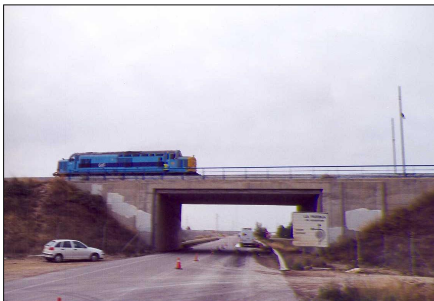
Nº 3.- Realización de las prueba dinámica lenta.
