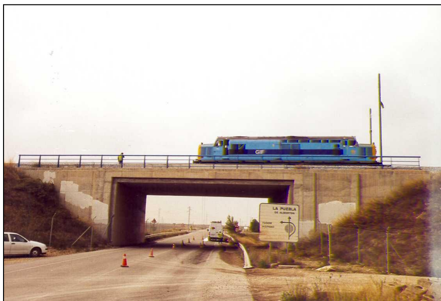
Nº 4.- Realización de la prueba dinámica a 30 Km/h.
