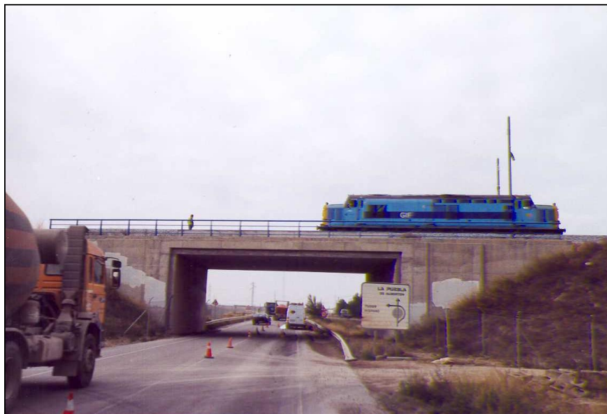
Nº 6.- Realización de la prueba dinámicode frenado.
