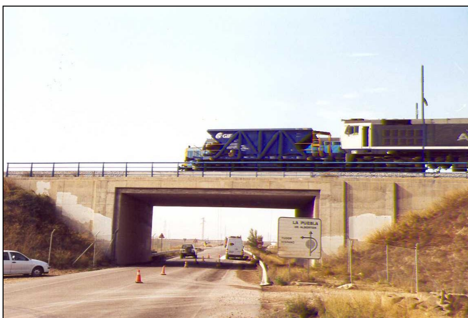
Nº 7: Vista de las sobrecargas empleadas en la prueba estática.
