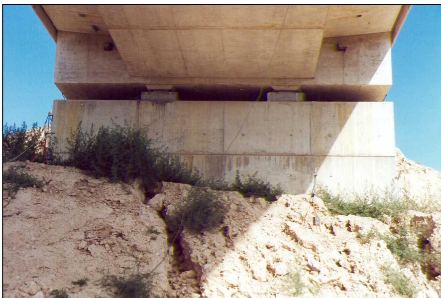
Nº 4.- Instrumentación con LVDT's en vano nº 3.
