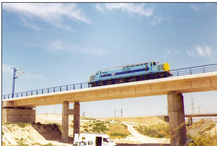
Nº 9.- Prueba de carga dinámica a 30 km/h con locomotora.
