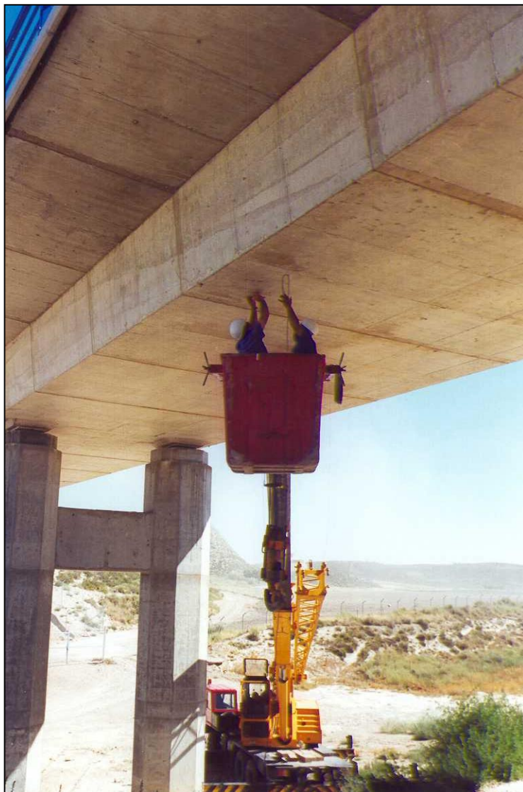
Nº 2.- Colocación de puntos de flecha en centro de luz del vano nº 1 mediante un camión grúa con cesta.
