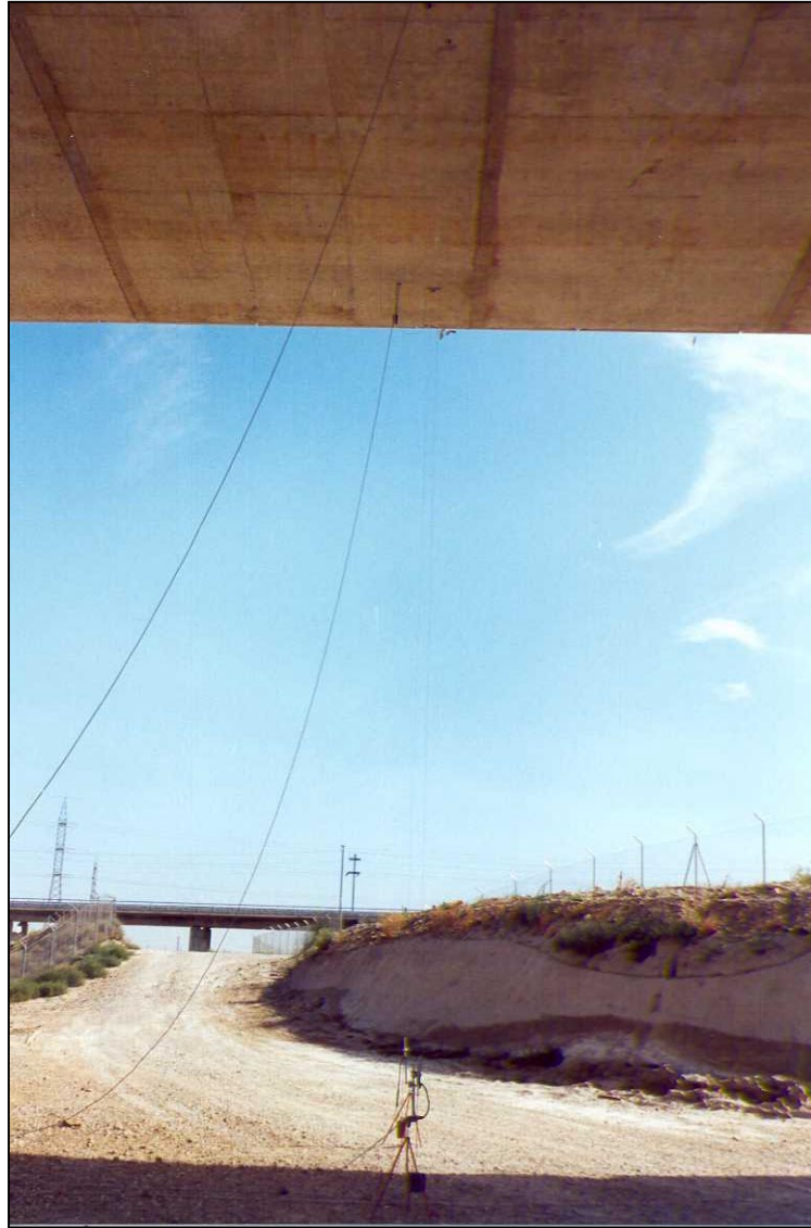
Nº 5.- Instrumentación con LVDT's en vano nº 2.
