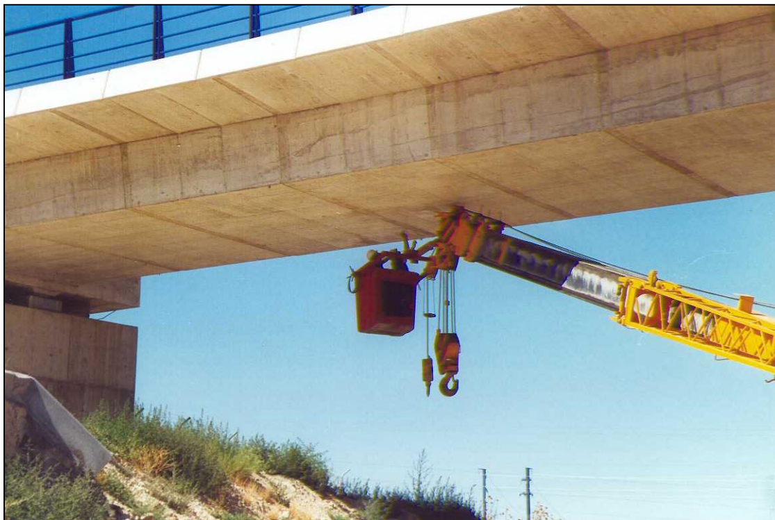
Nº 1.- Colocación de puntos de flecha en centro de luz del vano nº 1 mediante un camión grúa con cesta.
