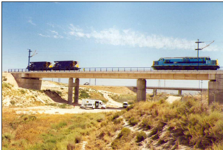
Nº 8.- Prueba de carga estática en vanos nº 1 y nº 3, con una fila de una locomotora y dos tolvas, visto desde el lado derecho de la estructura.
