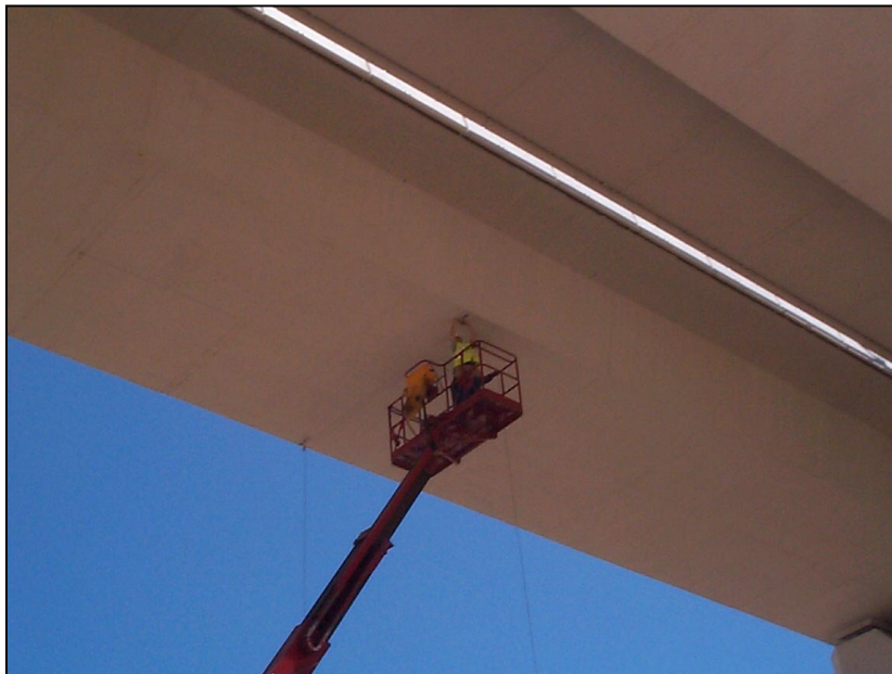
Nº 1.- Colocación de instrumentación en centro de vano
