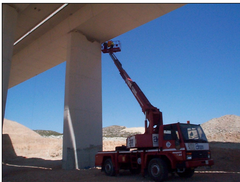
Nº 2.- Colocación de instrumentación en apoyos
