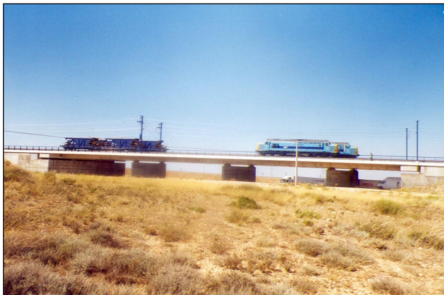
Nº 6.- Prueba de carga estática en vanos nº 3 y nº 4, con dos filas de una locomotora y dos tolvas cada una, visto desde el lado Madrid.
