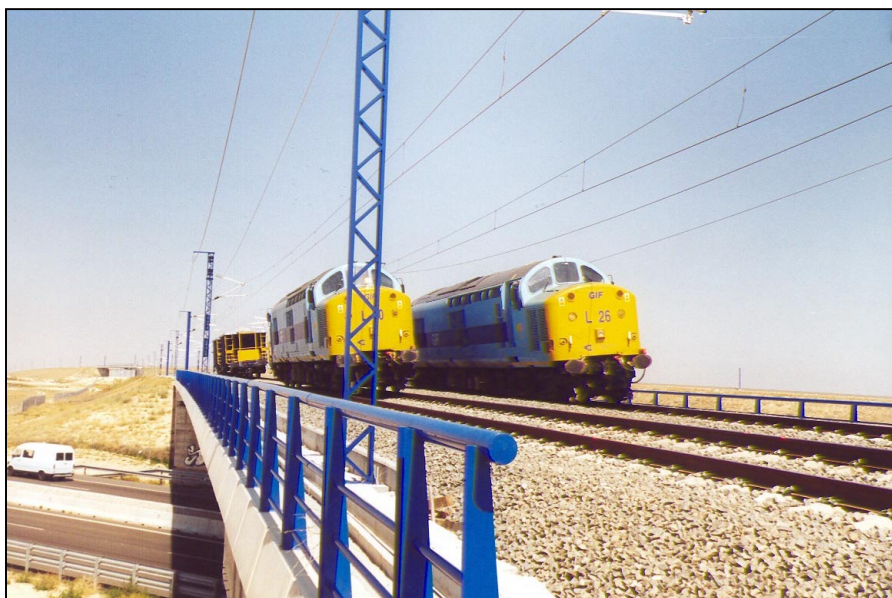
Nº 9.- Vista superior de la Prueba de carga estática en vanos nº 1 y nº 3, con dos filas de una locomotora y dos tolvas cada una, visto desde el lado de Lerida.
