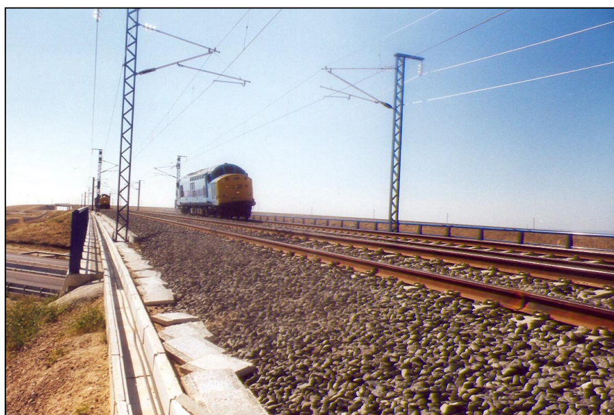
Nº 11.- Prueba de carga dinámica a 30 km/h con locomotora.
