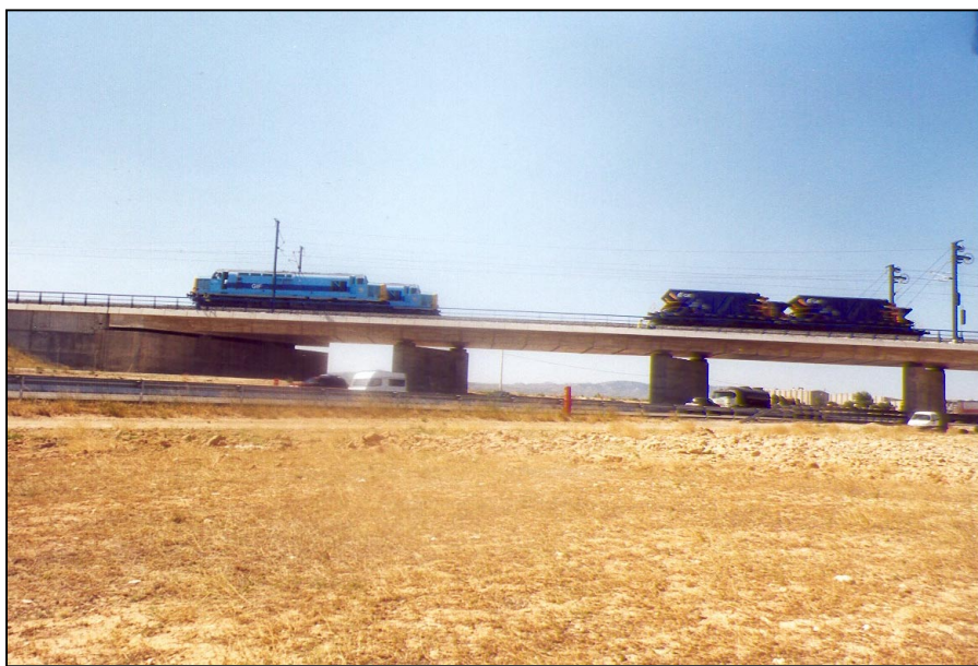
Nº 10.- Prueba de carga estática en vanos nº 2 y nº 4, con dos filas de una locomotora y dos tolvas cada una, visto desde el lado de Zaragoza.
