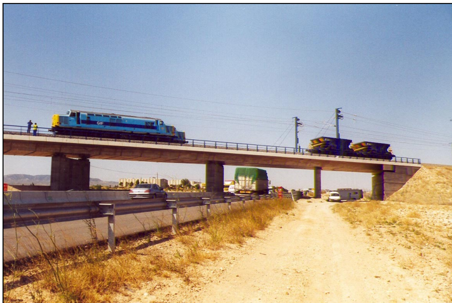
Nº 8.- Prueba de carga estática en vanos nº 1 y nº 3, con dos filas de una locomotora y dos tolvas cada una, visto desde el lado de Zaragoza.
