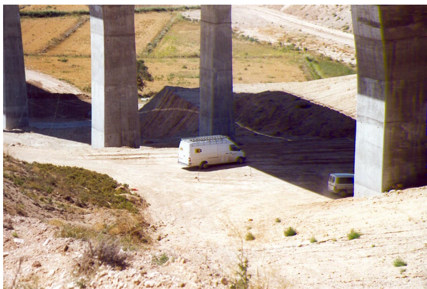
Nº 2.- Instrumentación con LVDT's en vano nº 17.
