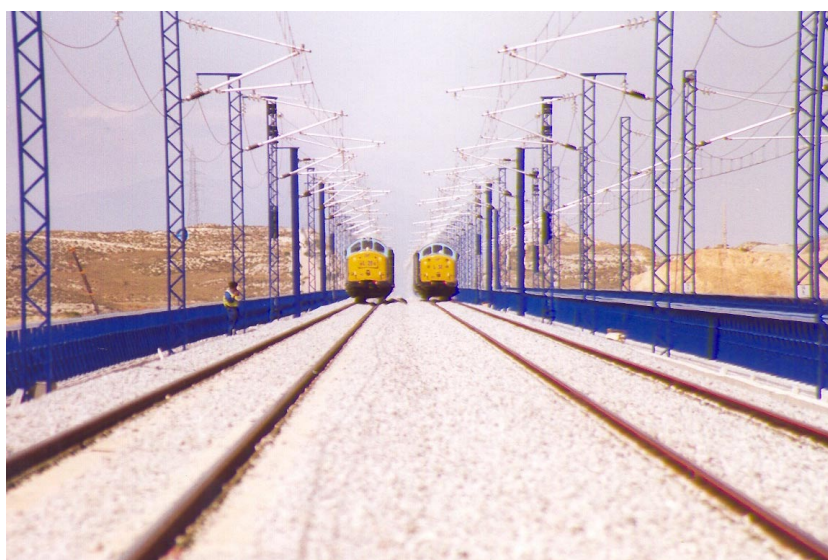
Nº 8.- Vista superior de la Prueba de carga estática en vanos nº 16 y nº 17, con dos filas de una locomotora y siete tolvas cada una, desde el lado Lérída.
