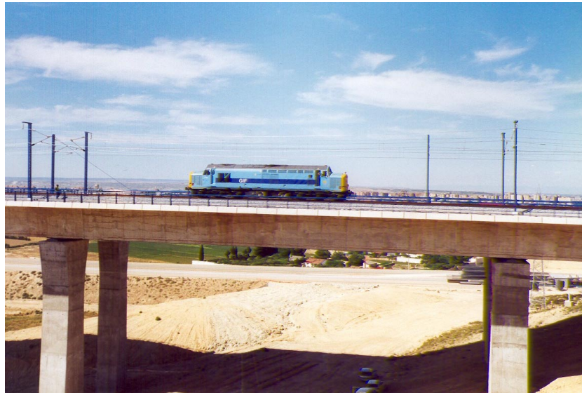
Nº 9.- Prueba de carga dinámica a 30 km/h con locomotora perteneciente al grupo 6.
