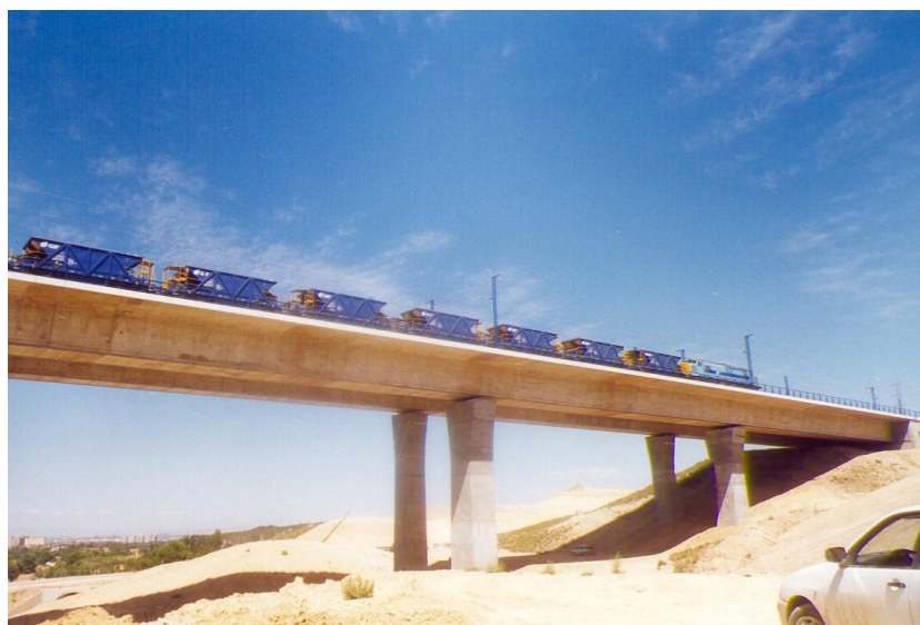
Nº 7.- Prueba de carga estática en vanos nº 16 y nº 17, con dos filas de una locomotora y siete tolvas cada una.
