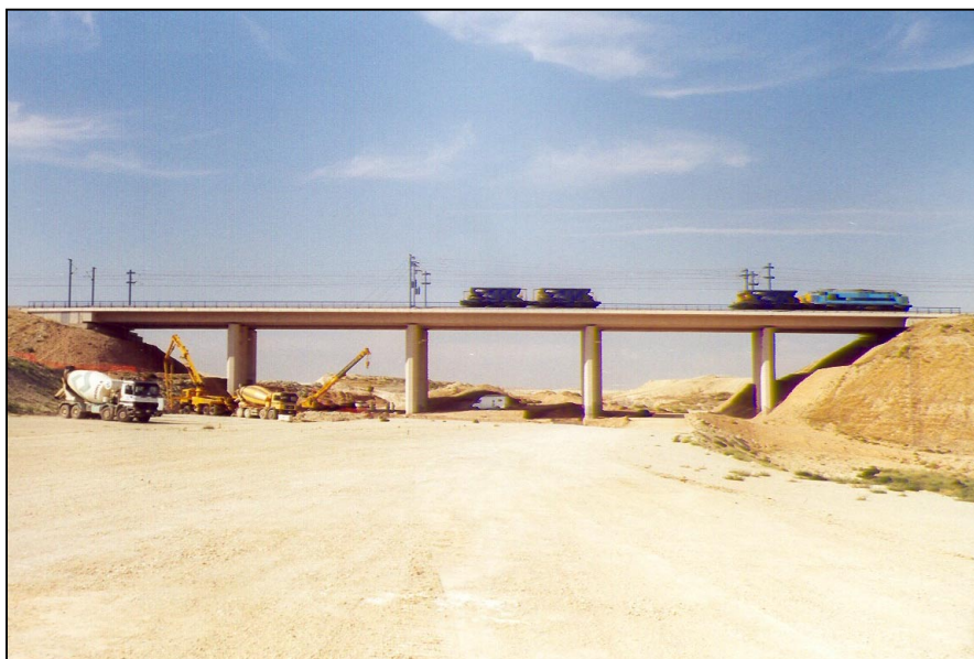
Nº 4.- Prueba de carga estática en vanos nº 1 y nº 3, con dos filas de una locomotora y dos tolvas cada una, visto desde el lado de Madrid.
