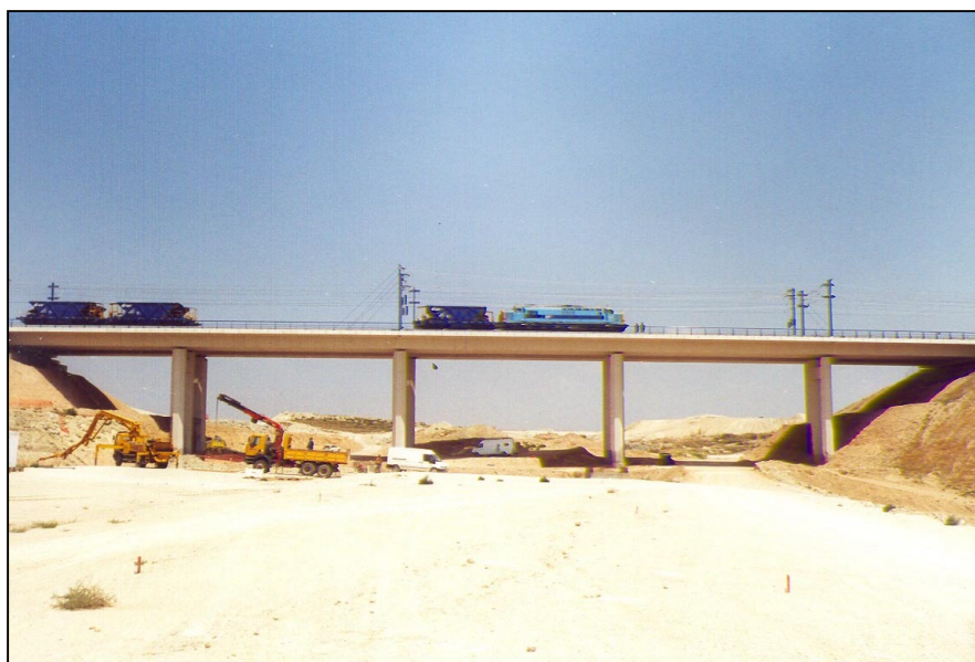
Nº 5.- Prueba de carga estática en vanos nº 1 y nº 5, con dos filas de una locomotora y dos tolvas cada una, visto desde el lado de Madrid.
