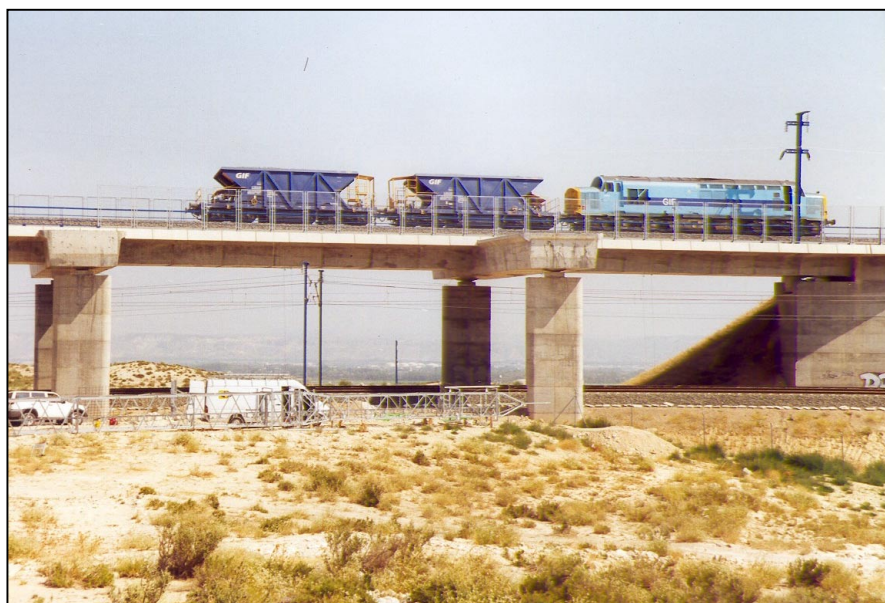
Nº 2.- Prueba de carga estática en vanos nº 2 y nº 3, con dos filas de una locomotora y dos tolvas cada una, visto desde el lado de Madrid.
