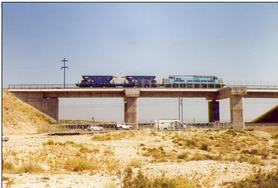
Nº 1.- Prueba de carga estática en vanos nº 1 y nº 2, con dos filas de una locomotora y dos tolvas cada una, visto desde el lado de Madrid.
