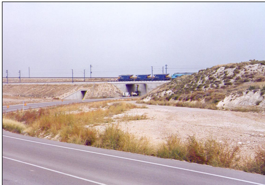
Nº 6.- Vista general del corte de tráfico durante el paso de un tren.
