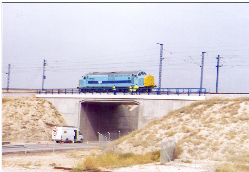
Nº 2.- Realización de la prueba estática
