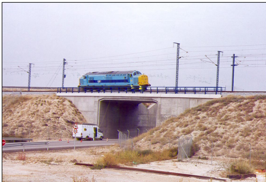
Nº 3.- Realización de las prueba dinámica lenta.
