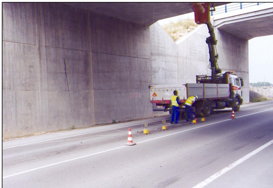
Nº 1.- Colocación de la instrumentación
