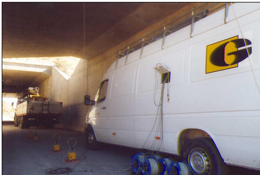
Nº 1.- Colocación de la instrumentación
