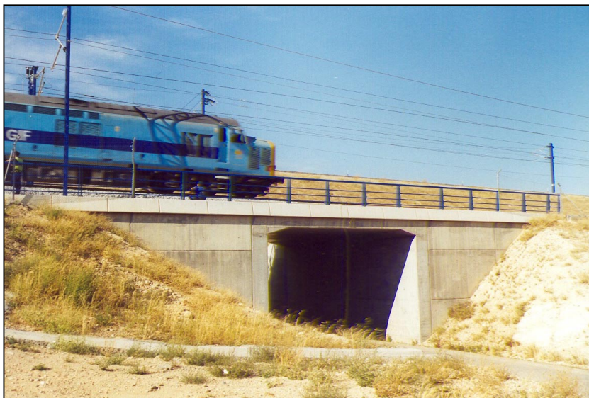
Nº 2.- Realización de las pruebas estáticas.
