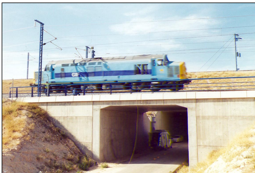
Nº 3.- Realización de las pruebas dinámicas lentas.
