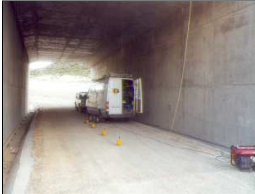
Nº 2.- Colocación de la instrumentación.
