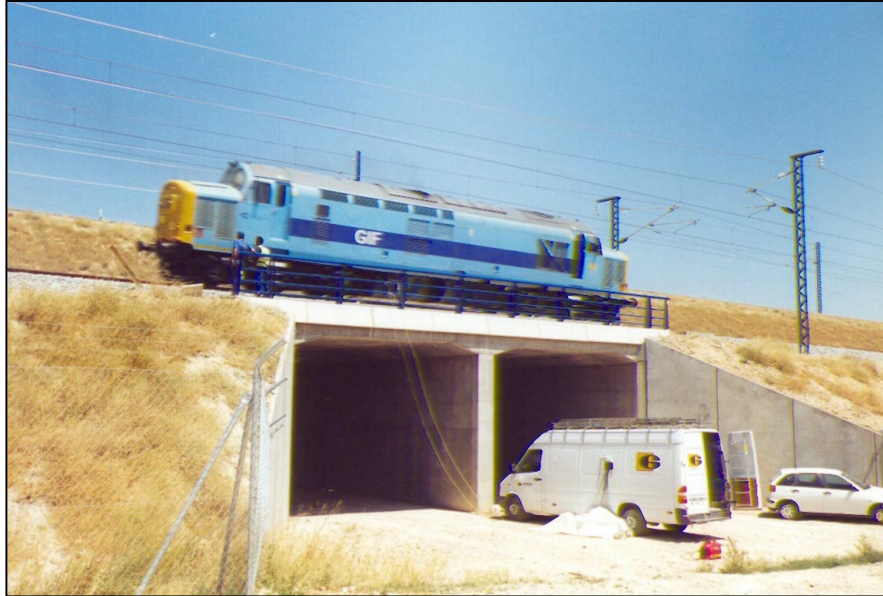
Nº 2.- Realización de las pruebas estáticas
