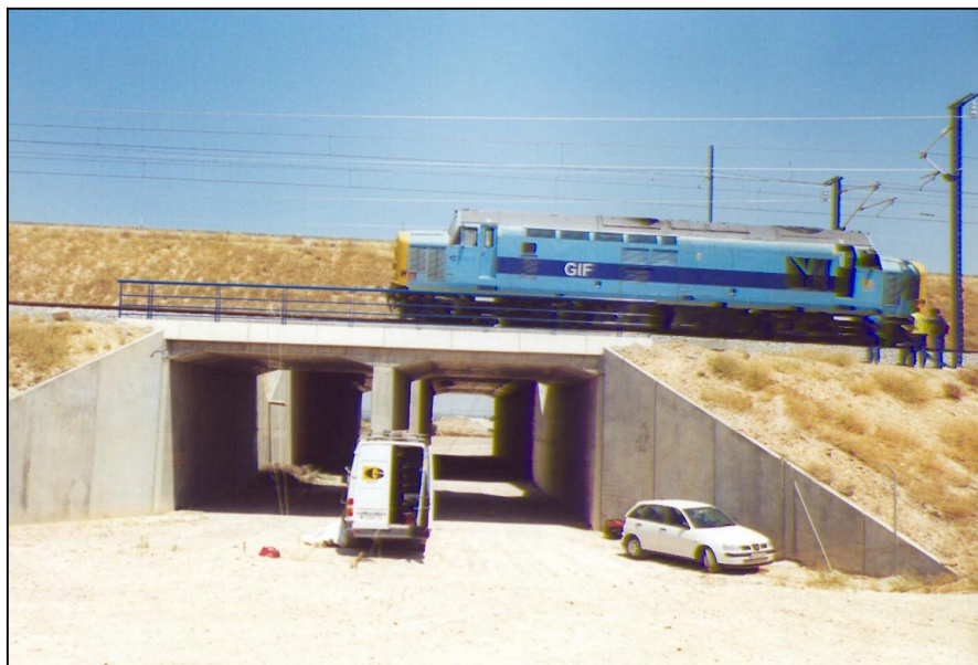
Nº 3.- Realización de las pruebas dinámicas lentas.
