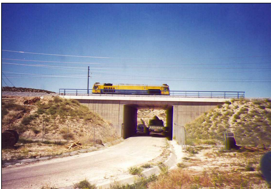
Nº 3. - Realización de la prueba dinámica lenta.
