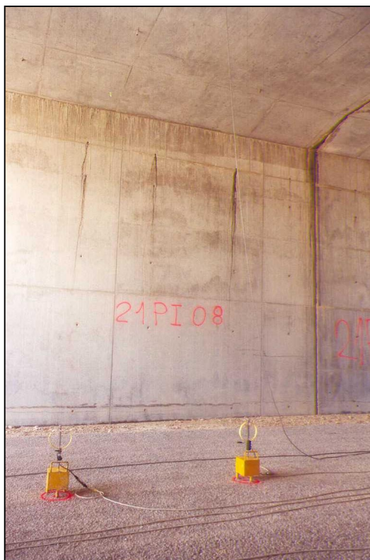
Nº 1.- Colocación de la instrumentación.
