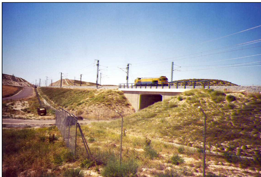
Nº 4.- Realización de la prueba dinámica a máxima velocidad.
