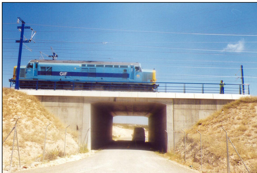
Nº 4.- Realización de las pruebas dinámicas lentas.
