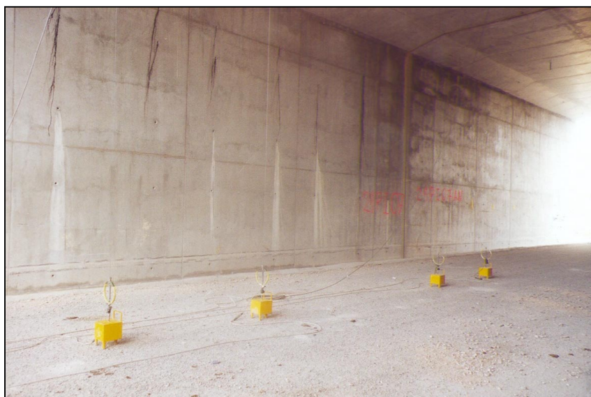
Nº 2.- Colocación de los aparatos de medida.
